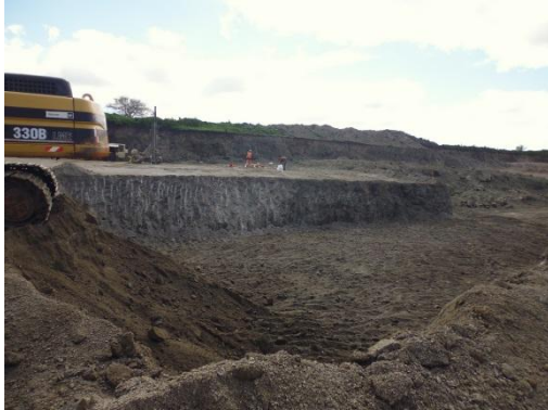
Ilustración 4 – Preparación de explosivos en la cantera de tosca granítica.
