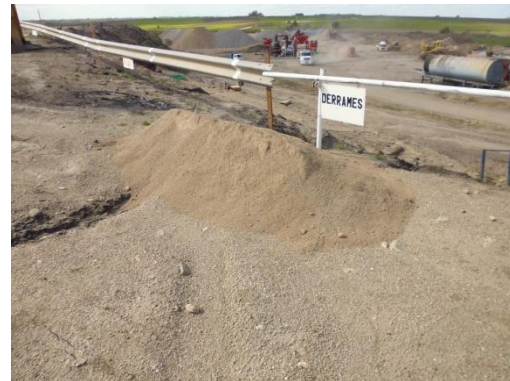
Ilustración 7 – Arena para derrames en la zona de cantera.
