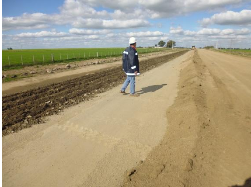
Ilustración 10 – Frente de obra.
