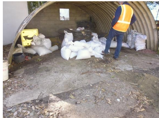
Ilustración 13 – Acopio de señalización en el obrador.
