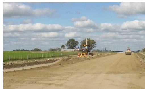
Ilustración 9 – Frente de obra.
