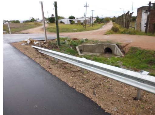
Ilustración 15 – Alcantarillas mejoradas.
