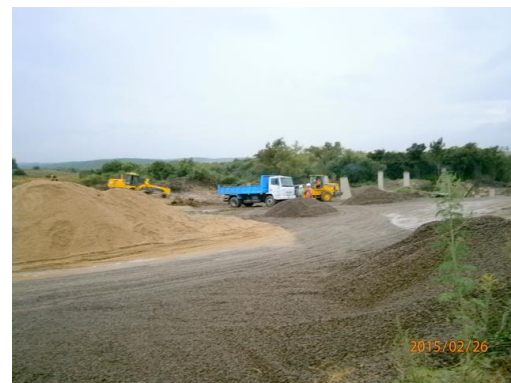
Ilustración 14-Frente de obra y acopios
