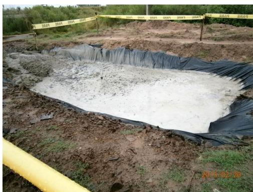
Ilustración 9-Primera pileta en serie para el lavado de mixers
