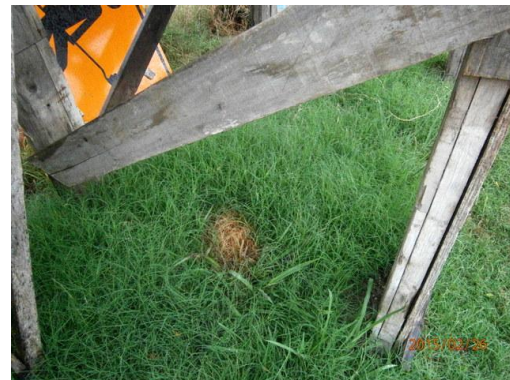
Ilustración 8-Zona debajo del tanque de almacenamiento de gasoil con posible goteo
