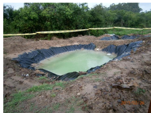
Ilustración 10-Segunda pileta en serie para el lavado de mixers
