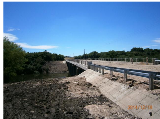
Ilustración 7- Acceso norte al nuevo puente
