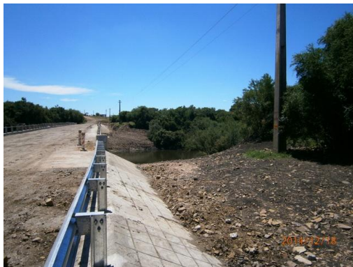
Ilustración 6- Acceso norte al nuevo puente
