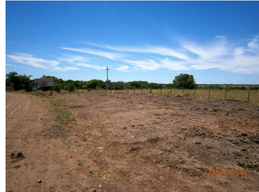
Ilustración 5- Acceso norte al nuevo puente
