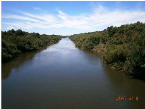
Ilustración 10-Vista sobre el nuevo puente hacia el oeste del río Queguay Grande
