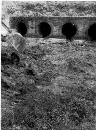
trabajos de limpieza de alcantarillas y cauces
