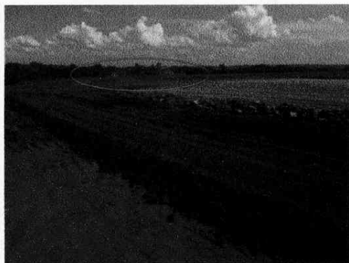
acopio de suelo para futura restitución
