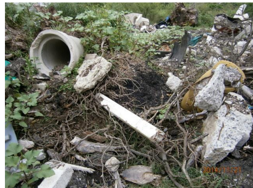
Ilustración 19-Escobros y residuos varios en obrador
