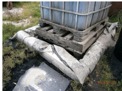
Ilustración 15-Almacenamiento de hidrocarburos de la cámara separadora
