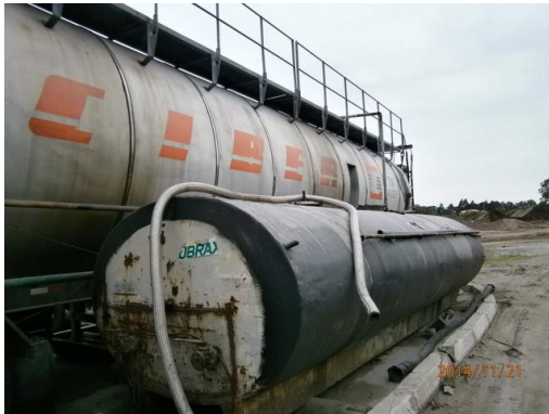
Ilustración 22-Sistema de contención en planta asfáltica
