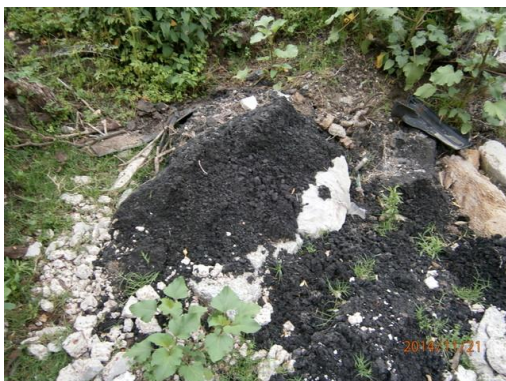
Ilustración 20-Escobros y residuos varios en obrador
