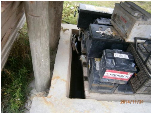
Ilustración 16-Almacenamiento de baterías usadas
