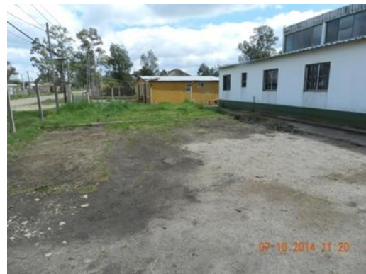
Ilustración 15: Obrador y casas habitadas en sus proximidades
