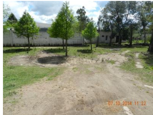
Ilustración 13: Obrador con suelo nivelado de conformidad al dueño del predio
