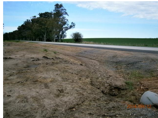
Ilustración 11-Ingreso al obrador y alcantarilla sobre el frente de obra
