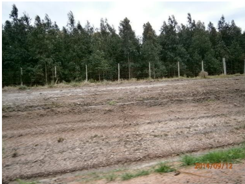
Ilustración 10: Frente de obra
