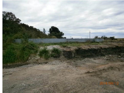
Ilustración 6: Obrador con tanque australiano
