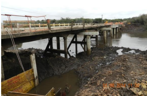
Ilustración 9: Puente nuevo en construcción y remanentes del antiguo puente
