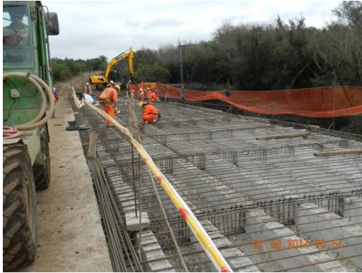
Ilustración 5: Frente de obra
