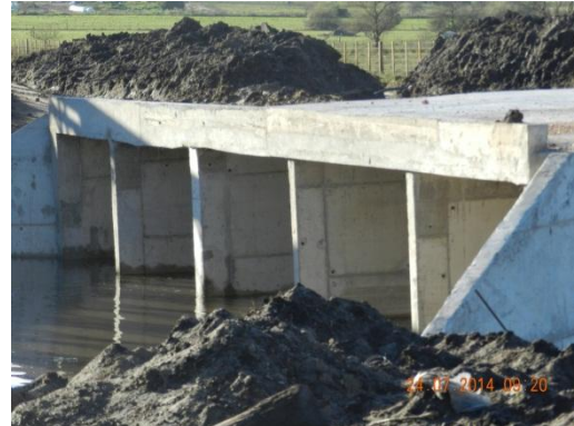
Ilustración 6: Alcantarilla tipo H de 5 bocas en construcción.
