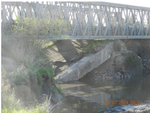
Ilustración 7: Puente Bailey sobre el antiguo puente caído.
