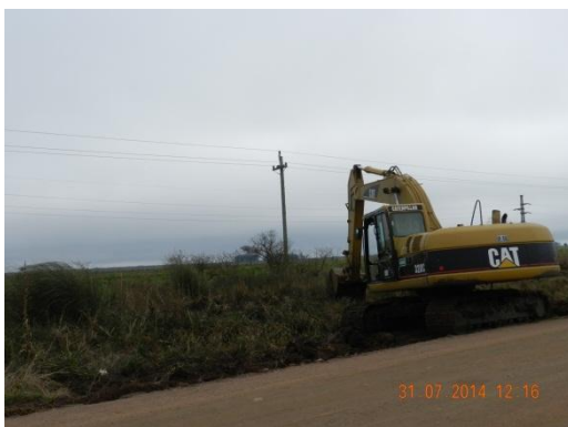
Ilustración 9: Limpieza de cunetas
