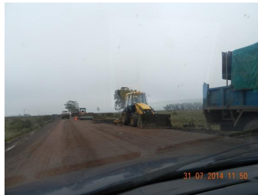
Ilustración 8: Bacheo profundo previo a la recarga con tosca
