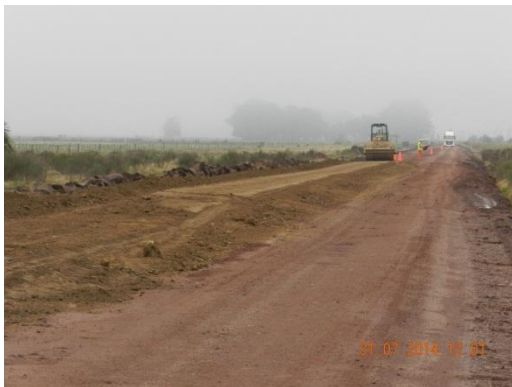
Ilustración 7: Recarga y compactación de tosca
