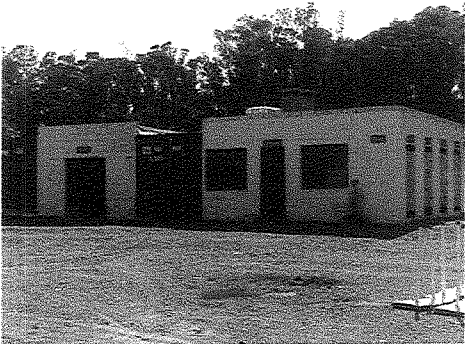
instalaciones: depósito, comedor y baños
