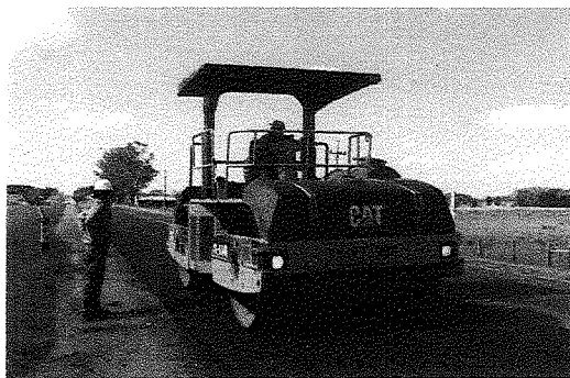
compactador frente de la cantera de piedra
