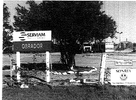
acceso al obrador con señalización y forestación
