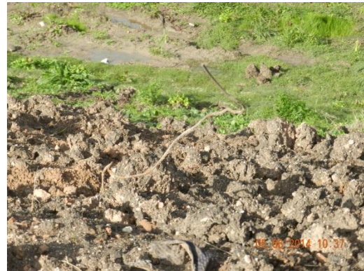
Ilustración 18: Hierros y escombros en el talud en terraplén
