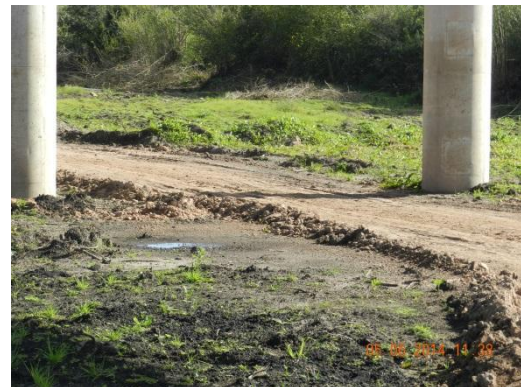
Ilustración 8: Camino de servicio debajo del puente del lado de San José
