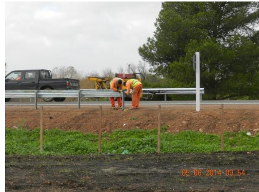
Ilustración 24: Frente de obra en progresiva 81K520 a (-)
