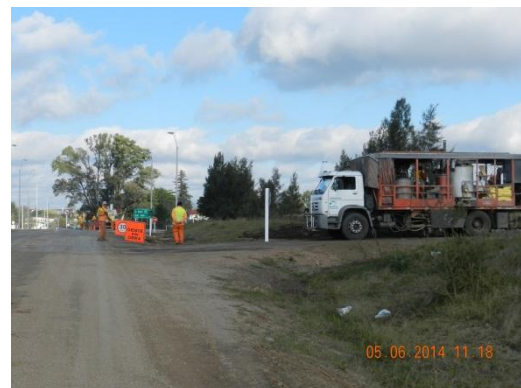
Ilustración 10: Frente de obra en progresiva 84K600
