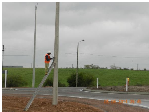
Ilustración 27: Frente de obra en progresiva 81K376 a (+)
