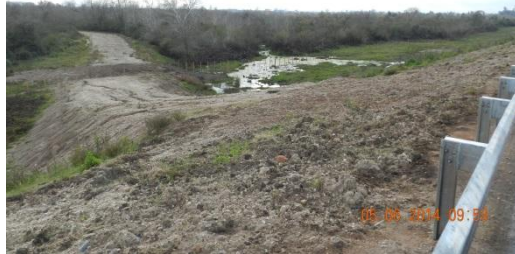
Ilustración 23: Camino de servicio para acceder a la cantera de limo interrumpido por 2 alambrados en progresiva 82K110 a (-)
