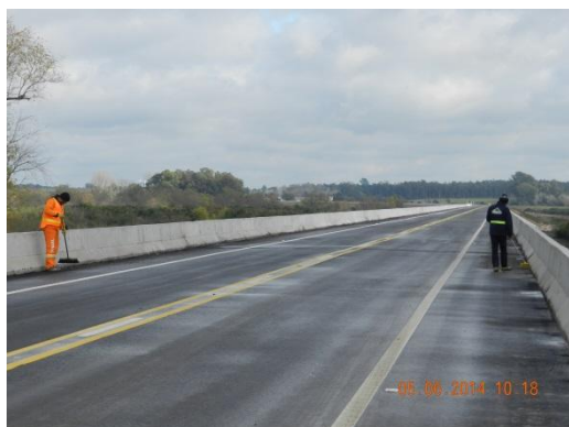
Ilustración 21: Frente de obra en progresiva 83K330 a (+) y a (-)
