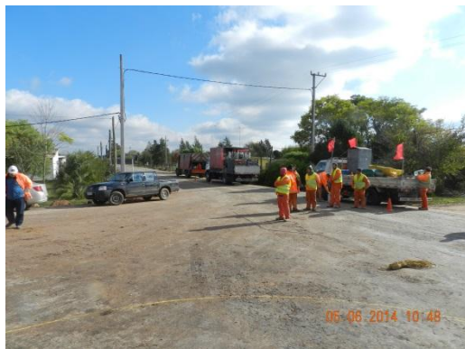
Ilustración 13: Frente de obra en progresiva 86K423
