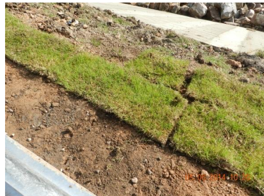
Ilustración 20: Protección contra erosión parcial (tepes de gramilla), próximo a cabecera del puente en progresiva 82K285
