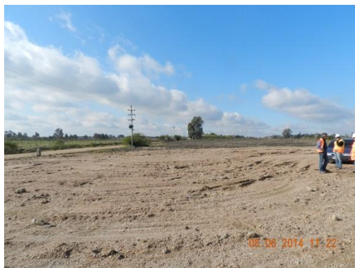
Ilustración 9: Sitio del obrador principal con restauración parcial
