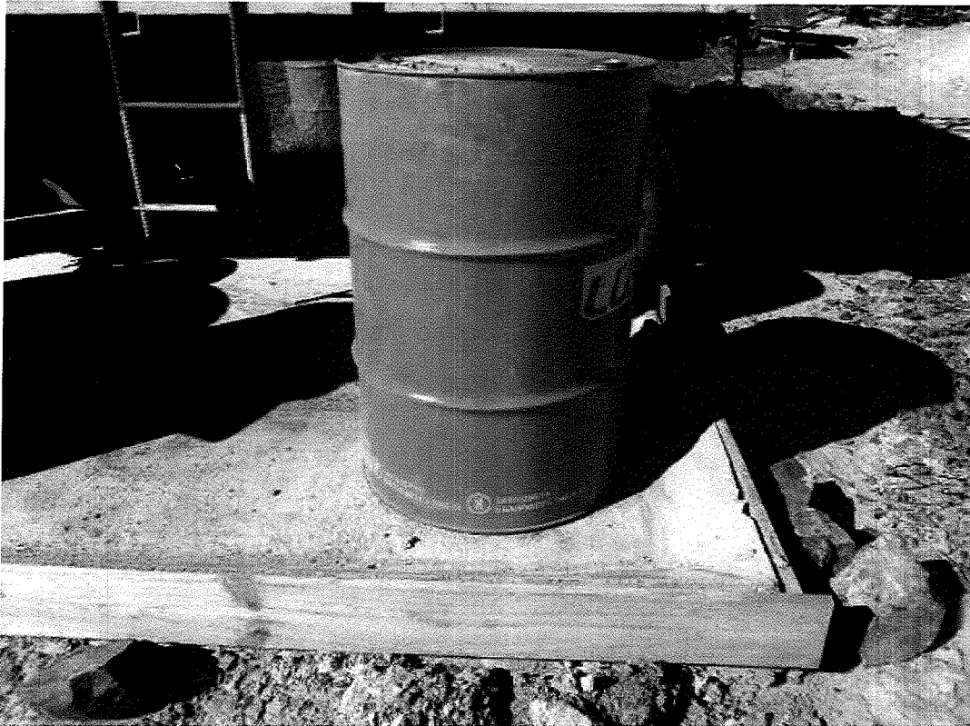
Figura 2: Zócalo de contención en depósito de combustibles
