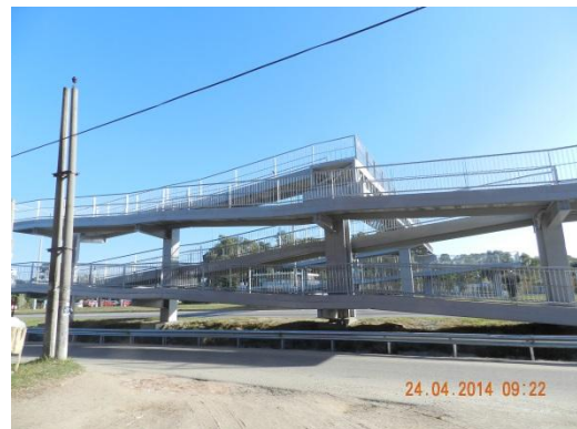
Ilustración 9: Puente peatonal próximo a la Avda. Pinares
