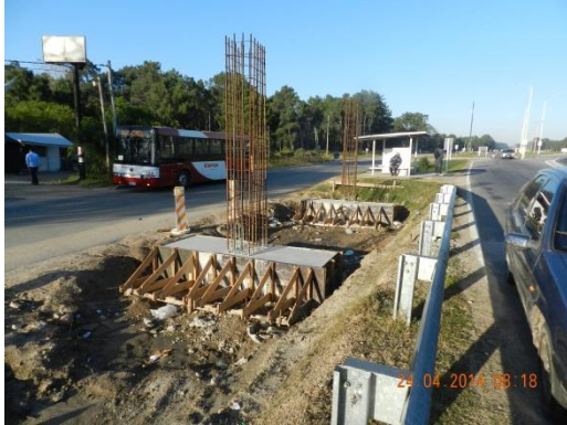
Ilustración 4: Construcción de bases y pilares en progresiva 33K500 a (+)
