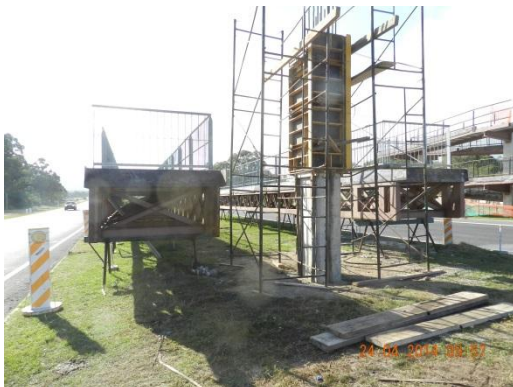
Ilustración 8: Frente de obra en puente peatonal próximo a Jaureguiberry
