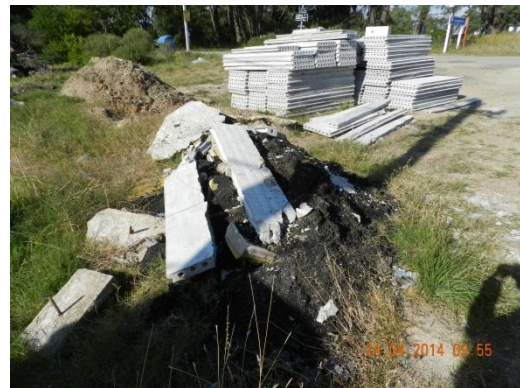
Ilustración 7: Residuos (losetas de hormigón rotas) en faja de dominio público en progresiva 80K000 a (+)
