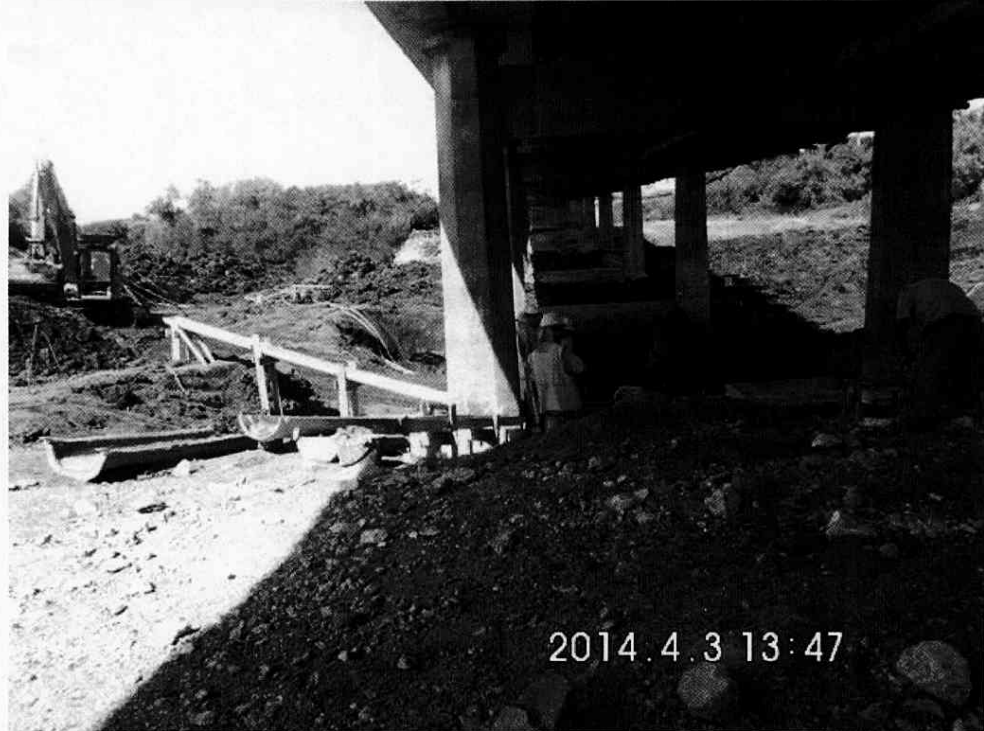
Figuras 2 a 9: Vistas de la obra y del obrador
