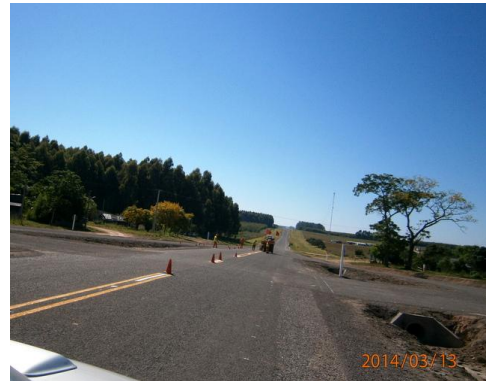
Ilustración 14-Frente de obras, Piedras Coloradas
