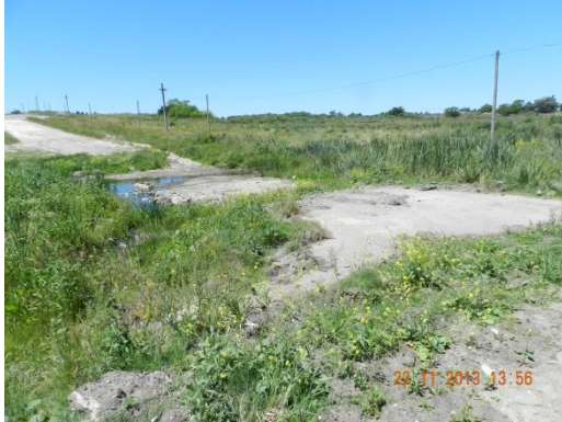
Ilustración 4: Lugar de la alcantarilla vieja que fue demolida
