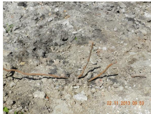
Ilustración 8: Restos del viejo puente – hierros, que afloran sobre la superficie
