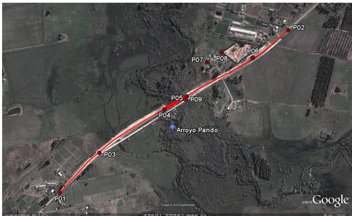
Ilustración 3: Tramo de obra, accesos al puente, puente (resaltado en rojo) y puntos destacados
