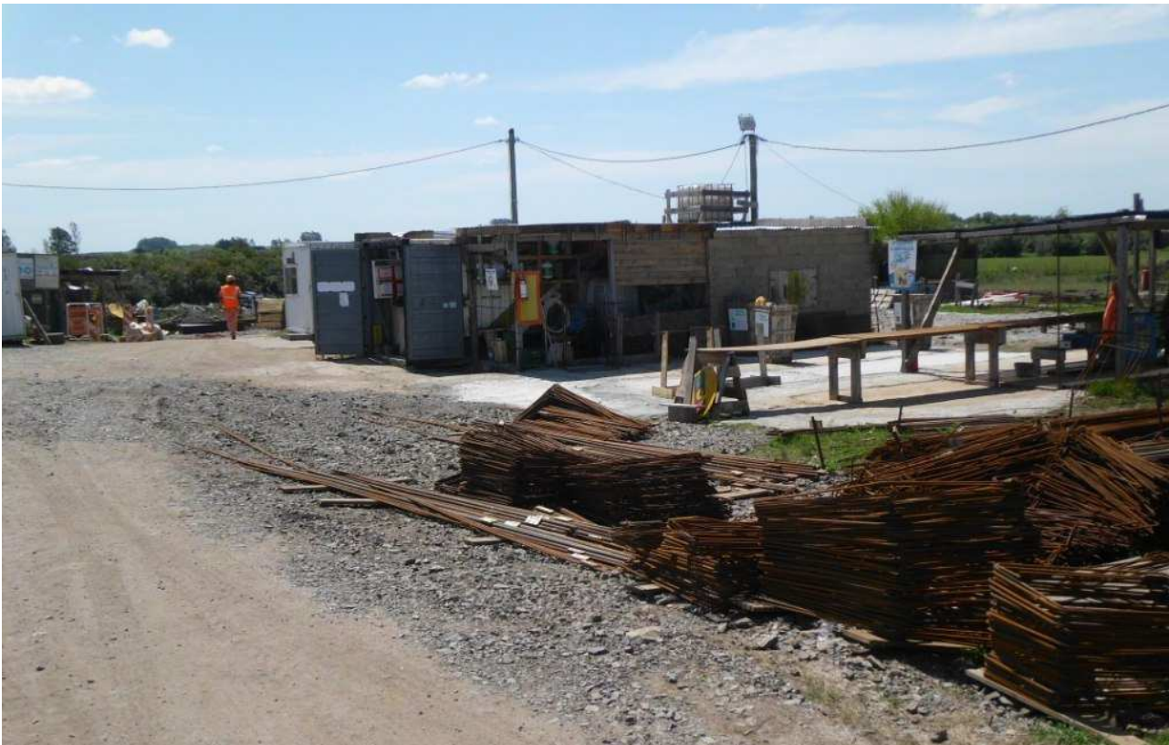
Figura 5: Vista pañol, depósito productos químicos, taller de carpintería, etc.
