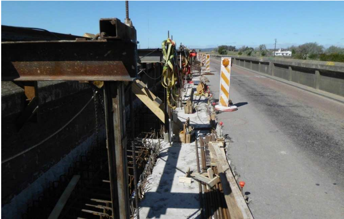
Figuras 15 y 16: Vistas de las obras sobre el puente
