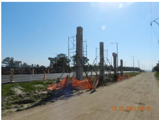
Ilustración 6: Obras en puente peatonal próximo al balneario La Capuera
