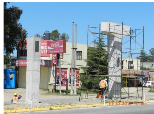
Ilustración 9: Obras en puente peatonal próximo a la Avda. Pinares
