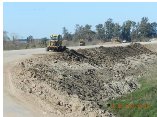
Ilustración 9 - Construcción del terraplén en margen izquierda
