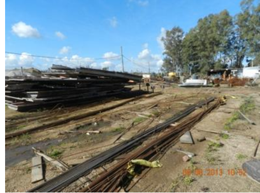
Ilustración 5: Obrador en departamento de Canelones
