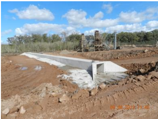
Ilustración 6: Construcción de alcantarilla y pasarela por encima de vía férrea
