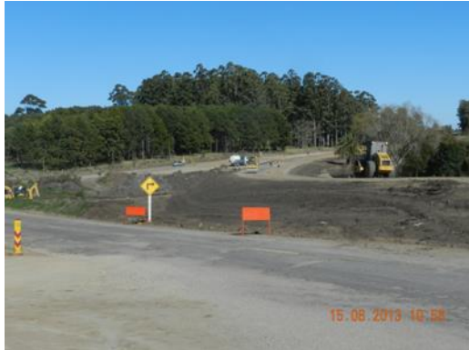
Ilustración 4: Frente de obra en el fondo y tramo actual de ruta 50
