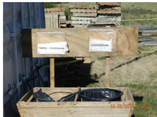
Ilustración 9: Recipientes para segregación de residuos en el obrador
