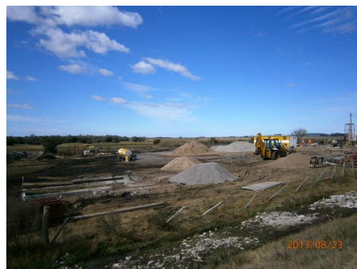
Ilustración 10-Zona de acopios y de producción de hormigón
