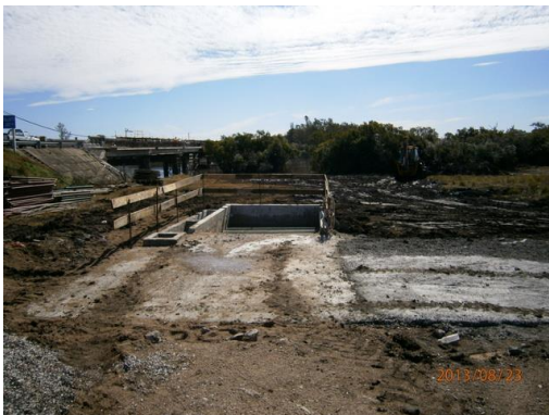
Ilustración 7-Zona de producción y lavado de máquinas de hormigón
