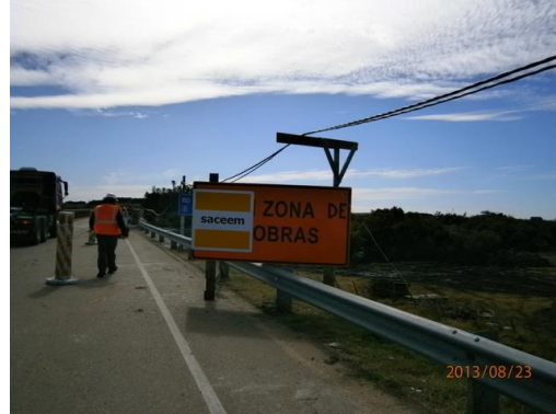
Ilustración 12-Frente de obra, progresiva 207K200
