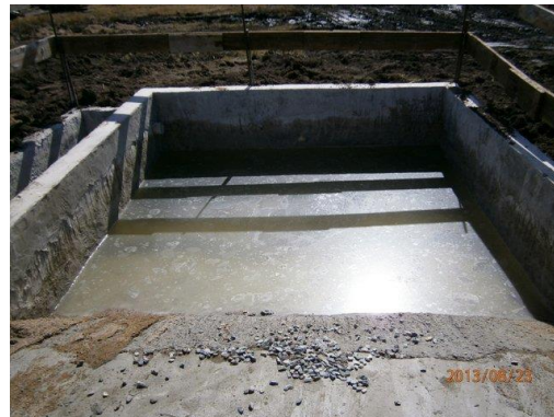
Ilustración 8-Pileta de lavado de equipos para hormigón
