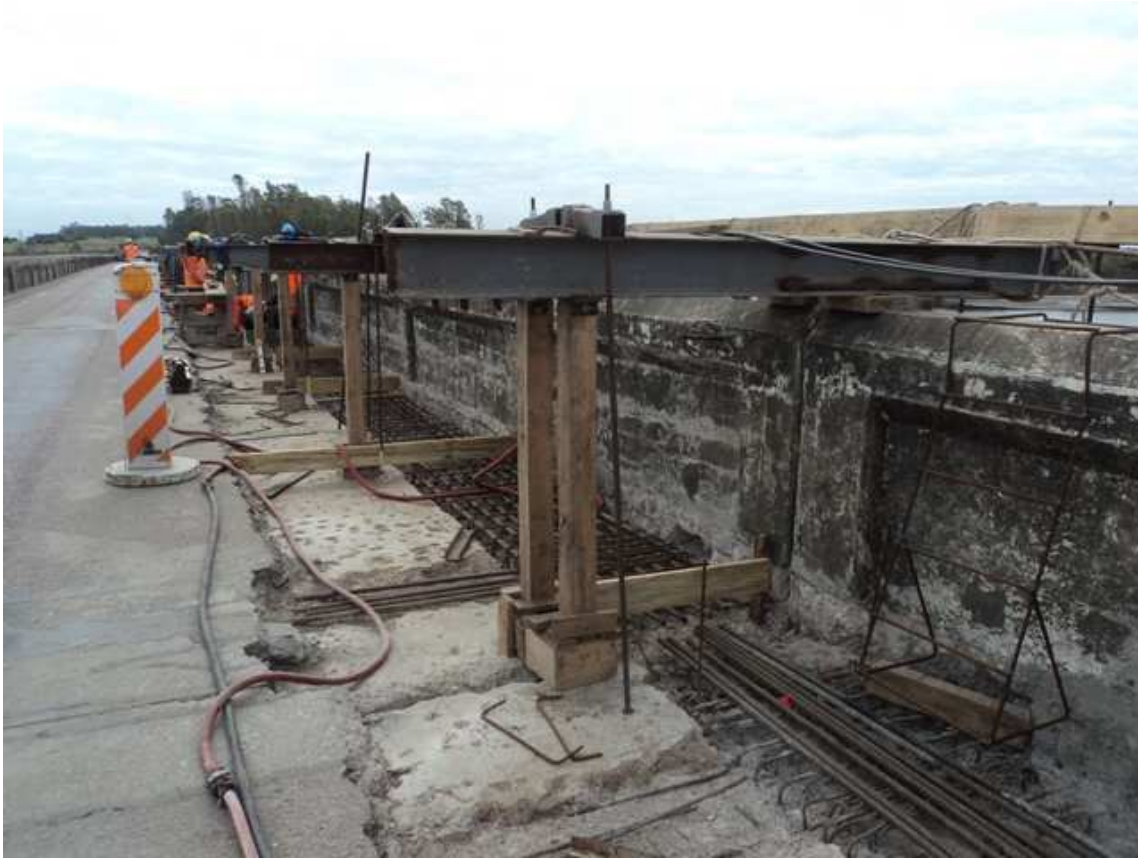
Figura 10 a 14: Diferentes vistas de la obra
