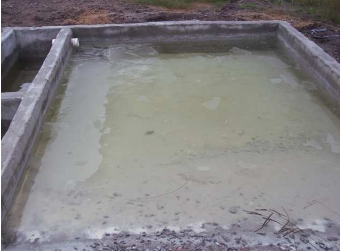
Figura 7: Vista pileta lavado hormigón
