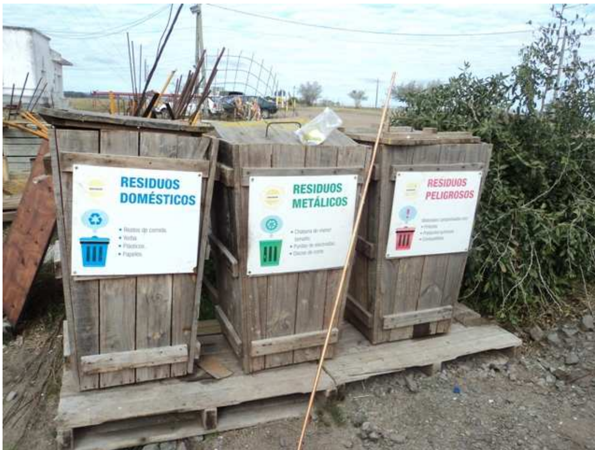
Figura 3: Recipientes destinados al acopio de residuos en obra
