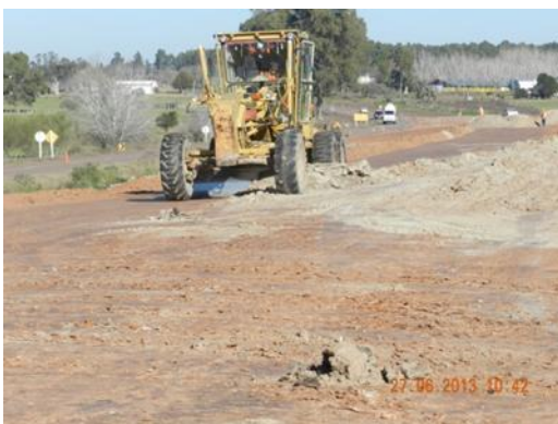
Ilustración 6: Frente de obra en el acceso SW al nuevo puente
