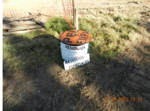
Ilustración 4: Depósito de residuos especiales correctamente identificado
