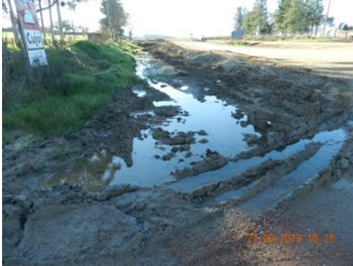
Ilustración 3: Entrada al obrador y escurrimiento superficial parcialmente entorpecido
