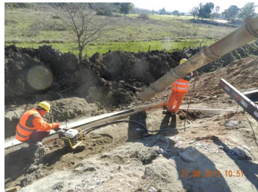
Ilustración 7: Trabajos en el cuarto de cono de la cabecera NE a (+)
