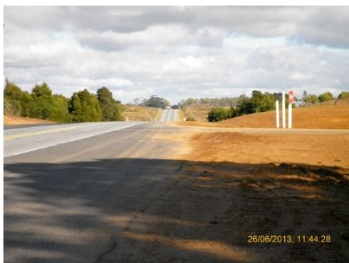
Ilustración 8 - Empalme Ruta 9 en progresiva 211K000 Ramal de Ruta 9. P02
