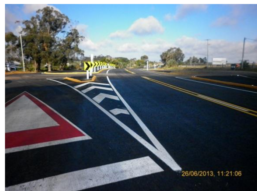
Ilustración 9 - Empalme Ruta 10 progresiva 228K000 en accesos a La Pedrera. P04
