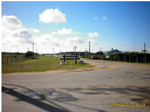
Ilustración 12 - Acceso al Puerto de La Paloma, fin del nuevo camino de acceso. P06
