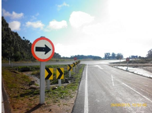
Ilustración 10 - Empalme de Ruta 10 en progresiva 224K000 en accesos a la vía férrea. P05
