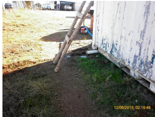
Ilustración 12 - Efluentes de aguas grises de duchas
