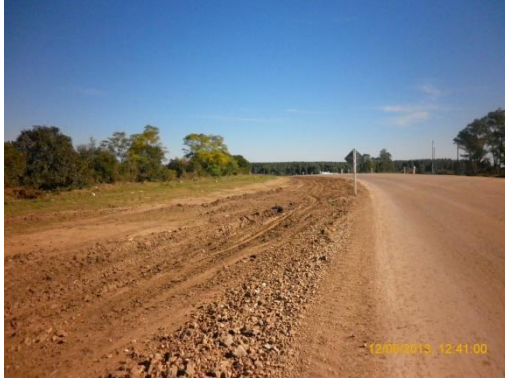
Ilustración 3 - Frente de Obra, segundo tramo
