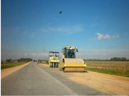
Ilustración 3- Frente de Obra, preparación de banquetas
