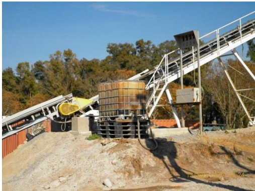
Ilustración 9- Contenedor de almacenamiento de gasoil en planta de hormigón
