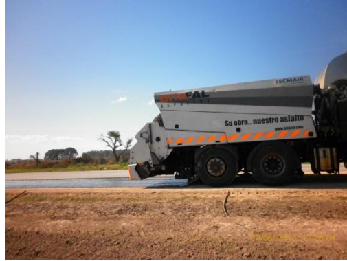
Ilustración 5- Frente de obra, realizando riego asfáltico
