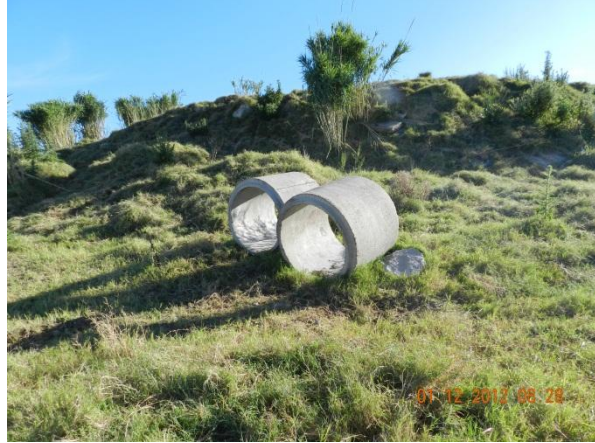
Ilustración 4: Material de obra abandonado
