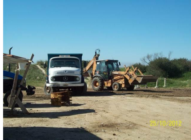
Ilustración 5 – limpieza del obrador
