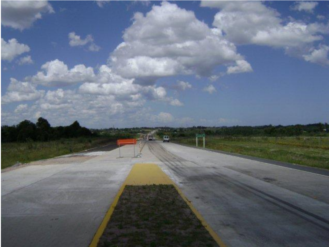
Vista desde el empalme del ACP con Cnel. Raíz hacia progresivas mayores (ver señalización provisoria y definitiva, pasto cortado lado sur)
