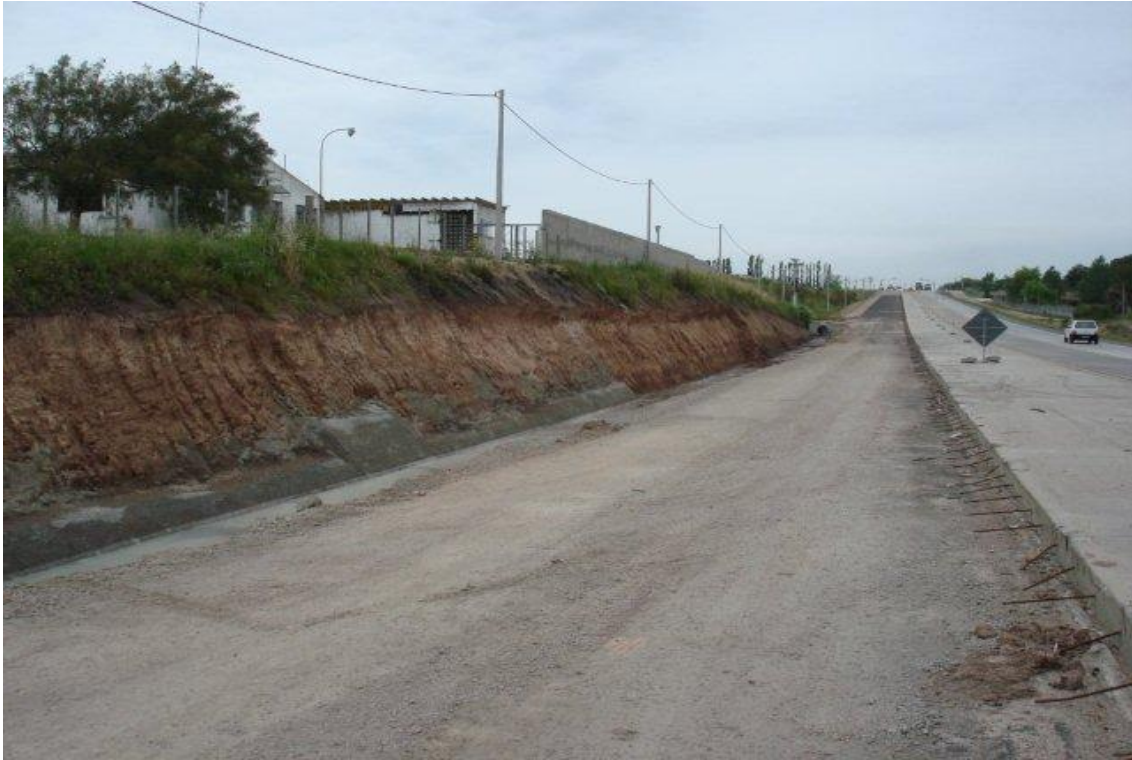
COMIENZO DE TRABAJO DE REVESTIMIENTO DE CUNETA EN ACODIKE: TRAMO 4+375 AL 4+500 LADO A (-). TALUD 2H A 1V, CONTRA TALUD 1.16H A 1V.
