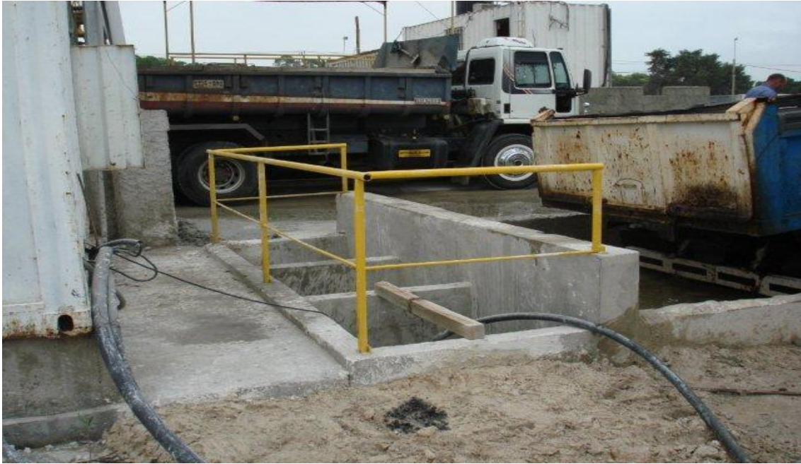
PILETAS DE DECANTACIÓN. SE LIMPIAN PERIODICAMENTE CON BAROMÉTRICA.
