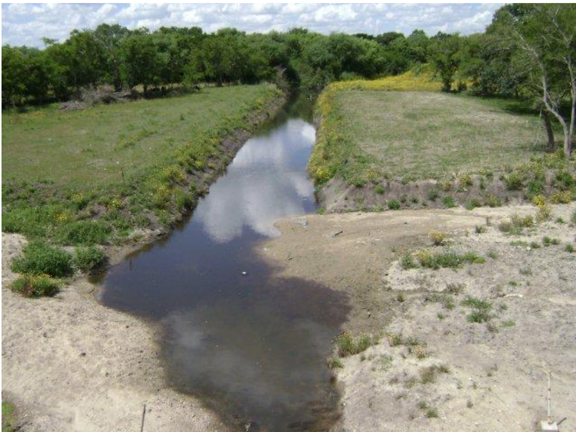
Adecuación del cauce del Aº Mendoza, aguas arriba del puente.
