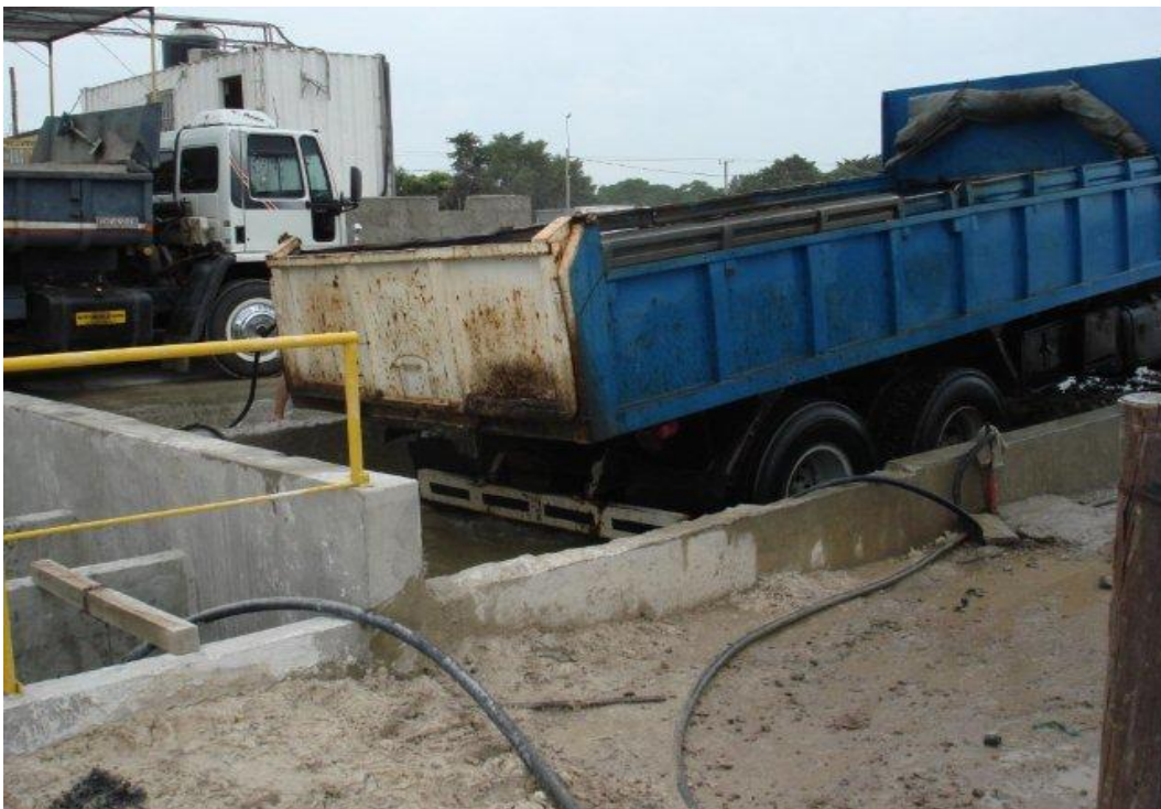
RAMPA DE LAVADO DE CAJAS DE CAMIONES
