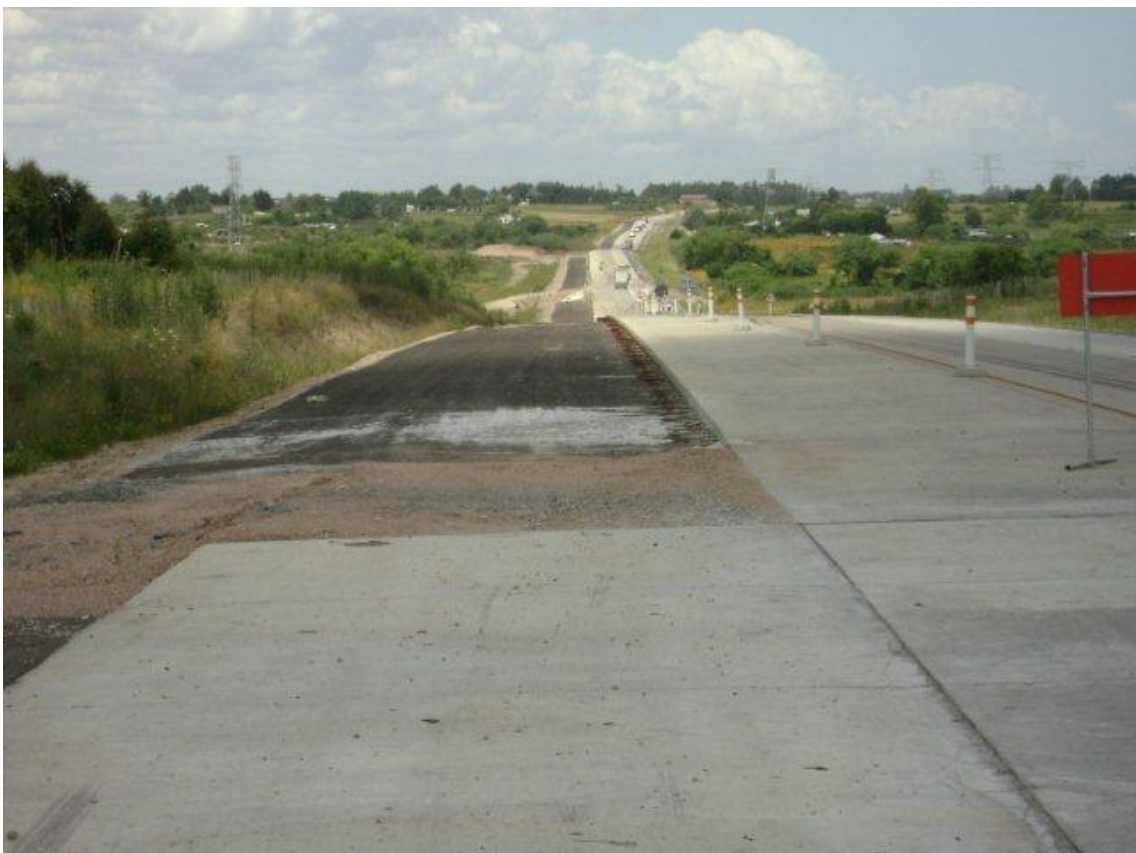
Vista desde el empalme del ACP con Cnel. Raíz hacia progresivas mayores (ver cuarto carril, pendiente de construcción).
