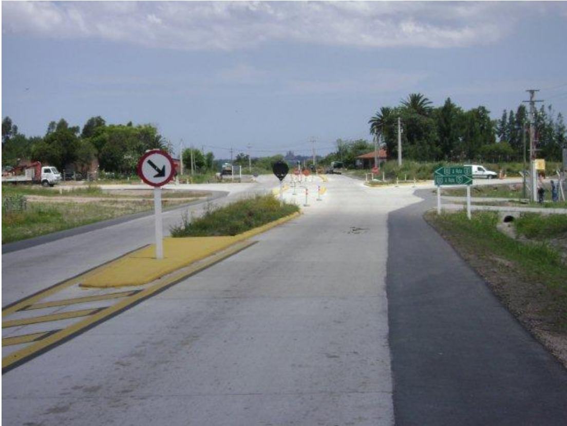
Vista del empalme del ACP con Cnel. Raíz (cantero central terminado sobre Cnel. Raíz).
