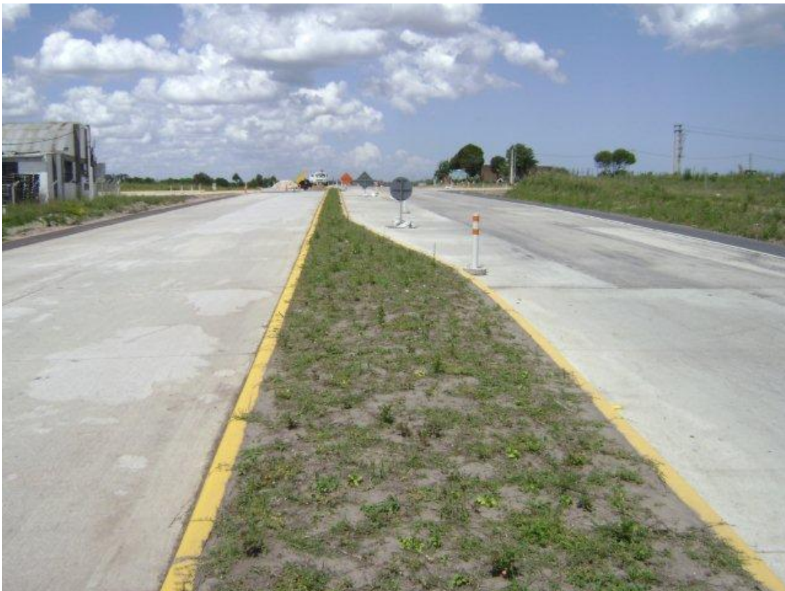
Vista del empalme del ACP con Cnel. Raíz, progresivas menores (cantero central terminado sobre el ACP).
