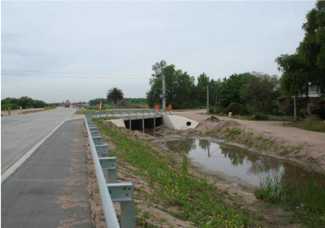
BOCA SALIDA ALCANTARILLA DE CRUCE DE CANAL CAÑADA EL DRAGÓN Y CAMINO MELILLA. REVESTIMIENTOS EN HORMIGÓN TERMINADOS. FALTA LIMPIEZA DE CAUCE A LA SALIDA.
