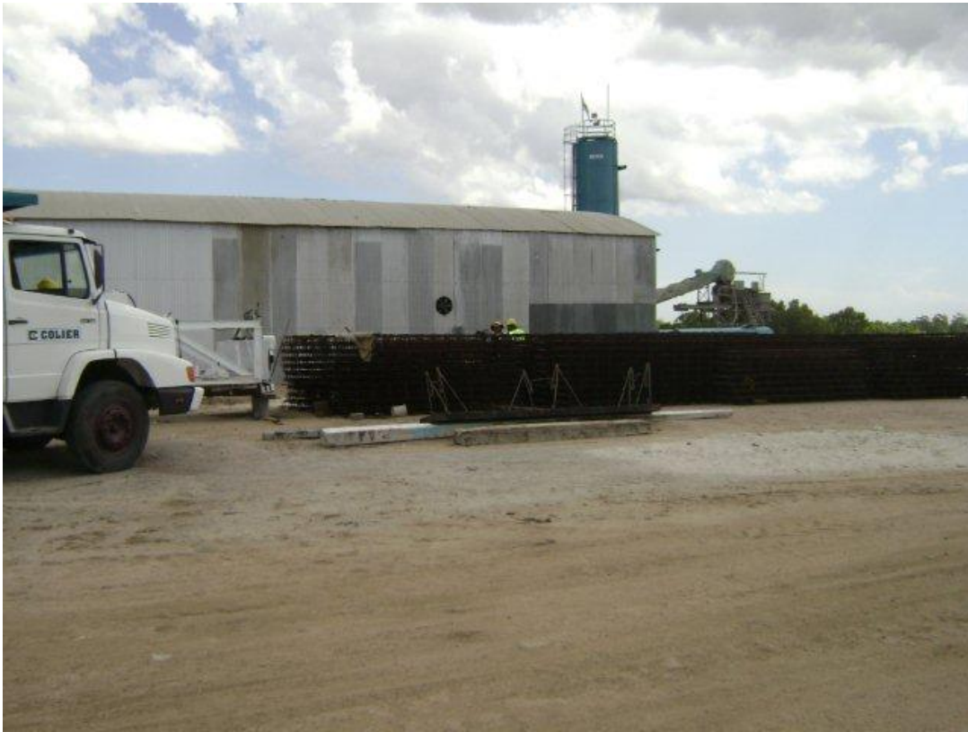
Vista del taller y del acopio del hierro elaborado a incorporar al pavimento de hormigón.
