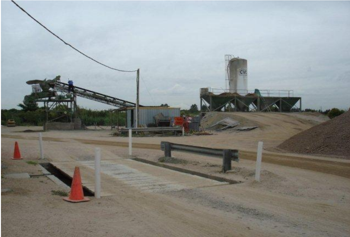
PLANTA ELABORADORA DE ESTABILIZADO GRANULAR CON CEMENTO, ACOPIO DE TOSCA, DEPÓSITO DE CARTELES DE OBRA, BALANZA DE CAMIONES – CVC S.A. VER RIEGO PALIATIVO DE POLVO.
