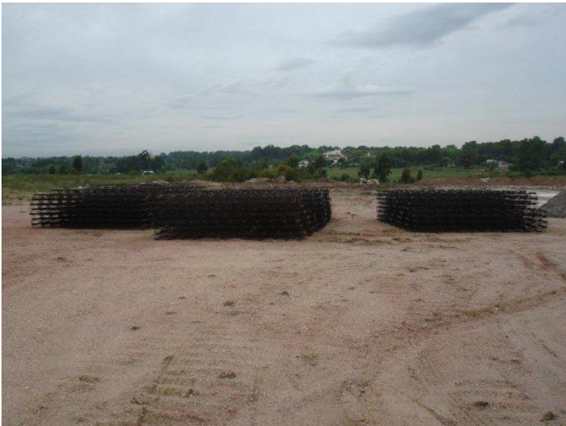
ZONA DE ACOPIO DE CANASTOS DE PASADORES. AL FONDO A LA DERECHA ACOPIO DE PRODUCTO DE FRESADO.
