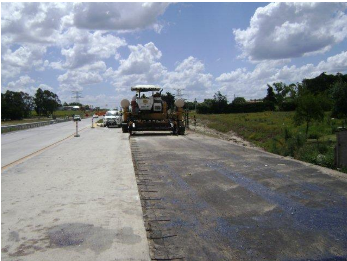
Pavimentadora en posición para comenzar a ejecutar el cuarto carril.
