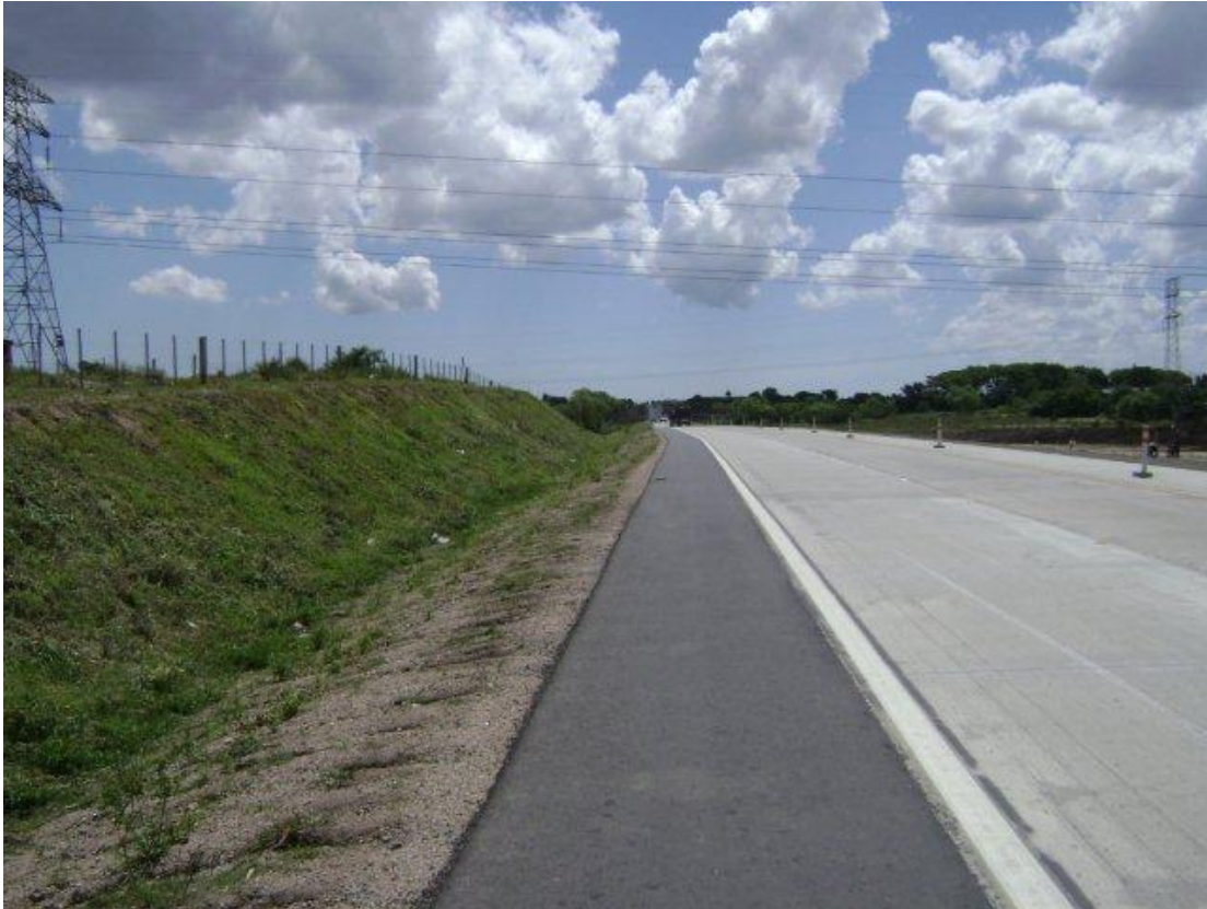
Banquina sur, suelo pasto (talud y contratalud) y pasto cortado.
