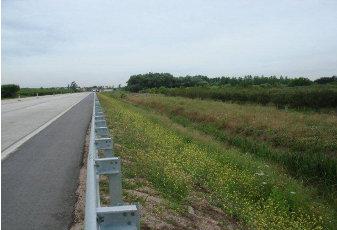
CANAL CAÑADA EL DRAGÓN LADO A (+): TRAMO PASA VACA - FAUQUET. TALUDES EMPASTADOS.
