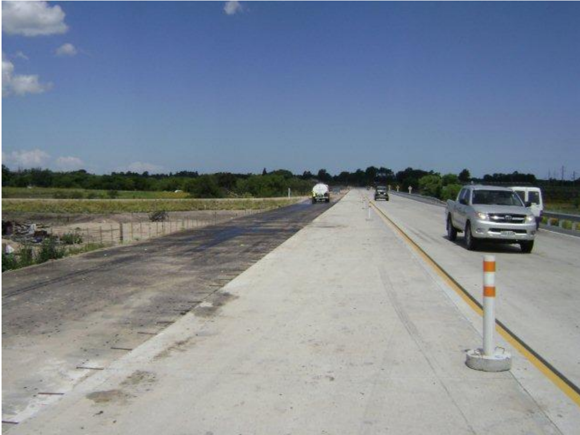
Cuarto carril en preparación final previa a su pavimentación.
