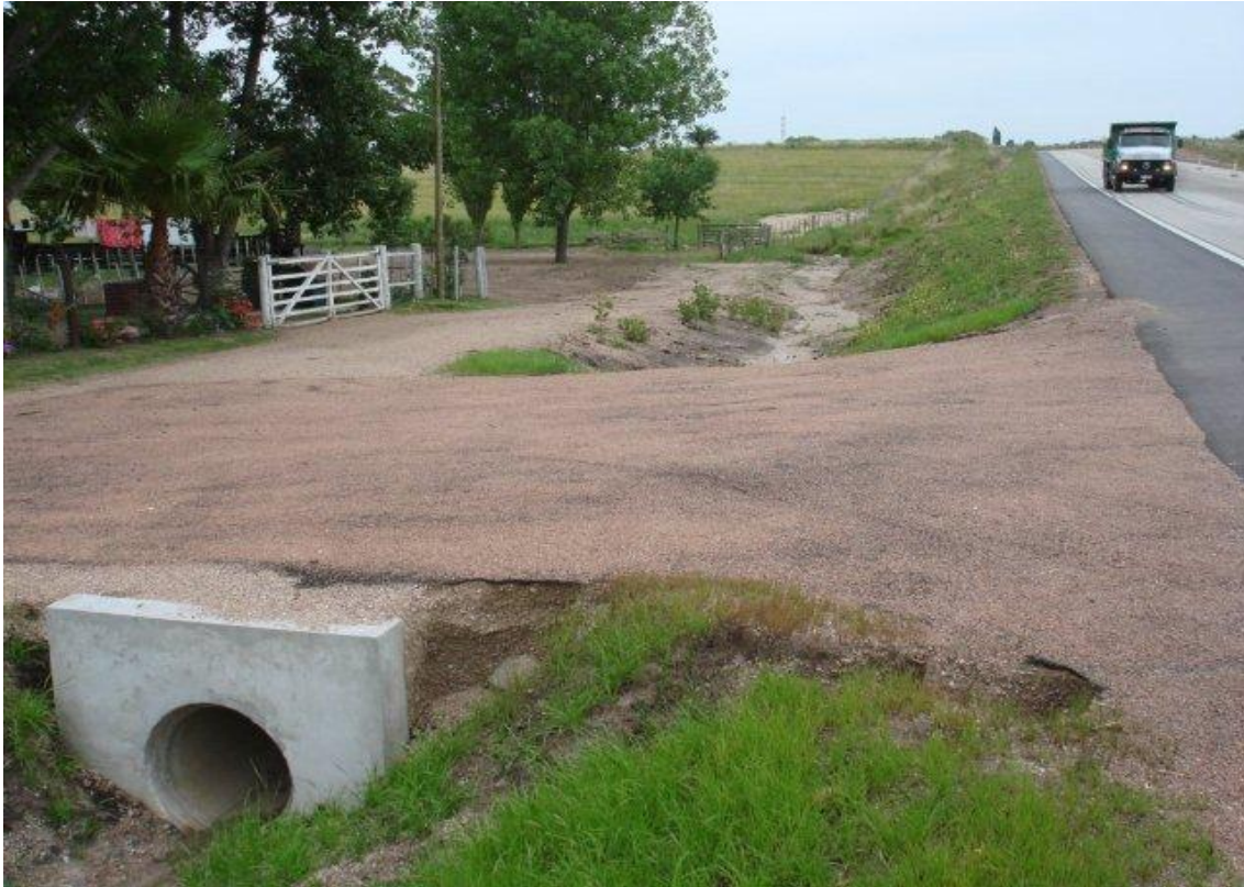
TRAMO 4+375 A 4+000 LADO A (+). TALUDES REVESTIDOS Y EMPASTADOS.
