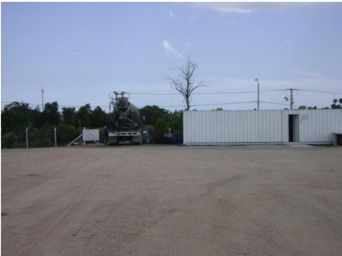
Vestuario y duchas. A la izquierda, zona pavimentada para cambios de aceite y acopio en tarrinas cerradas de residuos derivados del petróleo.
