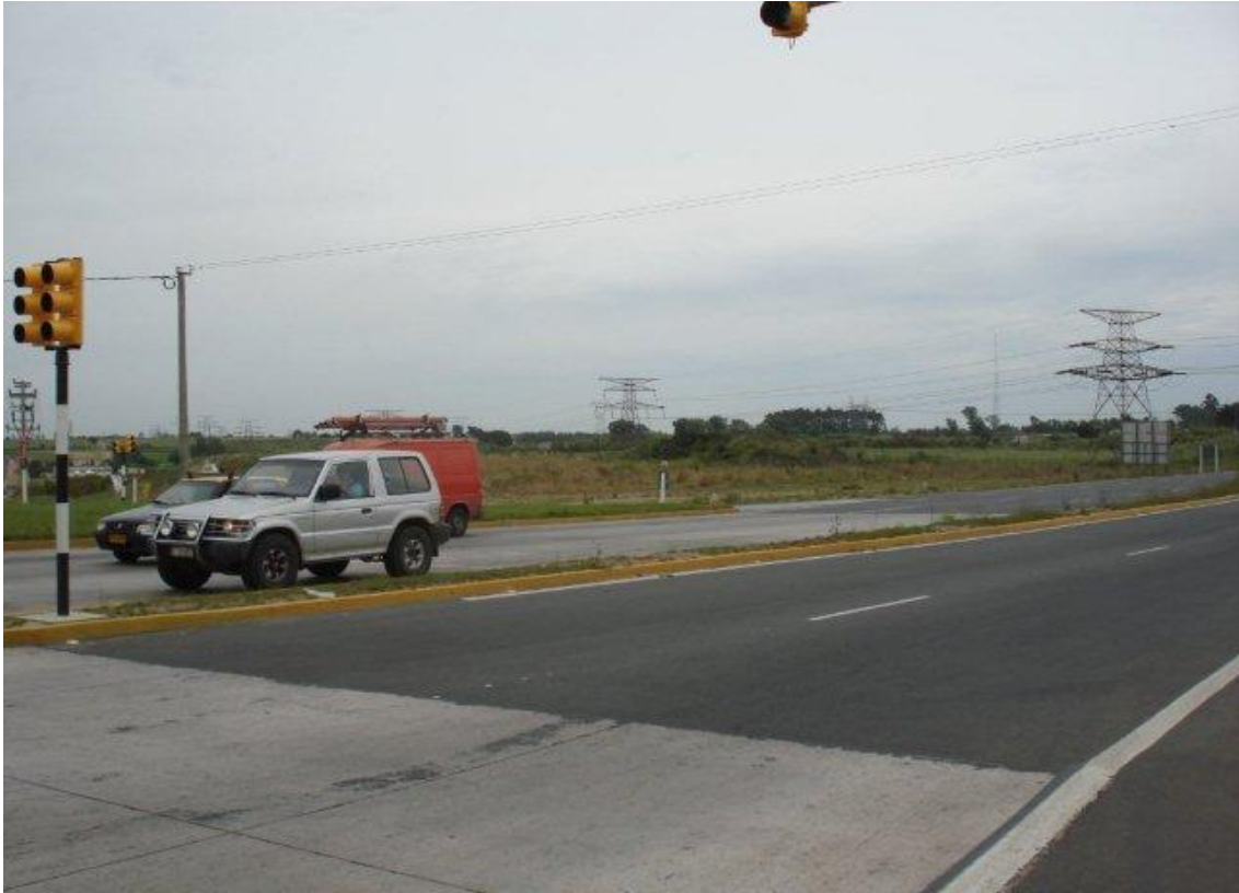
EMPALME CMG, LADO NORTE. CANTEROS EMPASTADOS.
