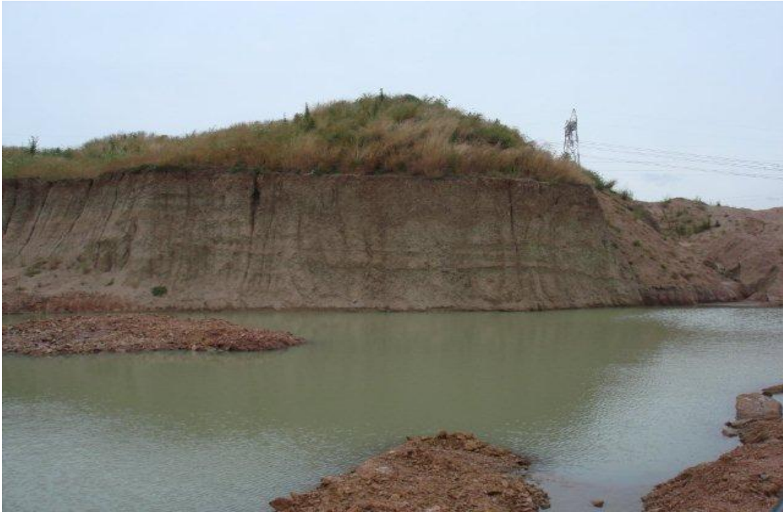
PRESTAMO #4. PISO INUNDADO DEBIDO A LLUVIAS RECIENTES. DESTAPE DE CANTERA COMERCIAL.
