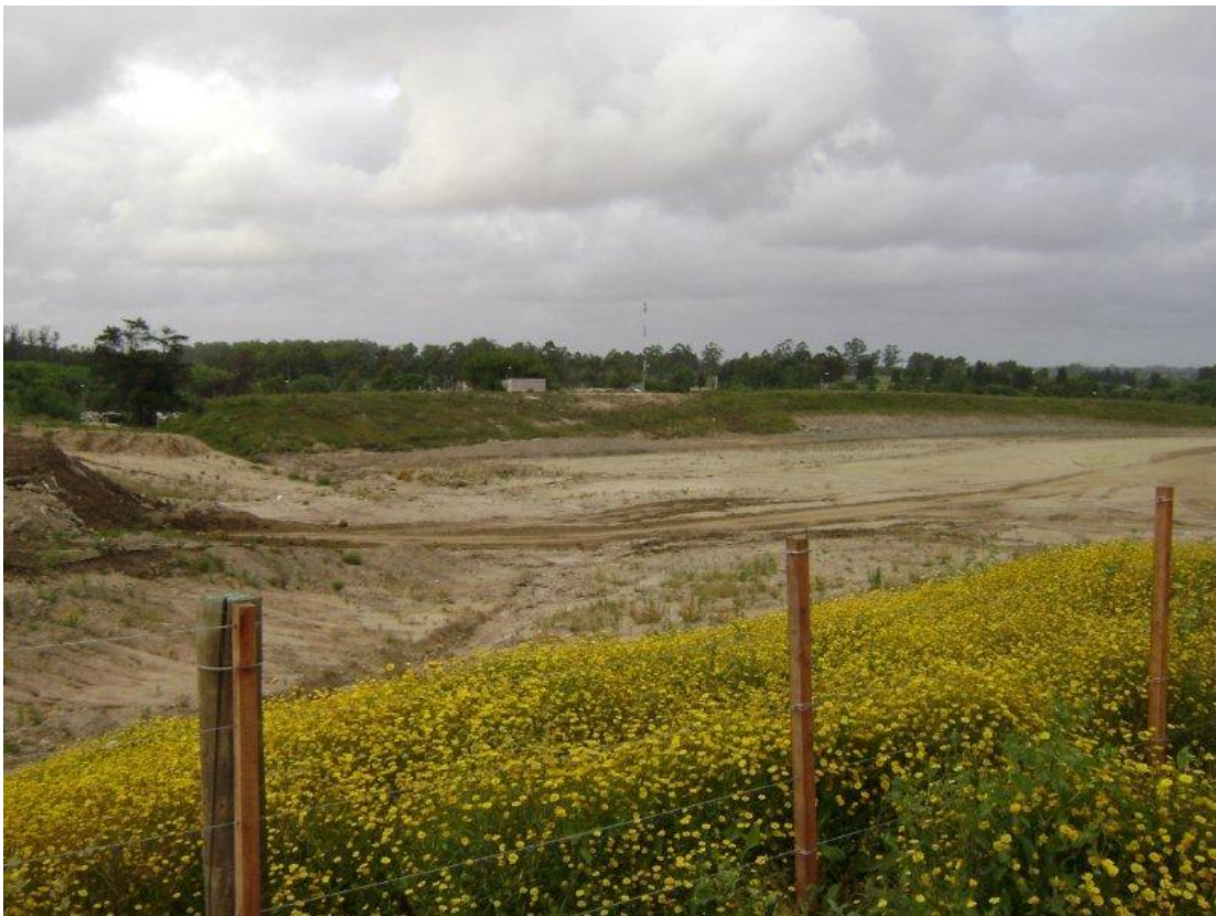
Otra vista del mismo predio. Ver taludes suaves y empastados para evitar erosiones.
