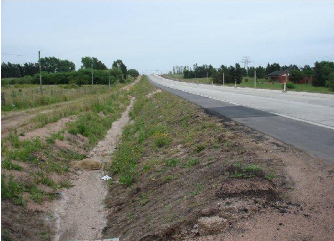
TRAMO 5+600 A PASO NIVEL (5+125 APROX.). TALUD REVESTIDO Y EMPASTADO.
