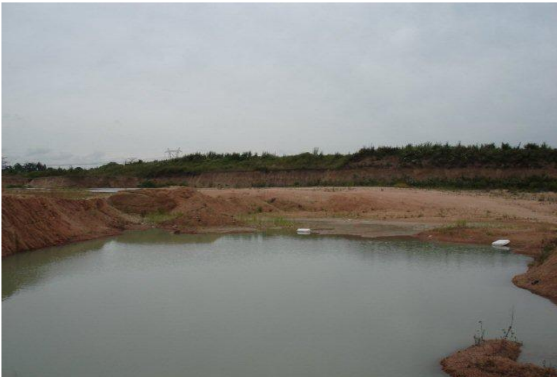
PRESTAMO #1. PISO INUNDADO DEBIDO A LLUVIAS RECIENTES. DESTAPE DE CANTERA COMERCIAL.
