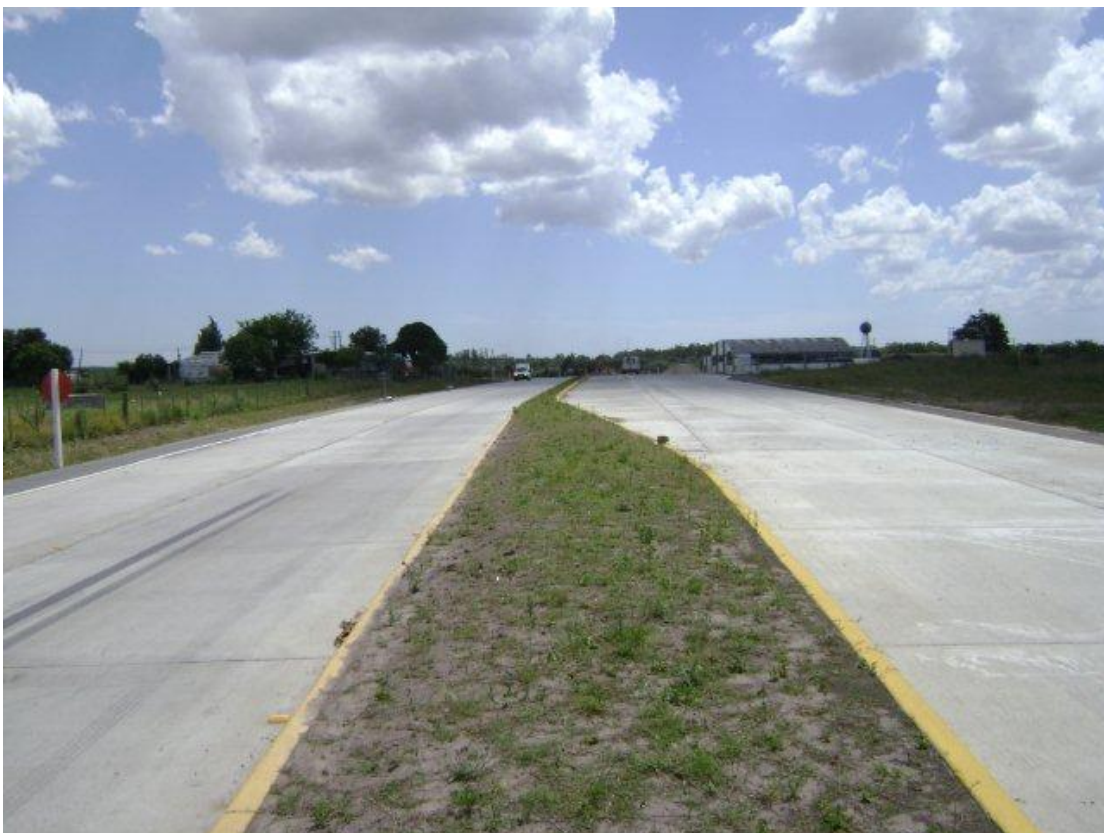
Vista del empalme del ACP con Cnel. Raíz, progresivas mayores (cantero central terminado sobre el ACP).
