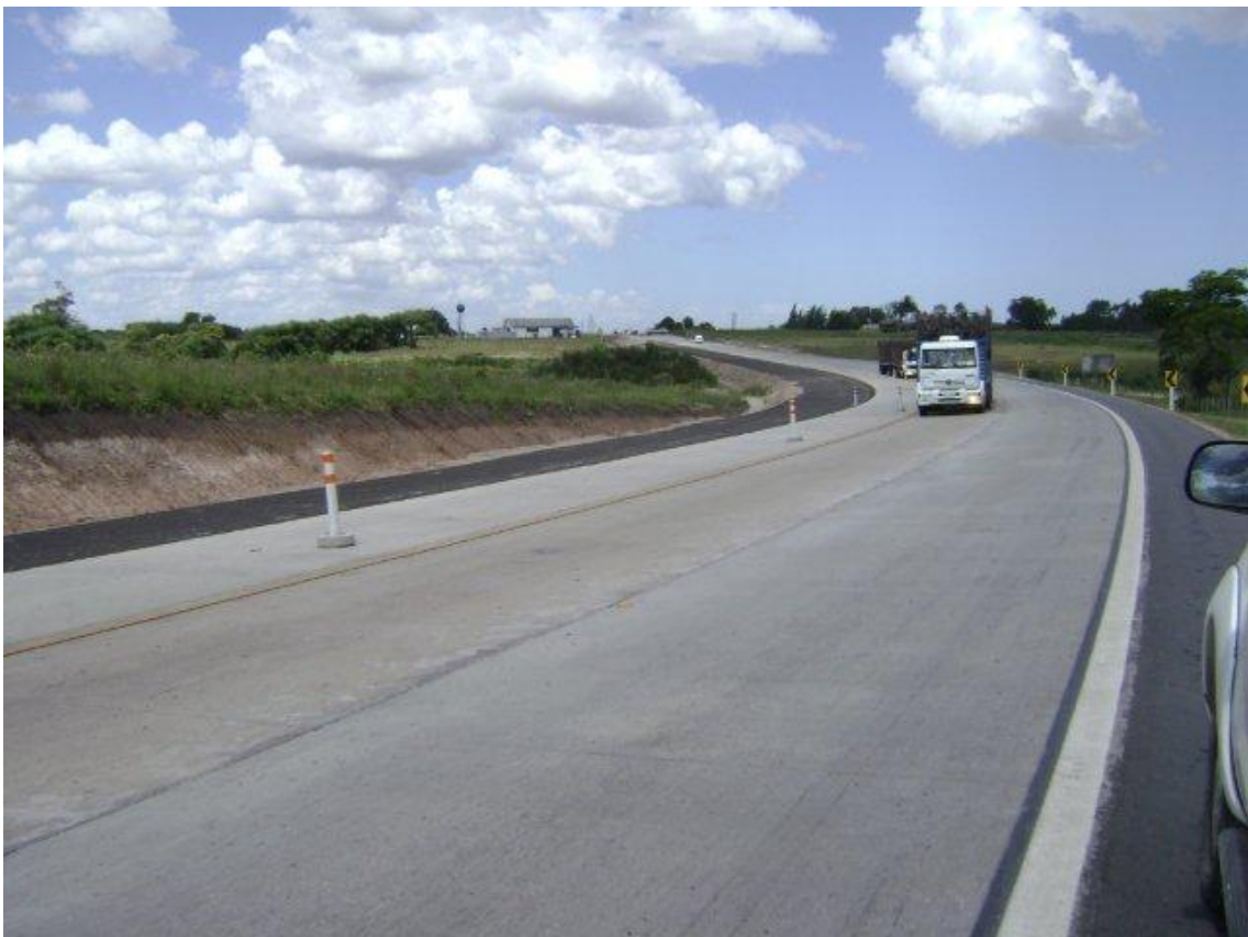
Ruta habilitada en doble sentido (ver señalización vertical y horizontal).
