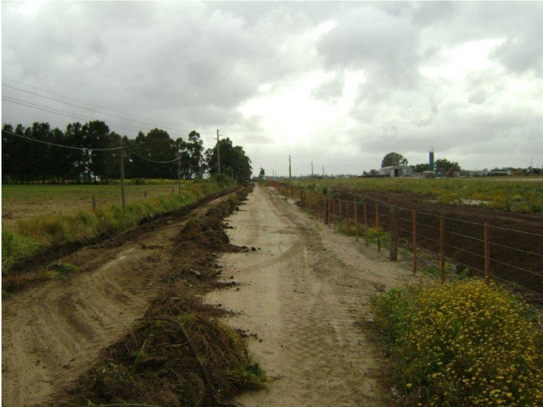
Acondicionamiento de Camino Benito Berges, por el cual se accede al citado predio (limpieza de cunetas, reconfiguración y recargo de plataforma). Al fondo, obrador Colier SA.
