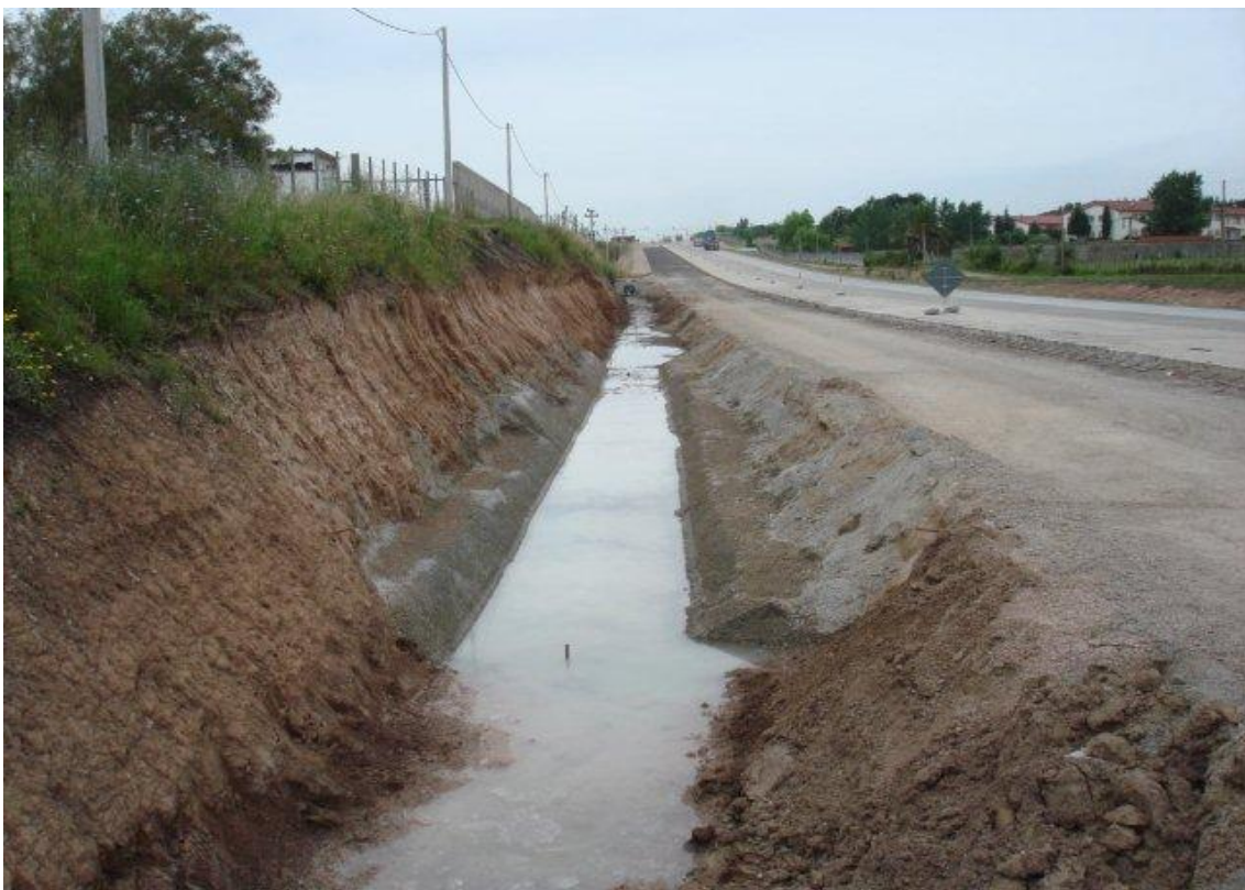
OTRA VISTA DE CUNETA ACODIKE. REVESTIMIENTO CON MATERIAL GRANULAR CEMENTADO.
