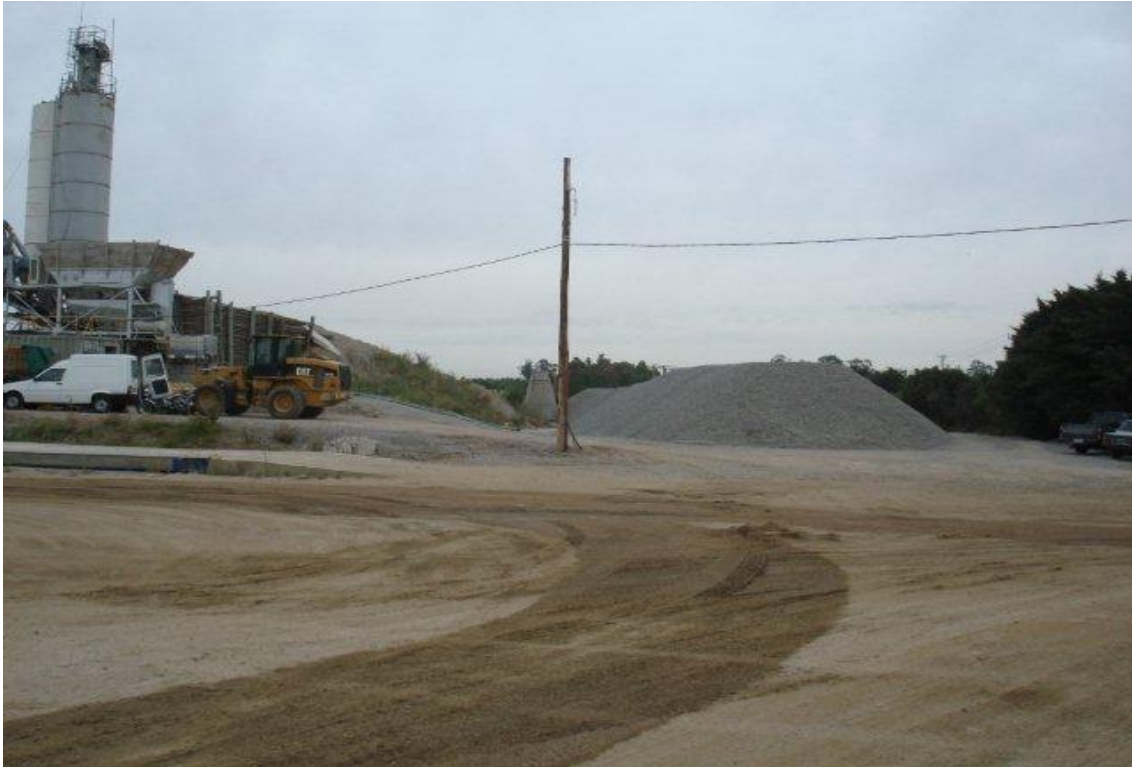
RIEGO DE AGUA PALIATIVO DE POLVO. AL FONDO ACOPIO DE AGREGADOS PARA HORMIGÓN.
