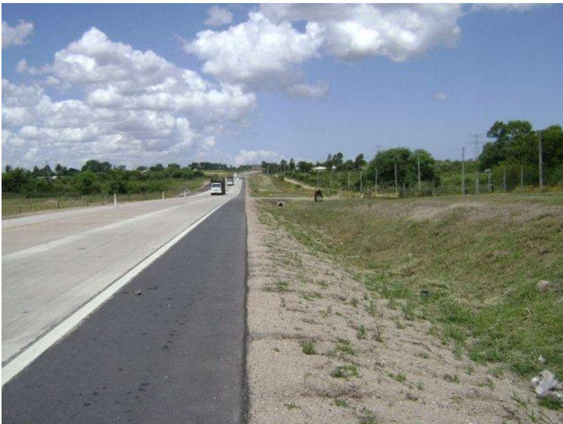
Banquina sur, suelo pasto (talud y contratalud), entradas particulares y pasto cortado.
