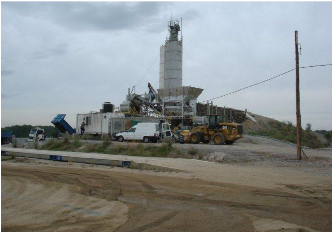
PLANTA DE HORMIGÓN Y BALANZA DE PESAJE DE CAMIONES – HORMIGONES ARTIGAS. VER RIEGO DE AGUA PALIATIVO DE POLVO.
