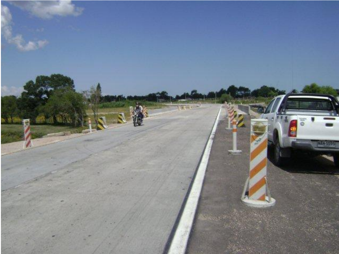
Vista actual del Puente S/Aº Mendoza (ver señalización provisoria).
