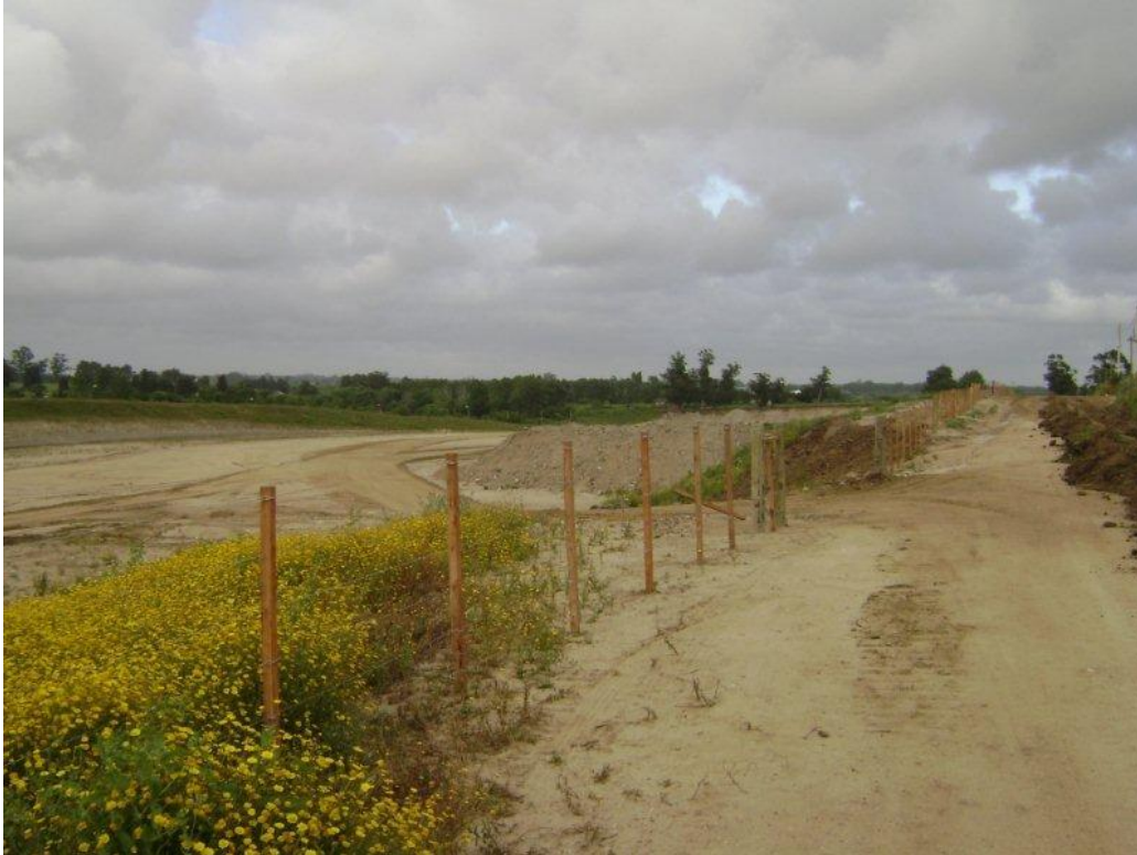
Vista general del préstamo al finalizar su explotación (piso en pendiente evitando la acumulación de agua; taludes suaves y revestidos).
