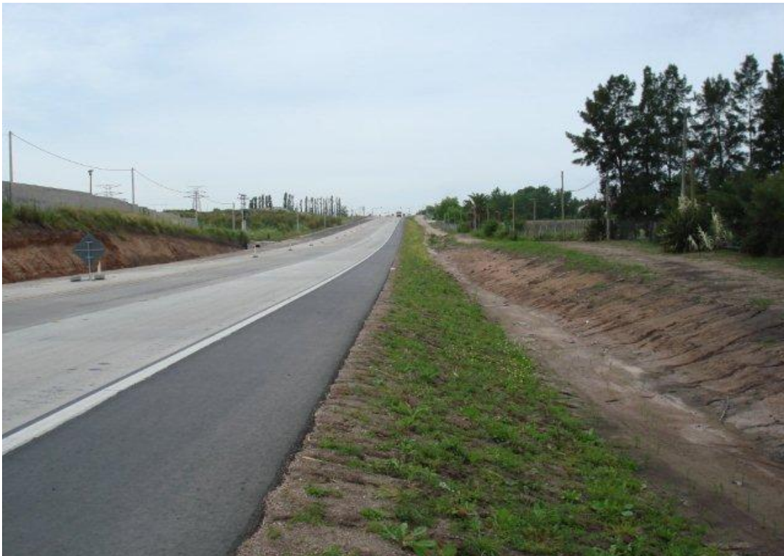
TRAMO 4+375 A CMG LADO A (+). TALUDES REVESTIDOS Y EMPASTADOS.
