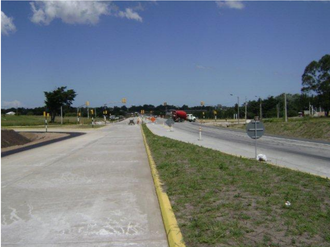
Empalme del ACP con Cno. Mendoza, progresivas menores (carril norte ACP, no habilitado al tránsito todavía).
