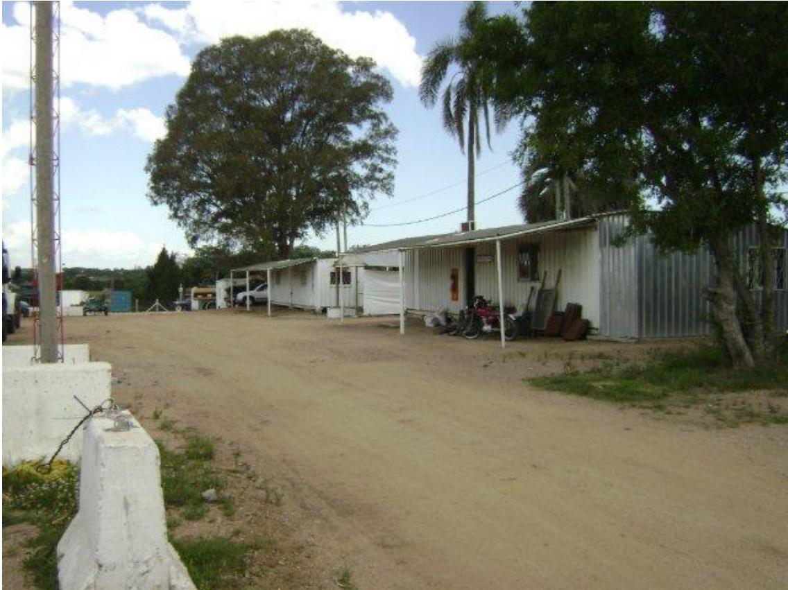
Oficina de la Dirección de Obra, comedor general y laboratorio de obra.
