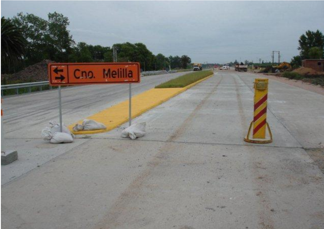
EMPALME MELILLA CON CANTERO CENTRAL EMPASTADO
