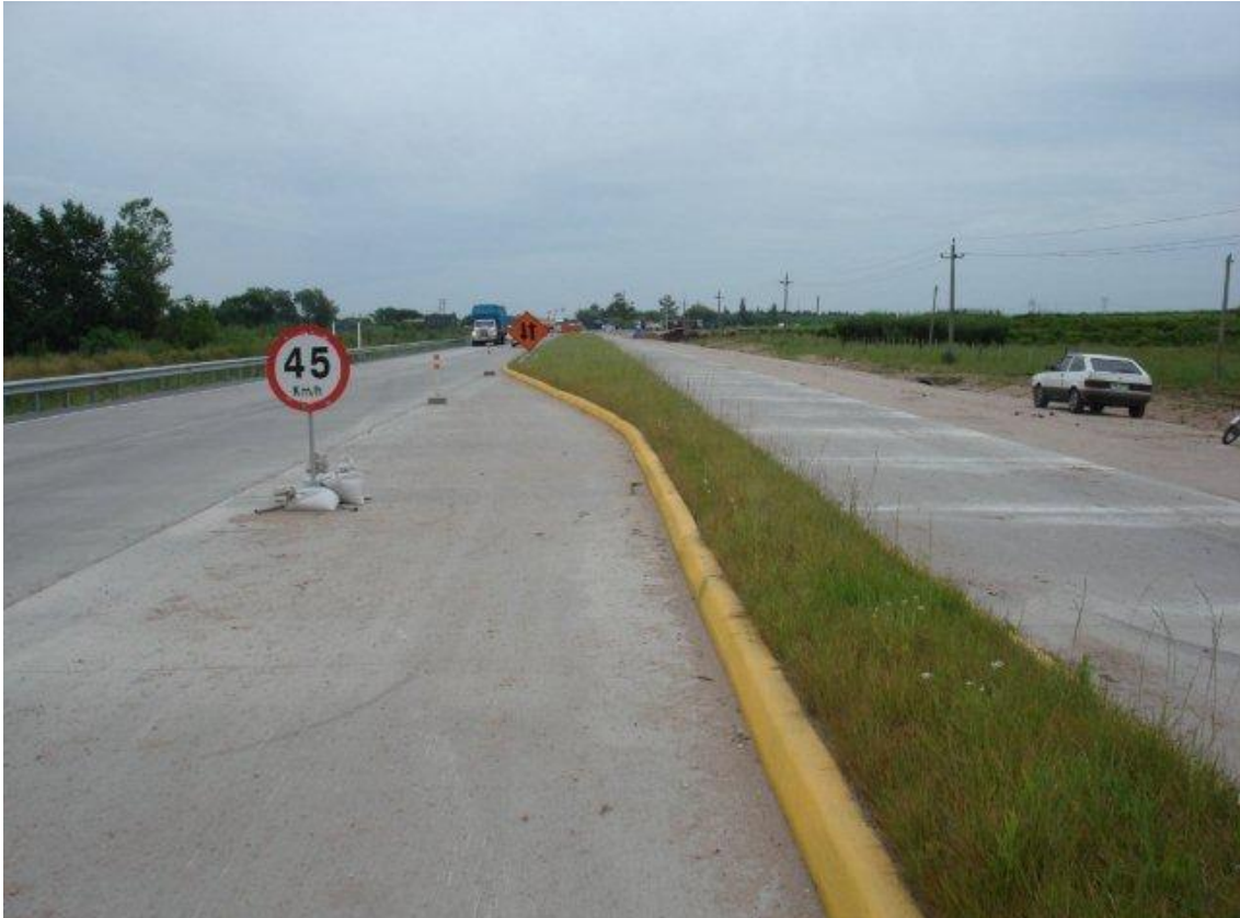
TRAMO MELILLA A RUTA 5 – CANTERO CENTRAL EMPASTADO
