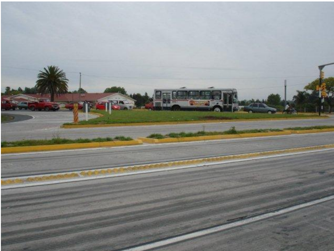
EMPALME CMG, LADO SUR ESTE. CANTEROS E ISLETAS EMPASTADOS.
