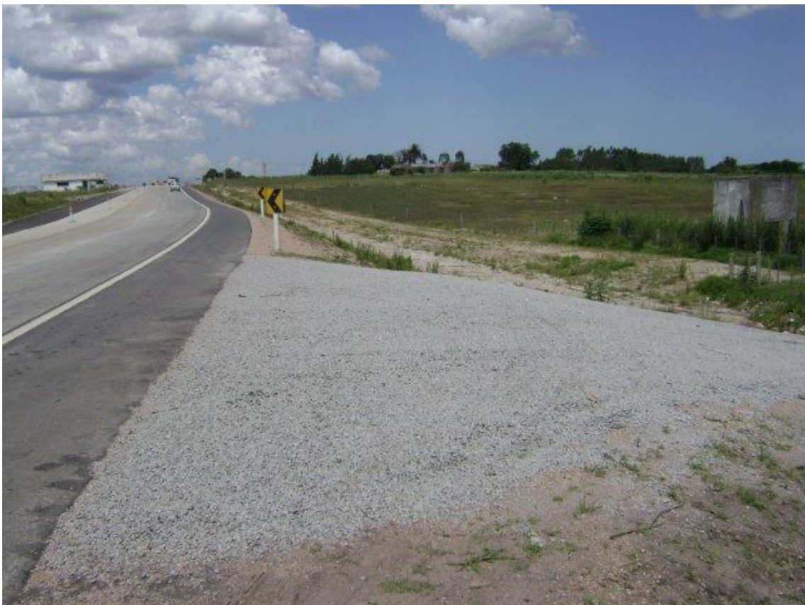
Entrada particular terminada.
