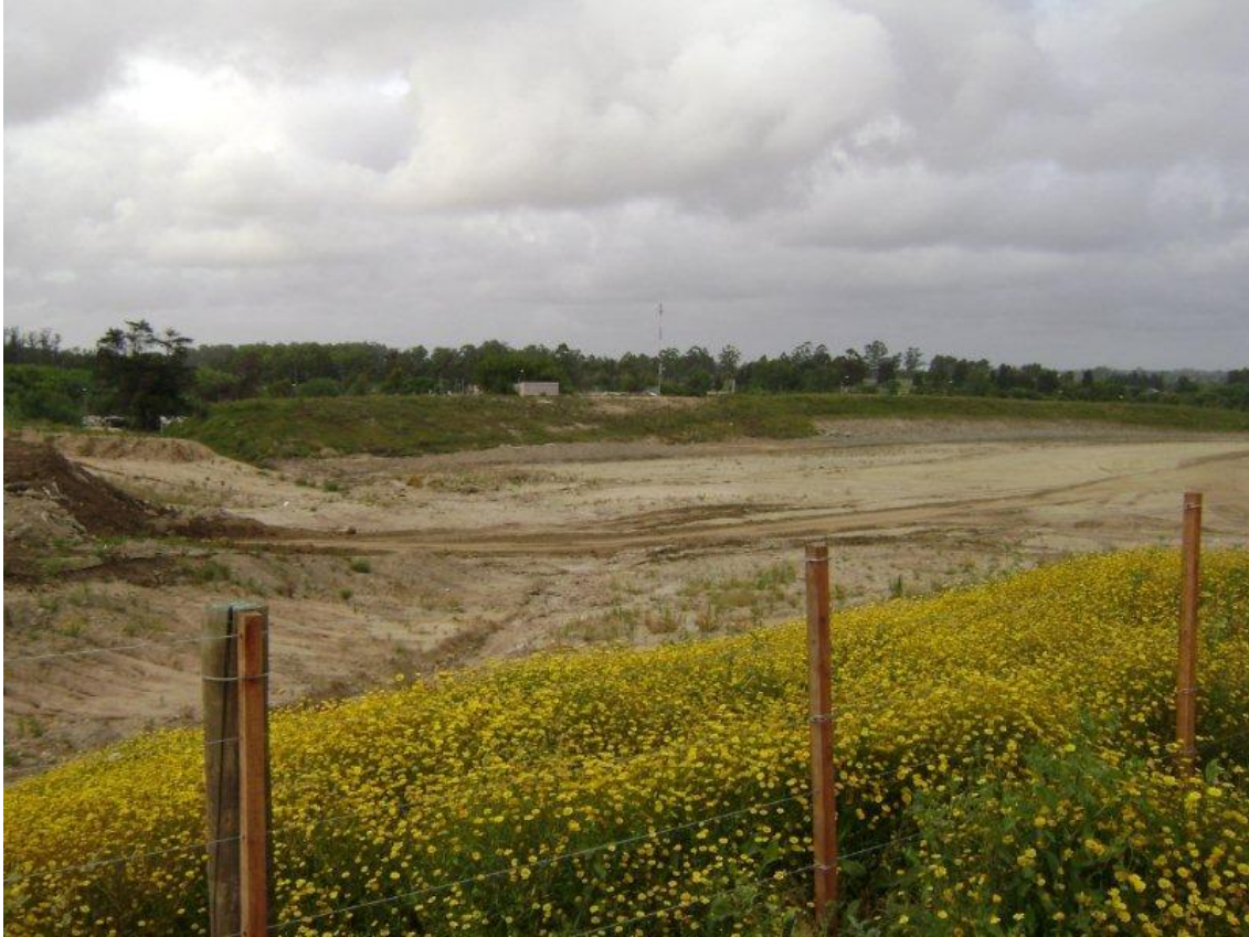
OTRA VISTA DEL MISMO PREDIO. VER TALUDES SUAVES Y EMPASTADOS PARA EVITAR EROSIONES. DICIEMBRE 2009.
