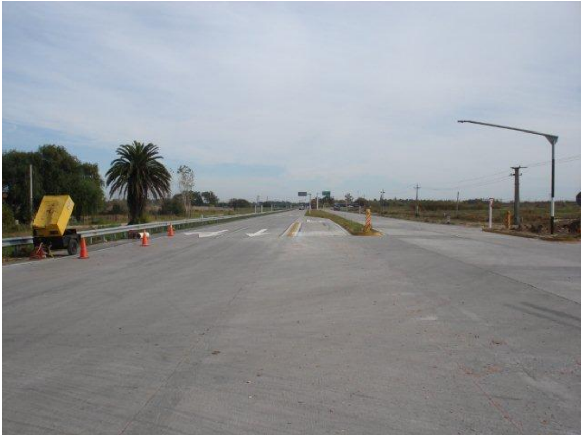
TRAMO MELILLA A RUTA 5 – CANTERO EMPASTADO
