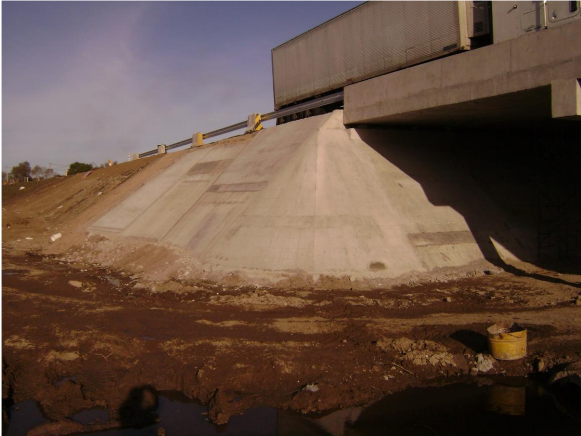
PUENTE SOBRE EL Aº MENDOZA. CUARTO DE CONO NE.
