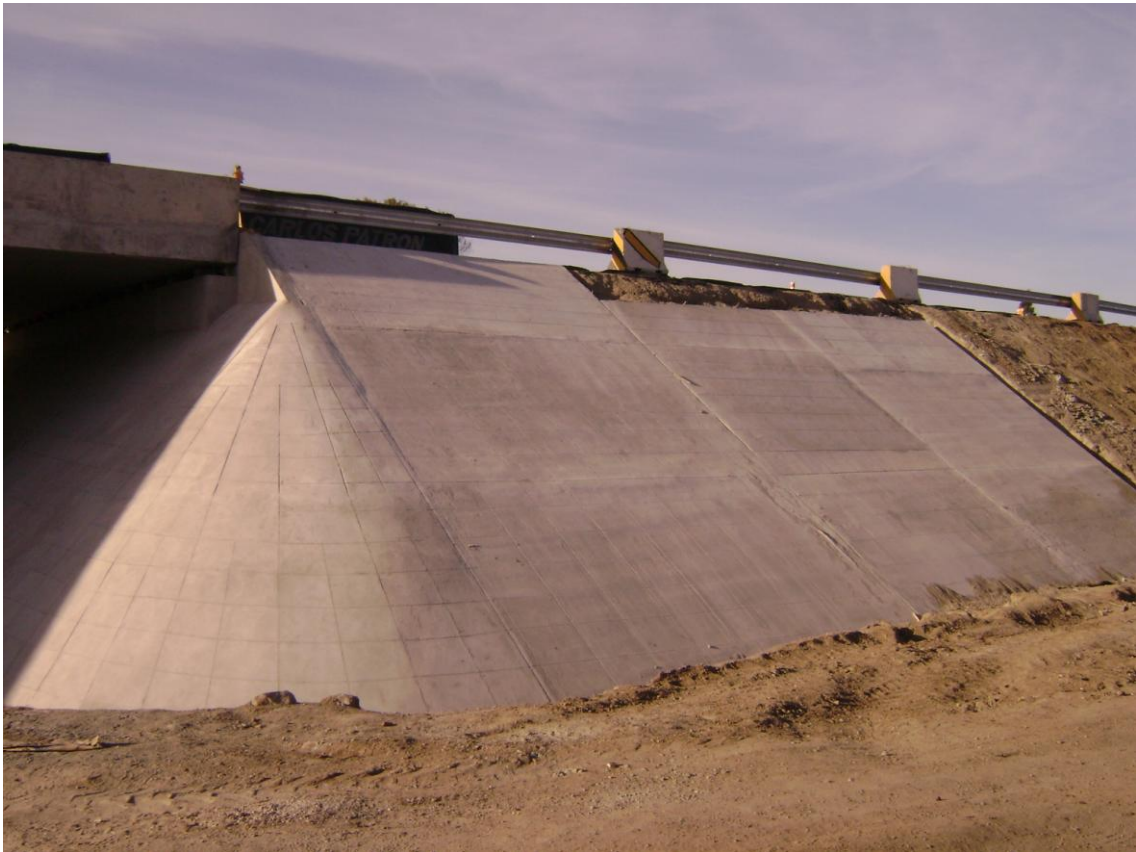
PUENTE SOBRE EL Aº MENDOZA. CUARTO DE CONO SE.
