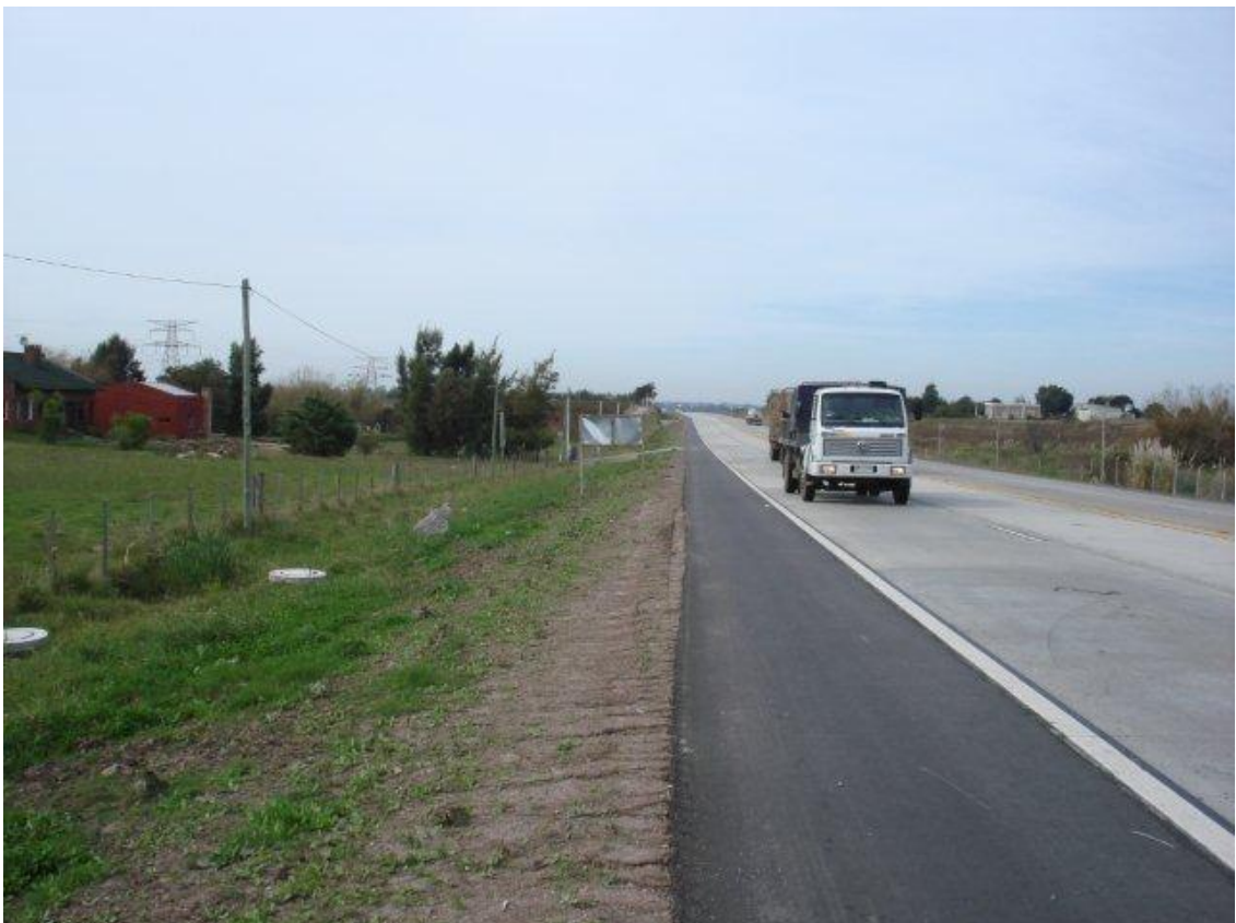
TRAMO VÍA FÉRREA A FORTET LADO A (-). TALUDES REVESTIDOS Y EMPASTADOS.
