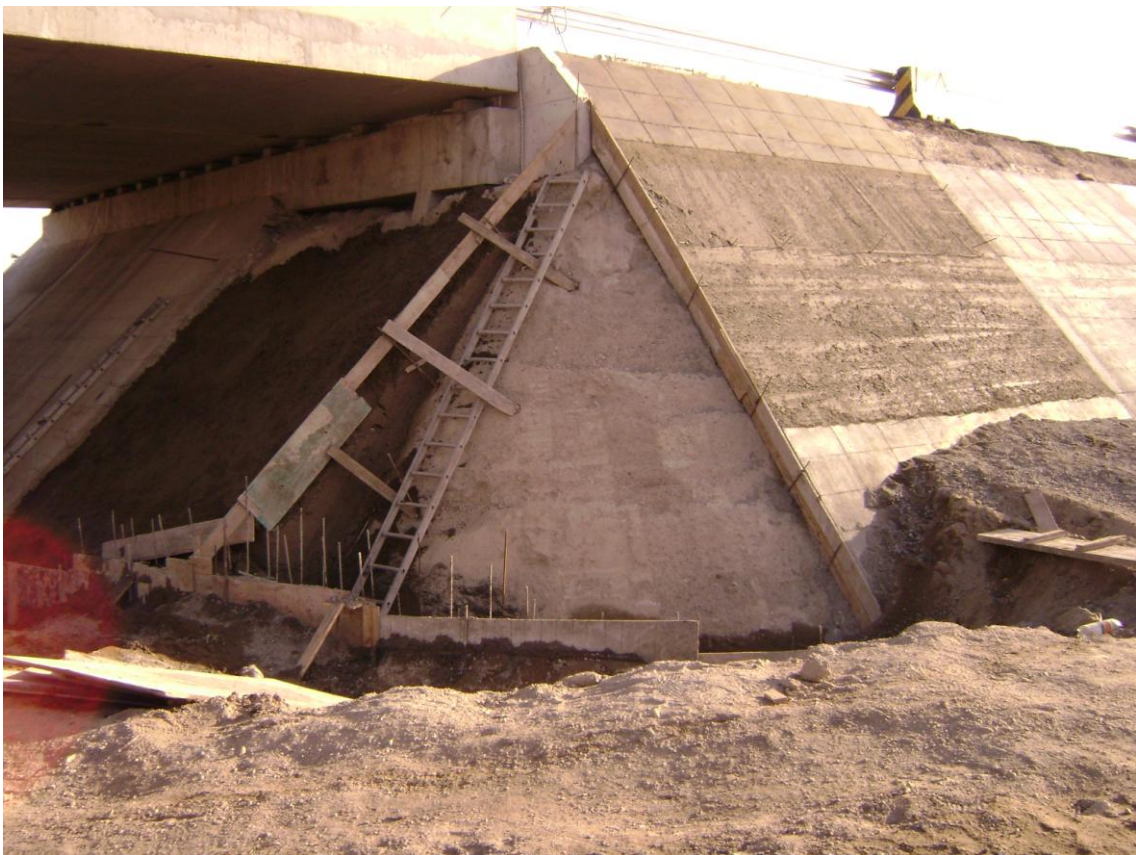
PUENTE SOBRE EL Aº MENDOZA. CUARTO DE CONO SW, EN FINALIZACION.
