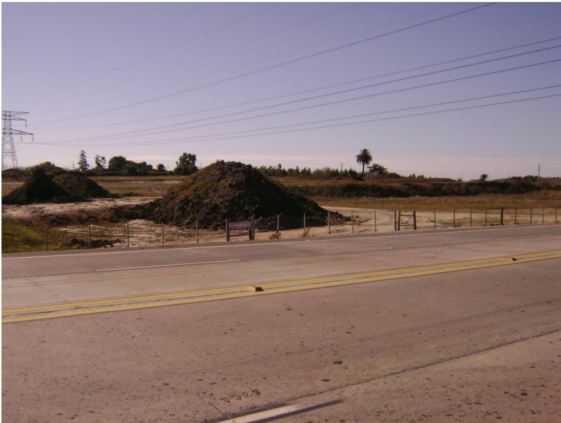
ACOPIO DE TIERRA VEGETAL PARA MANTENIMIENTO. PREDIO PROPIEDAD DE COLIER SA (9K400), EMPLEADO COMO PRESTAMO.
