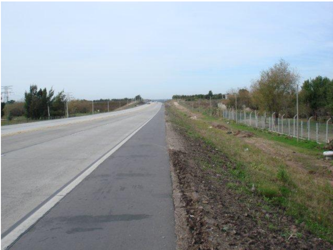
TRAMO NORDEX FORTET LADO A (+). TALUDES REVESTIDOS Y EMPASTADOS.
