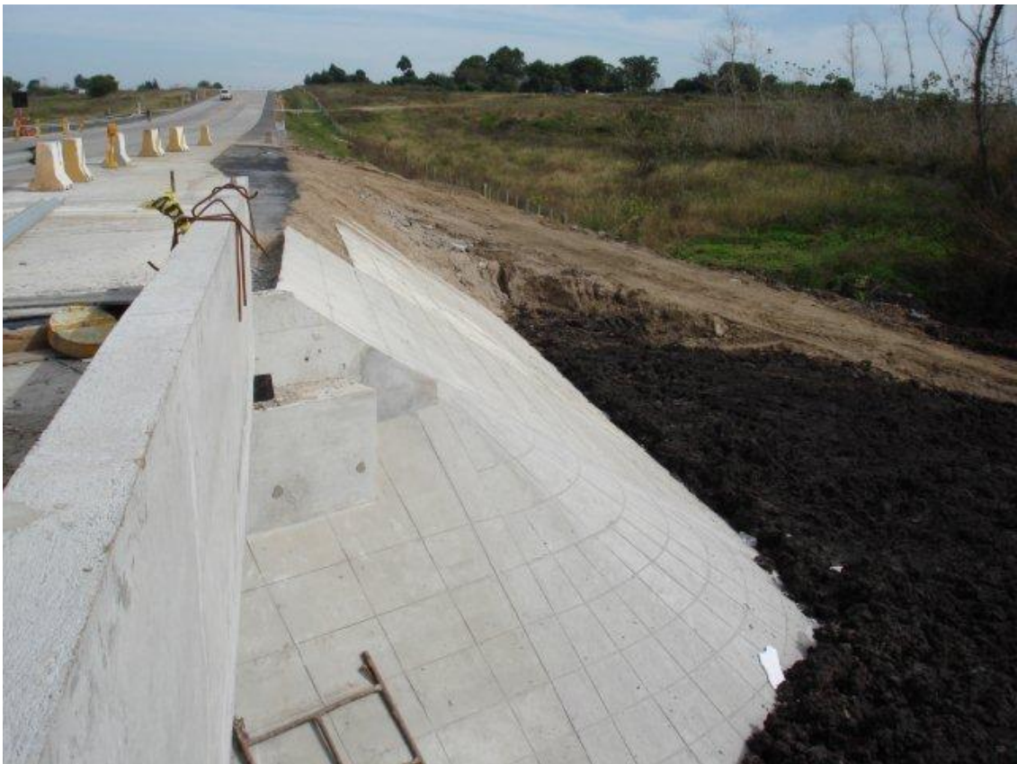
ENSANCHE Y REFUERZO DEL PUENTE MIGUELETE – VISTA DEL CUARTO DE CONO NW.
