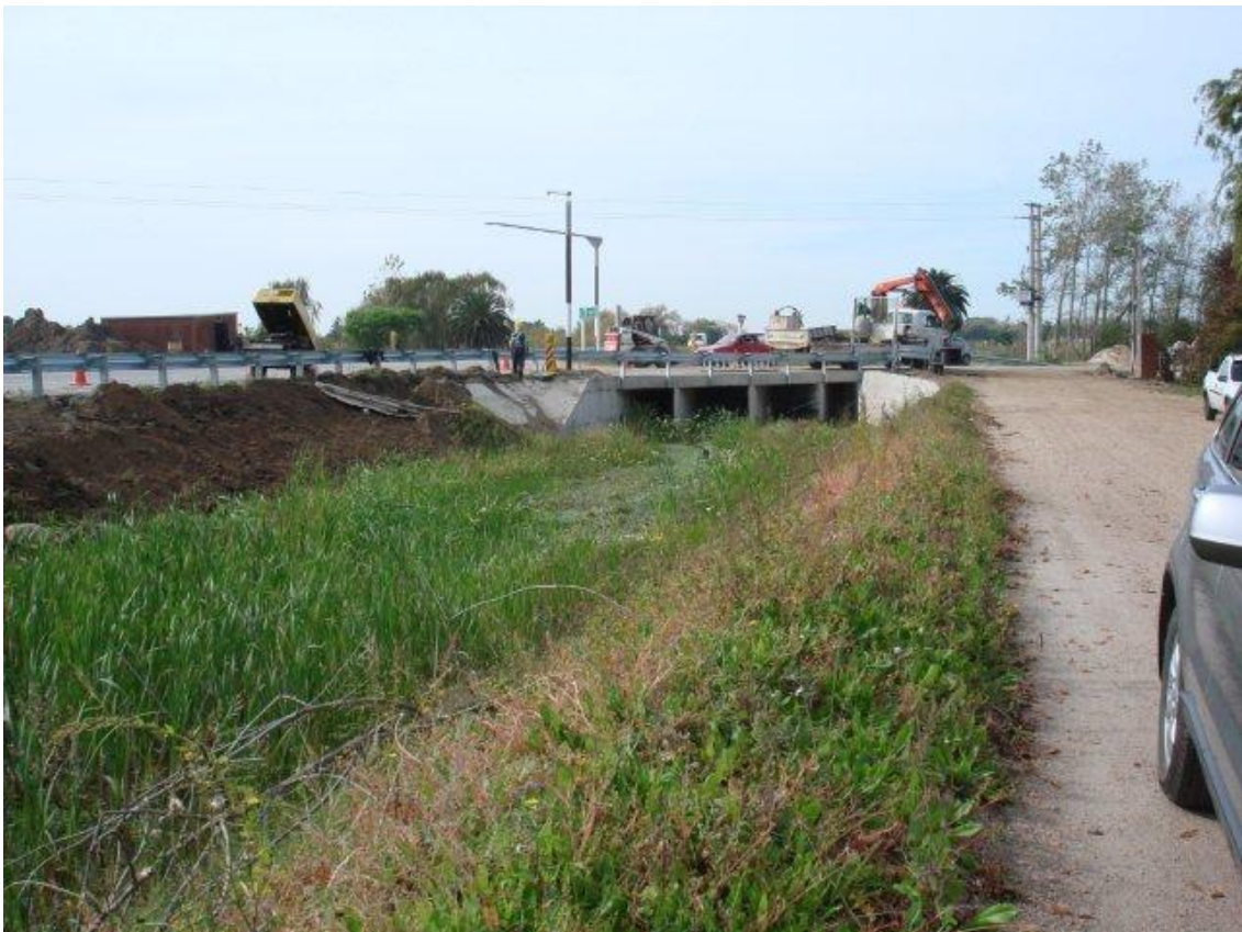
BOCA SALIDA ALCANTARILLA DE CRUCE DE CANAL CAÑADA EL DRAGÓN Y CAMINO MELILLA. REVESTIMIENTOS EN HORMIGÓN TERMINADOS. EMPRESA CCH TRABAJANDO EN SEMÁFOROS. VISTA DESDE LA CALZADA DE SERVICIO.
