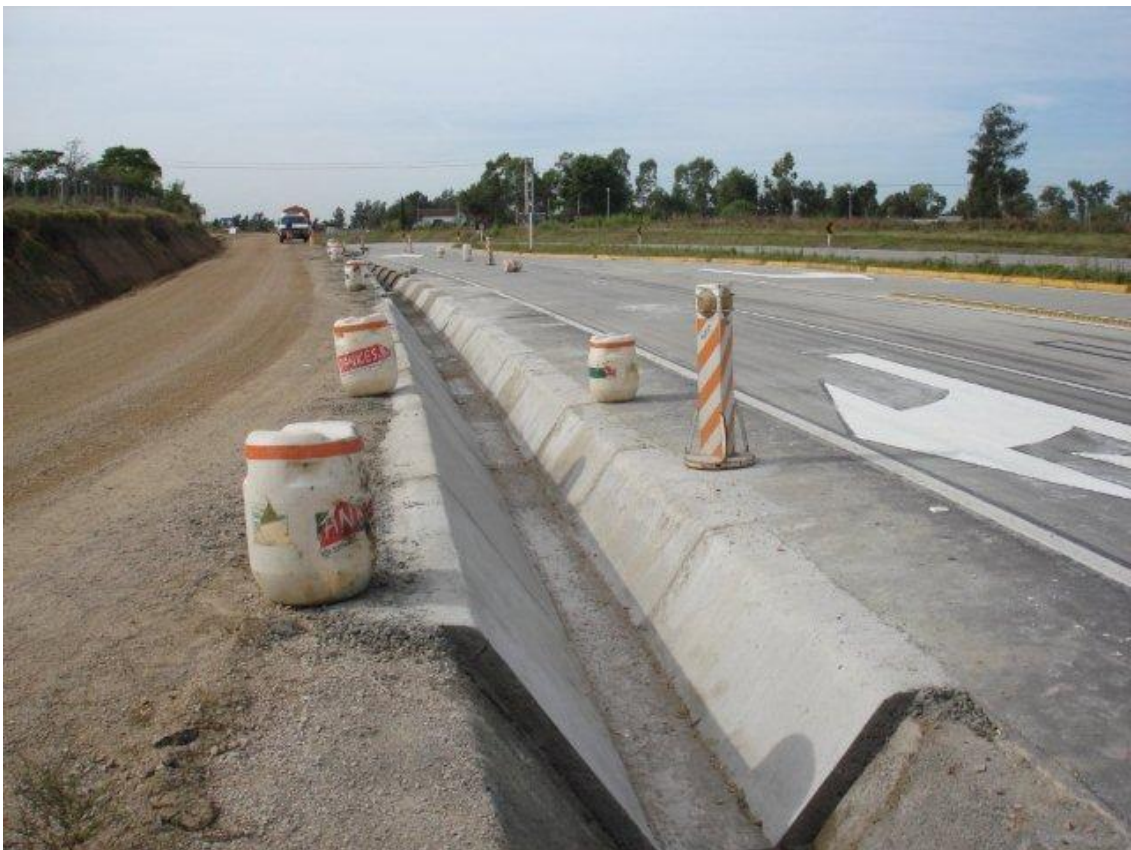
REVESTIMIENTO DE HORMIGÓN DE LA CUNETA CANAL ENTRE ACP Y LA RENGA.
