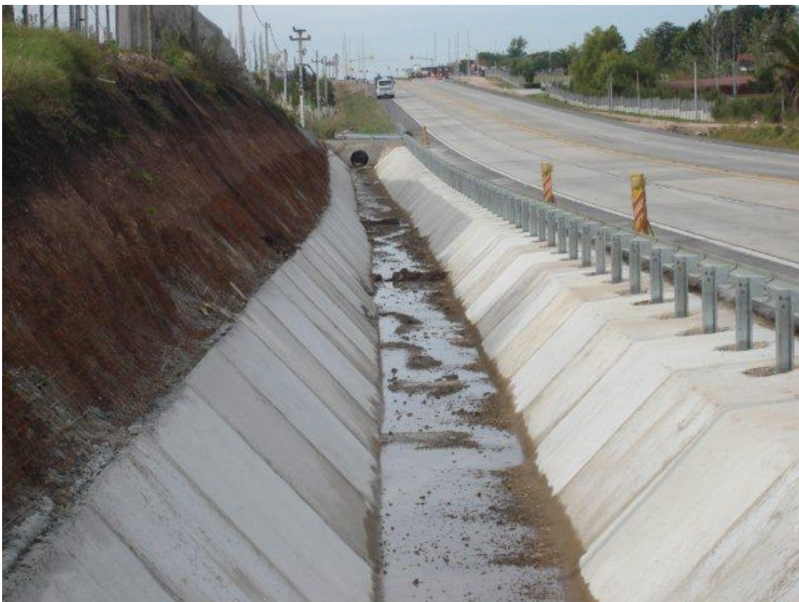
REVESTIMIENTO CUNETA TIPO ACODIKE TERMINADO (4+370 A 4+500 A (-)).
