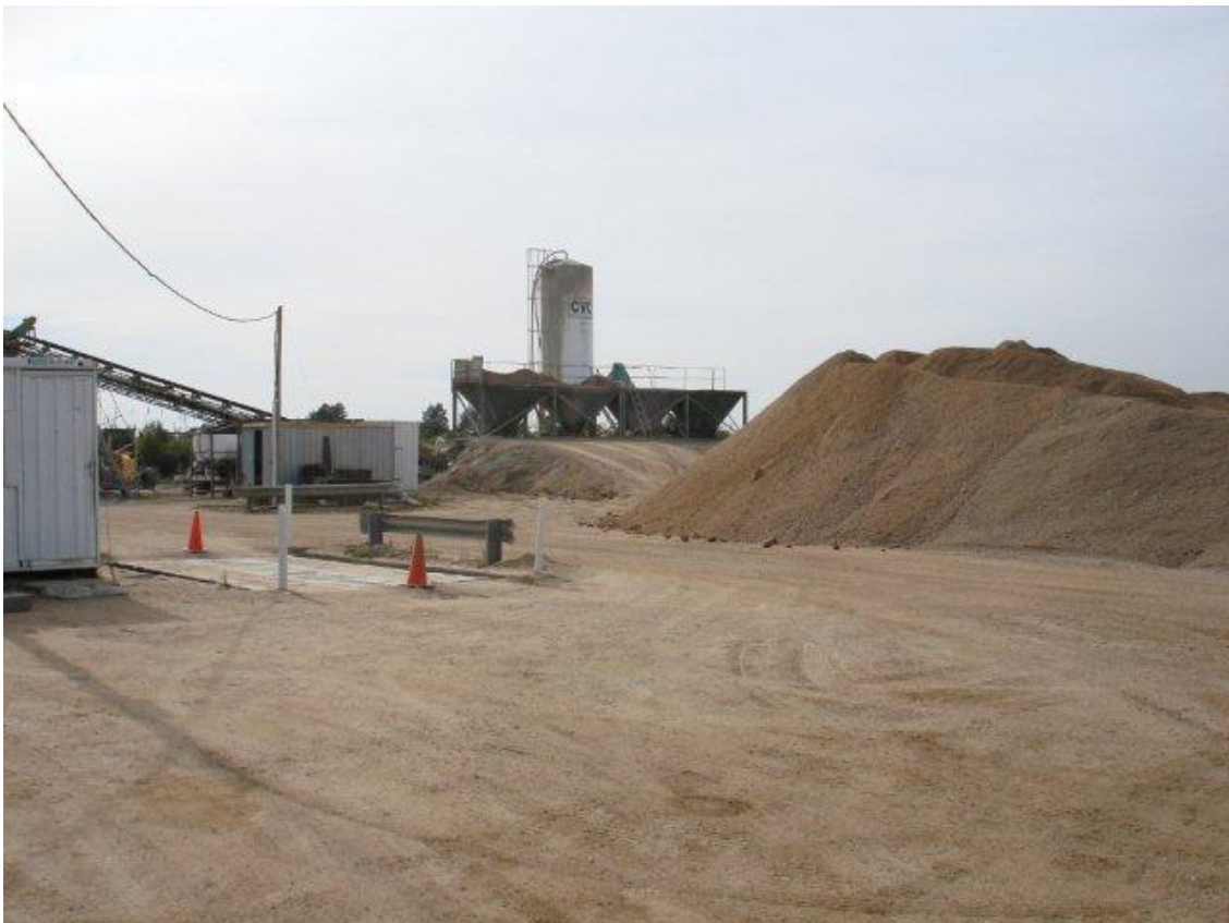
PLANTA ELABORADORA DE ESTABILIZADO GRANULAR CON CEMENTO, ACOPIO DE TOSCA, BALANZA DE CAMIONES – CVC S.A.
