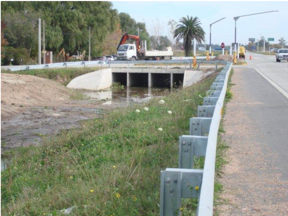
CANAL CAÑADA EL DRAGÓN LADO A (+): VISTA BOCA DE ENTRADA ALCANTARILLA MELILLA
