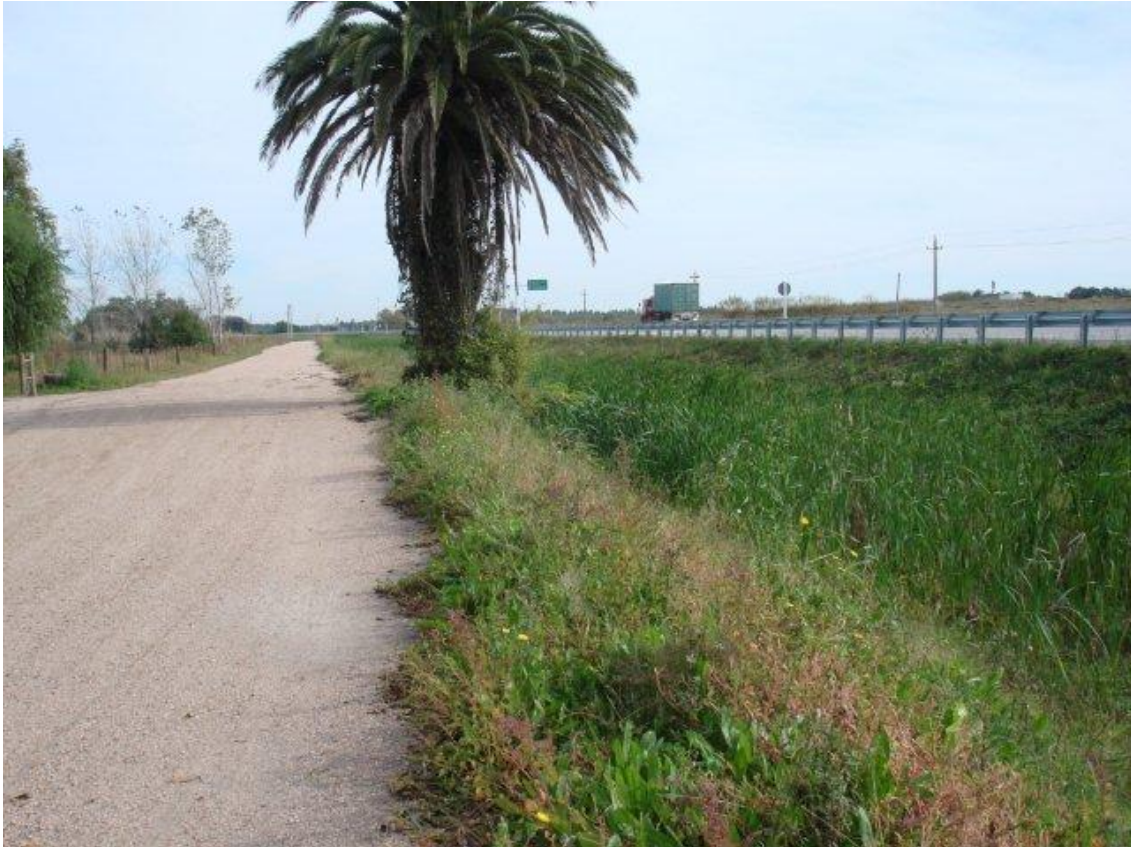
CANAL CAÑADA EL DRAGÓN – TRAMO MELILLA RUTA 5
