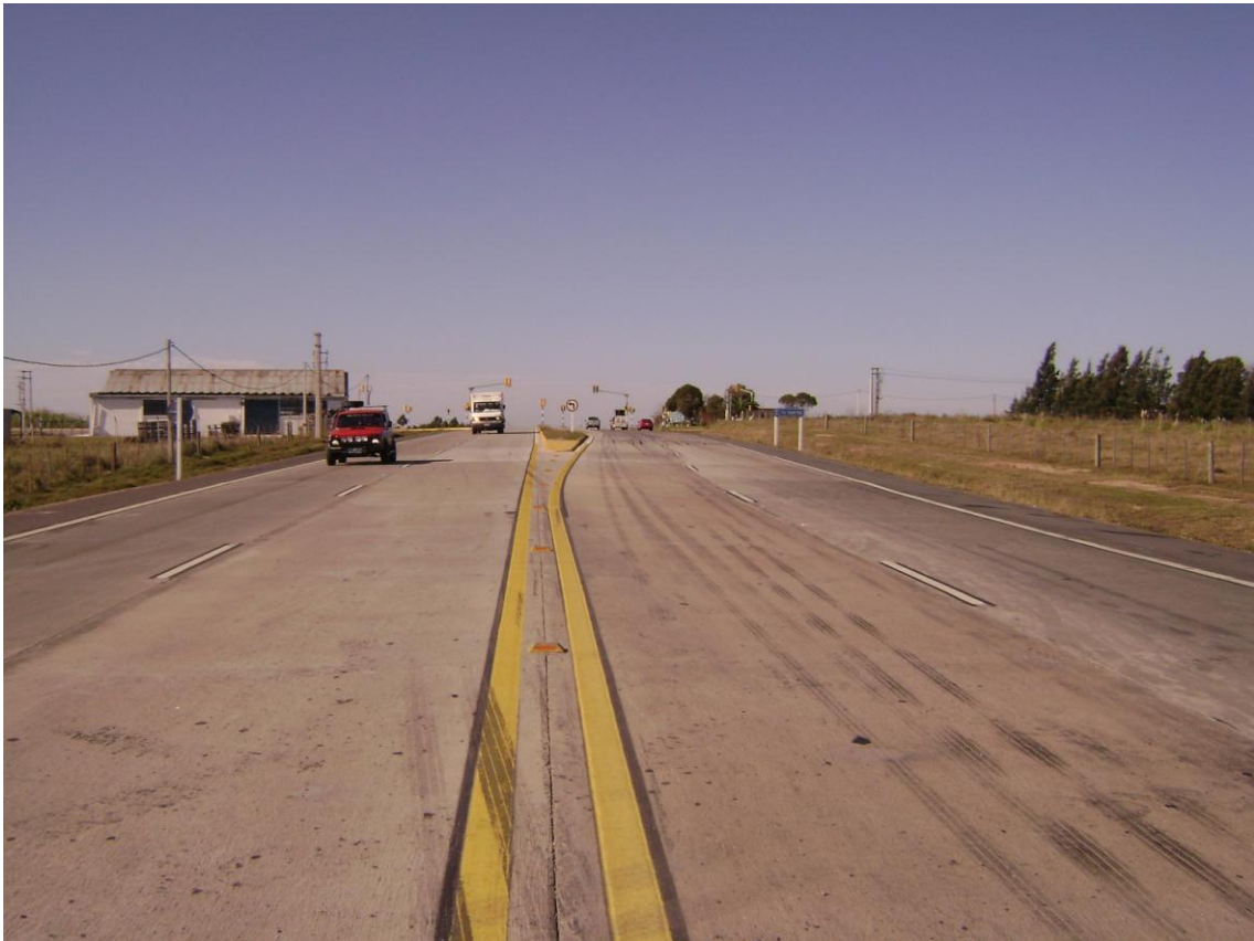
EMPALME DEL ACP CON CNEL. RAIZ, PROGRESIVAS MENORES.
