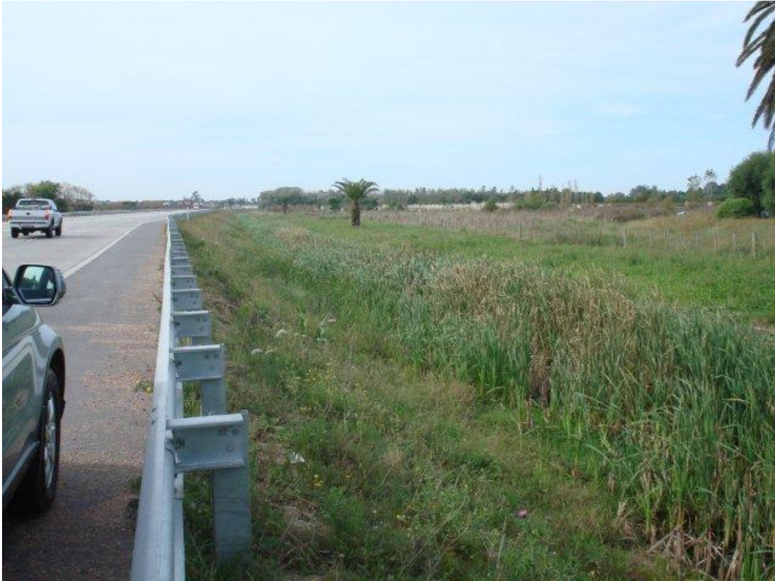
CANAL CAÑADA EL DRAGÓN LADO A (+), TRAMO MELILLA FAUQUET
