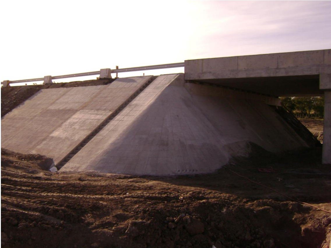
PUENTE SOBRE EL Aº MENDOZA. CUARTO DE CONO SW.
