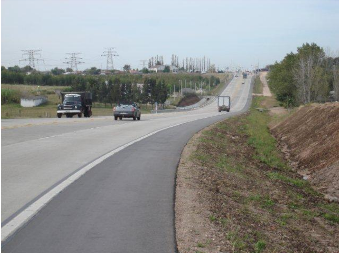
TRAMO 3+700 A CMG – TALUDES Y CONTRATALUDES REVISTIDOS.
