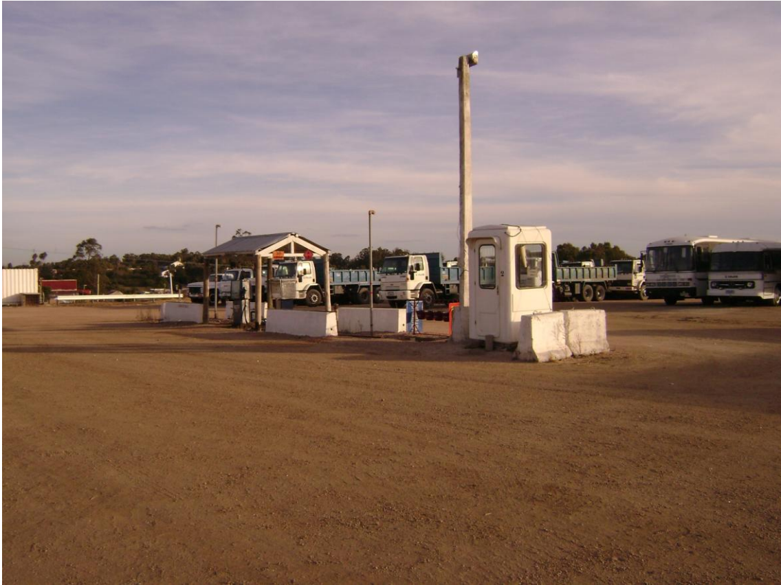
SURTIDORES DE COMBUSTIBLE, CON ELEMENTOS DE SEGURIDAD.
