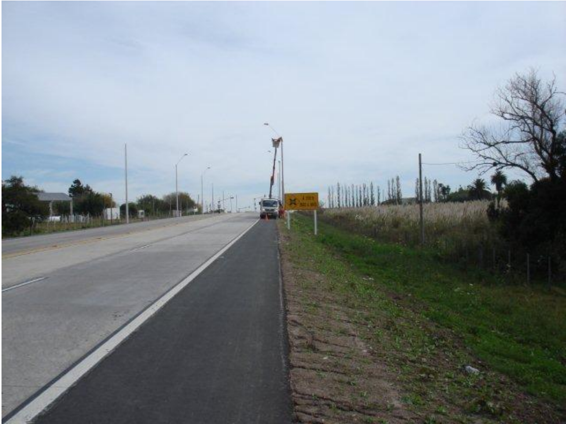
TRAMO FORTET CMG/VIA FÉRREA LADO A (-) – TALUDES EMPASTADOS. GRINOR INSTALANDO LUMINARIAS POR CONTRATO INDEPENDIENTE (ILUMINACIÓN DE EMPALMES CMG Y MENDOZA)
