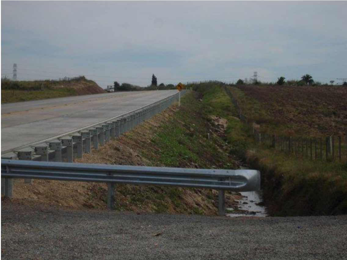
TALUD Y CONTRA TALUD EMPASTADOS LADO A (-) – VISTA DESDE ENTRADA OESTE A ACODIKE.
