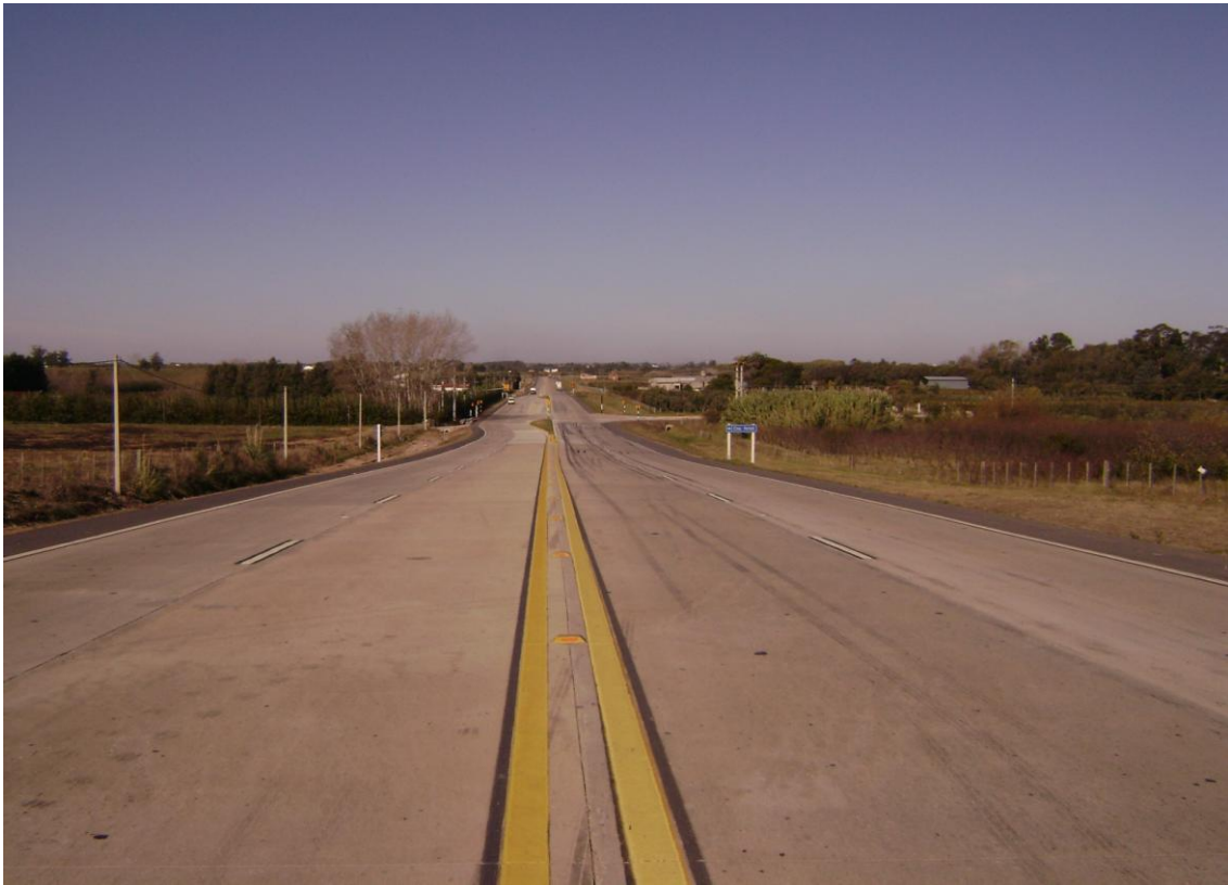
EMPALME FORTET SUR.
