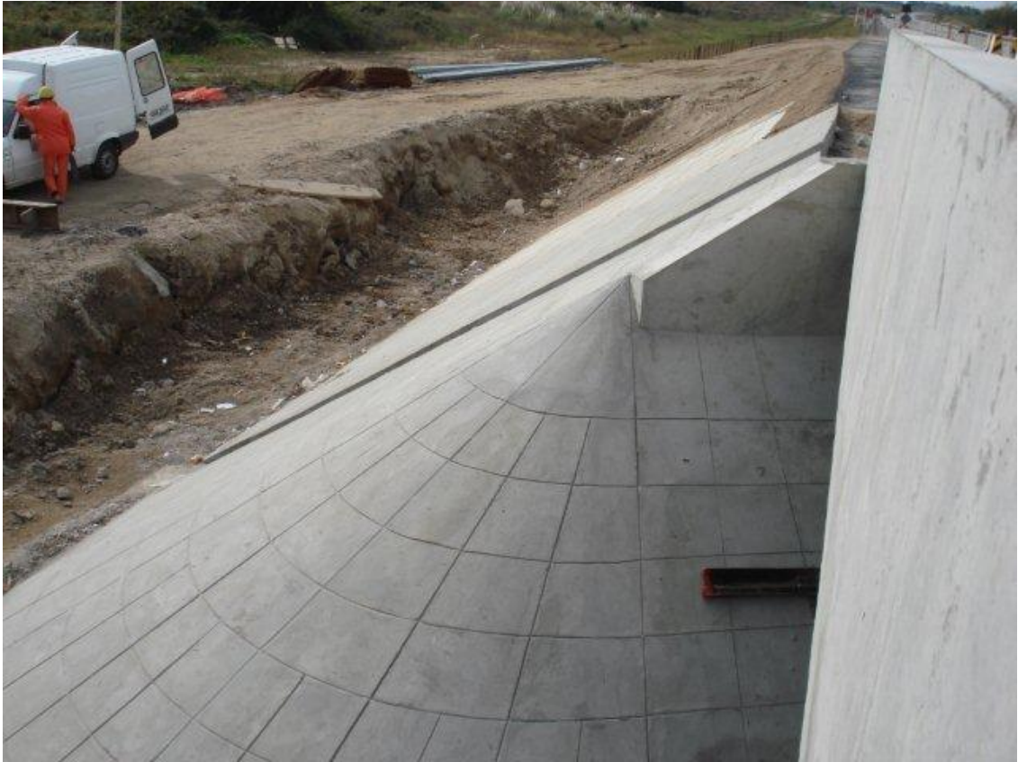
ENSANCHE Y REFUERZO DEL PUENTE MIGUELETE – VISTA DEL CUARTO DE CONO NE.
