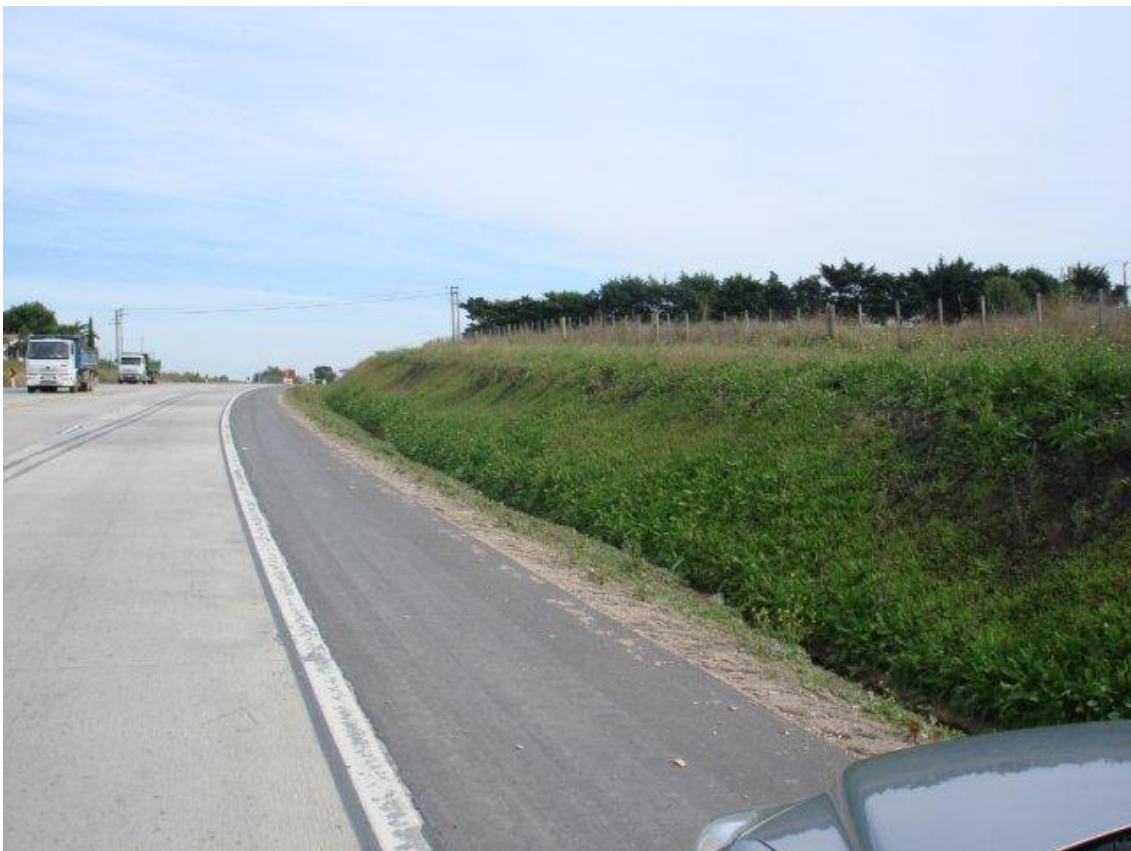
CONTRA TALUD REVESTIDO LADO A (-) – VISTA DESDE EL ESTE ACP Y LA RENGA.
