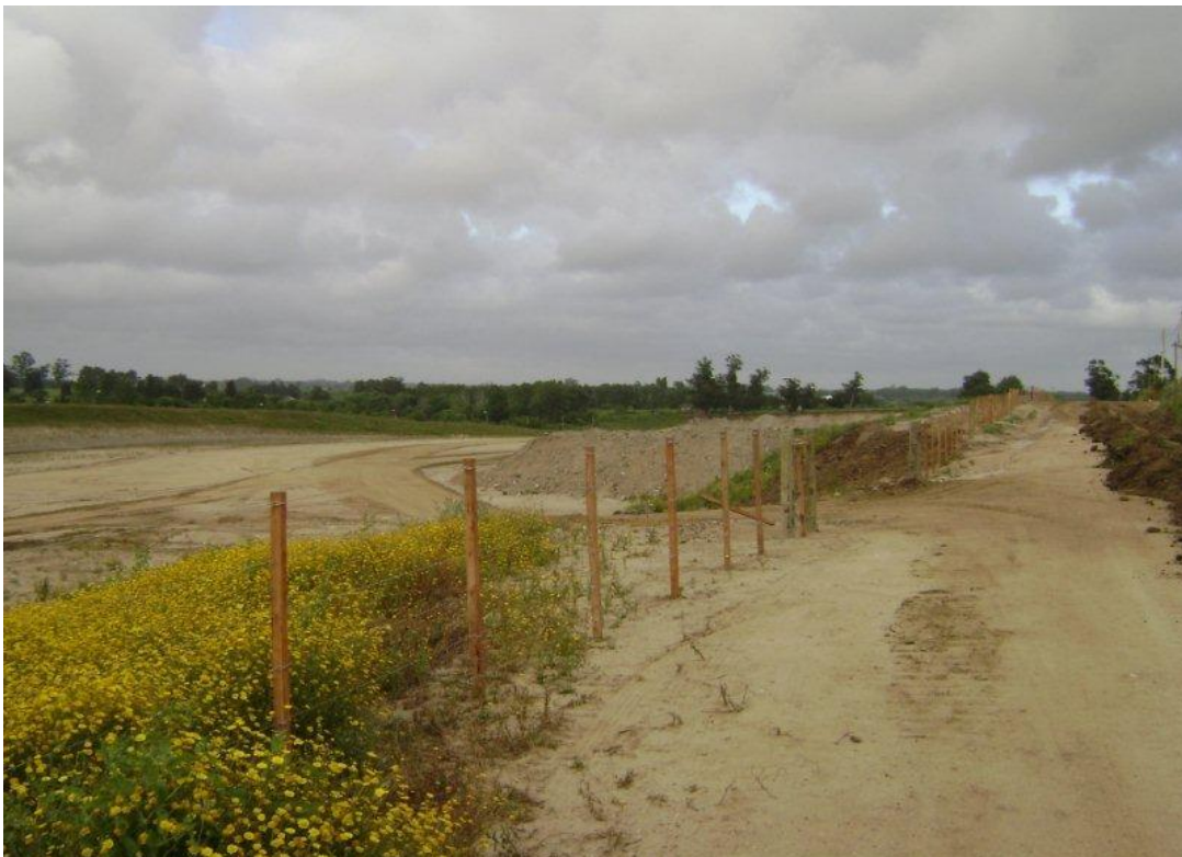
VISTA GENERAL DEL PRÉSTAMO AL FINALIZAR SU EXPLOTACIÓN (PISO EN PENDIENTE EVITANDO LA ACUMULACIÓN DE AGUA; TALUDES SUAVES Y REVESTIDOS) DICIEMBRE 2009.
