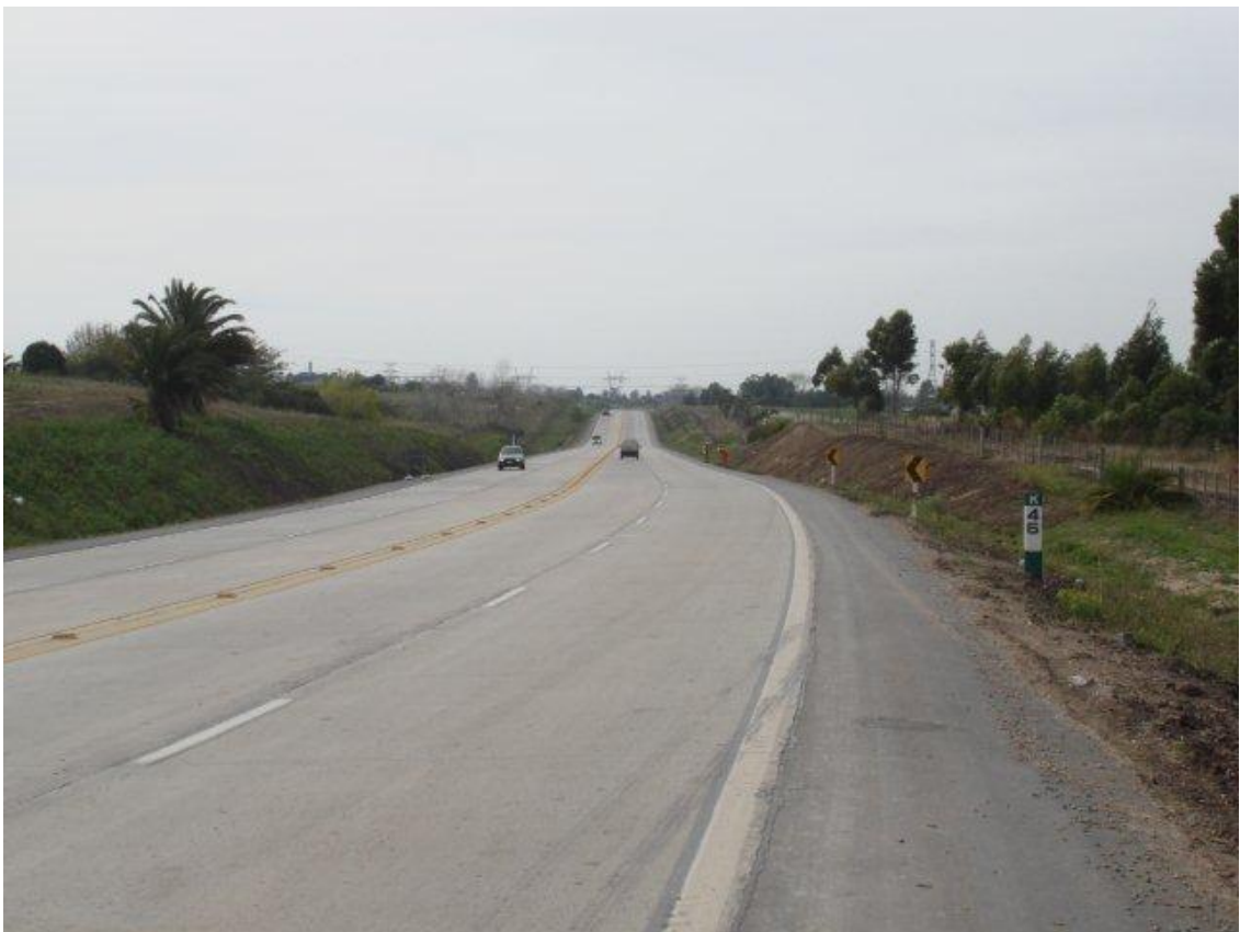
TRAMO FAUQUET A CMG - TALUDES Y CONTRA TALUDES REVESTIDOS Y EMPASTADOS.
