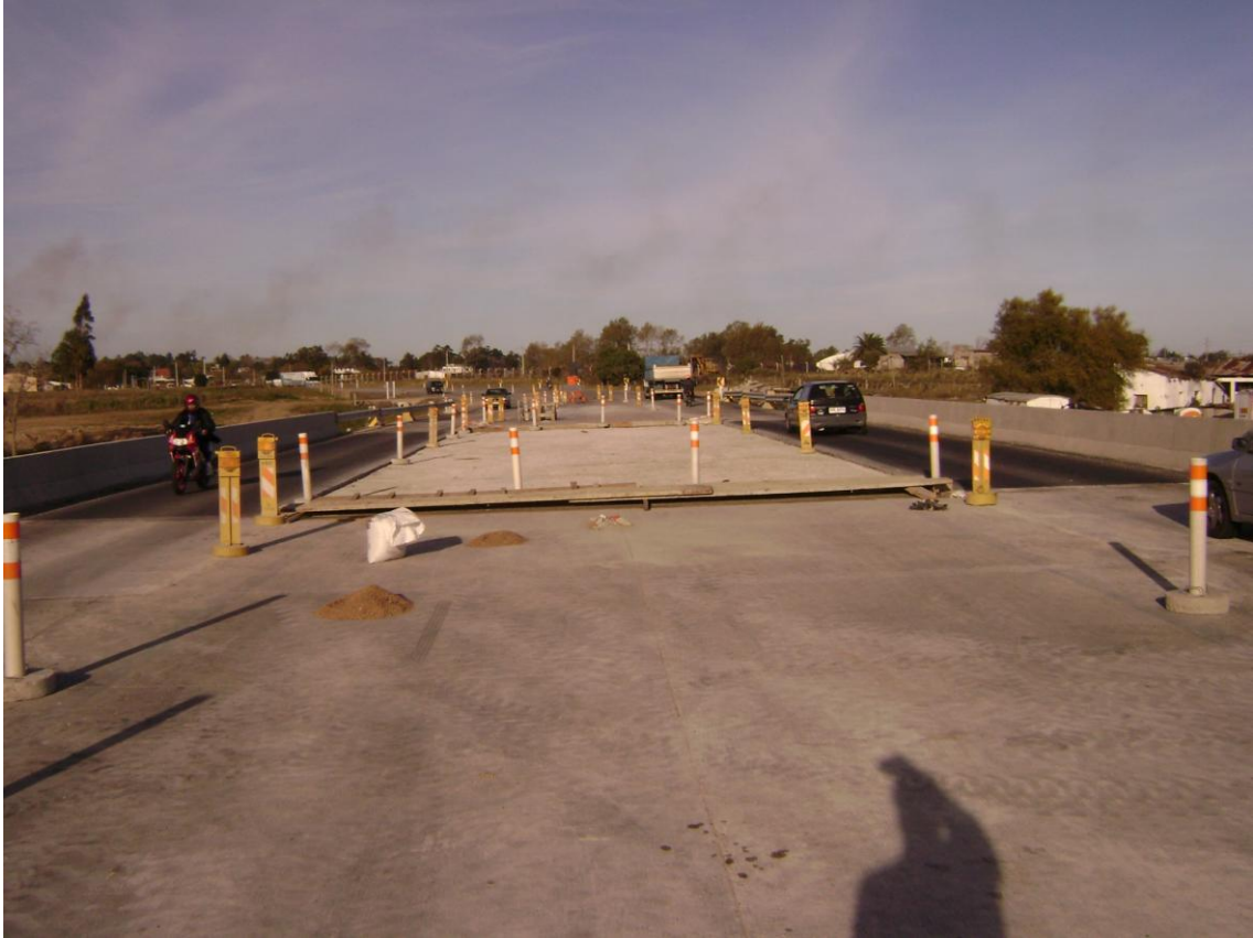
OTRA VISTA DEL PUENTE SOBRE EL Aº MENDOZA.
