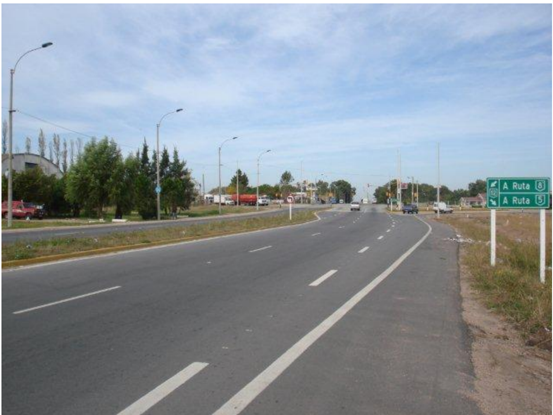
EMPALME CMG. – VISTA DESDE EL NORTE DEL ACP.
