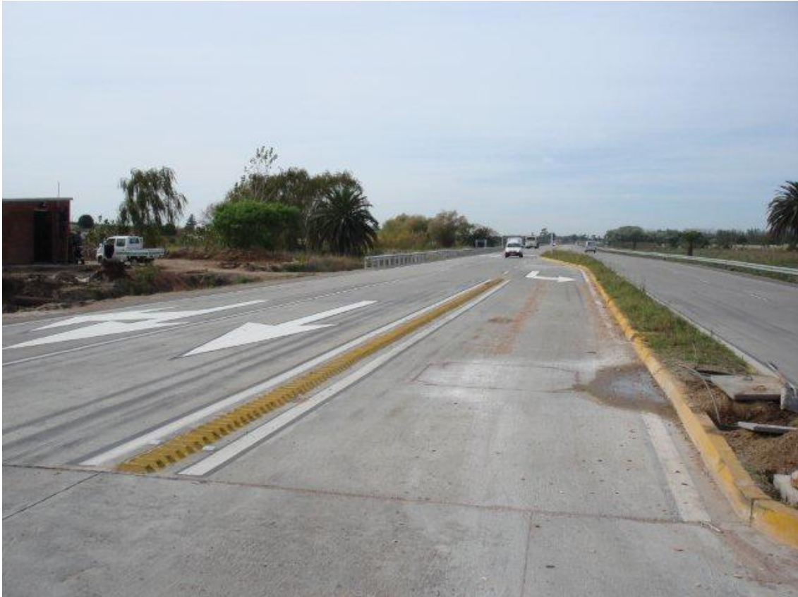
EMPALME MELILLA – EMPRESA CCH TRABAJANDO EN LA INSTALACIÓN DE SEMAFOROS.
