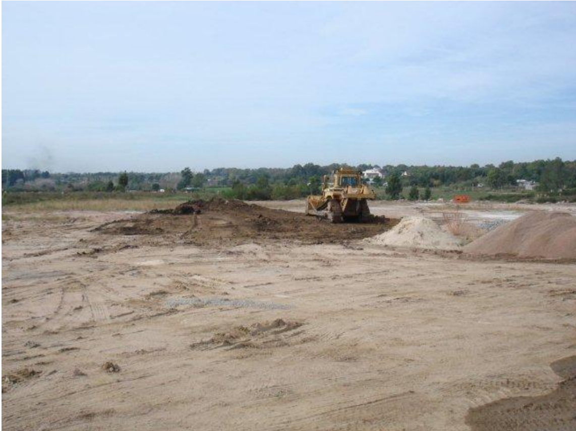
BULLDOZER REALIZANDO TRABAJOS DE EXTENDIDO Y ENTERRAMIENTO DE MATERIALES DE DESCARTE (ESCOMBROS, RESTOS DE HORMIGONES DE LIMPIEZA Y/O DESCARTE) EN LA PLATAFORMA DEL OBRADOR.
