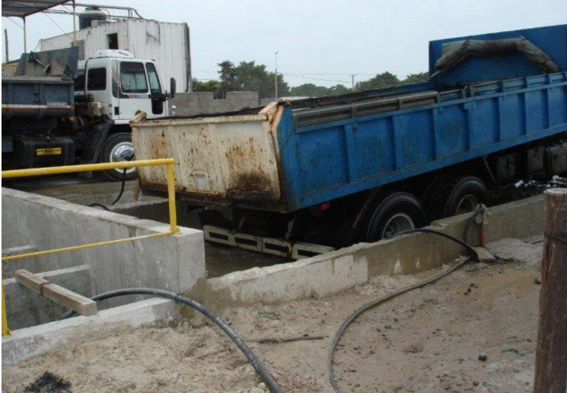
RAMPA DE LAVADO DE CAJAS DE CAMIONES
