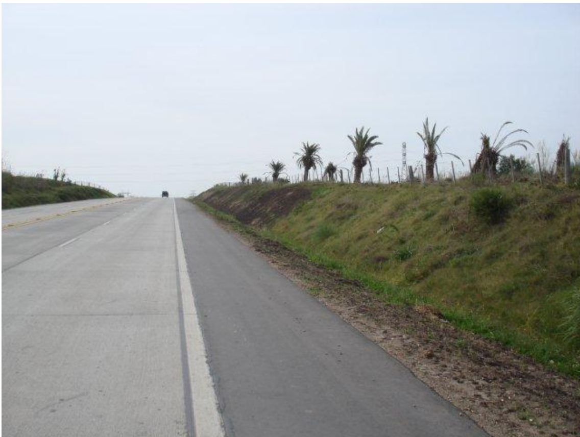
TRAMO FAUQUET A CMG LADO A (+) – CONTRA TALUD REVESTIDO Y PALMERAS TRANSPLANTADAS CON REBROTOS DE HOJAS NUEVAS AL TOPE.
