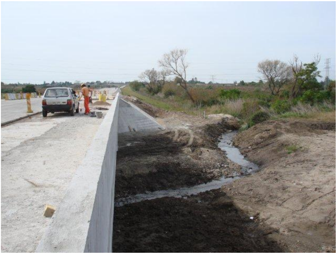
ENSANCHE Y REFUERZO DEL PUENTE MIGUELETE – VISTA DEL ENCAUZAMIENTO DEL CAUCE AGUAS ABAJO.
