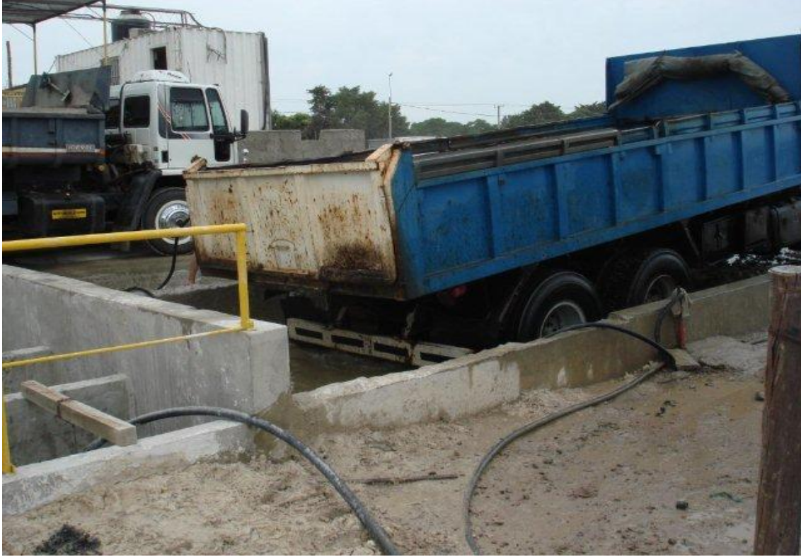
RAMPA DE LAVADO DE CAJAS DE CAMIONES
