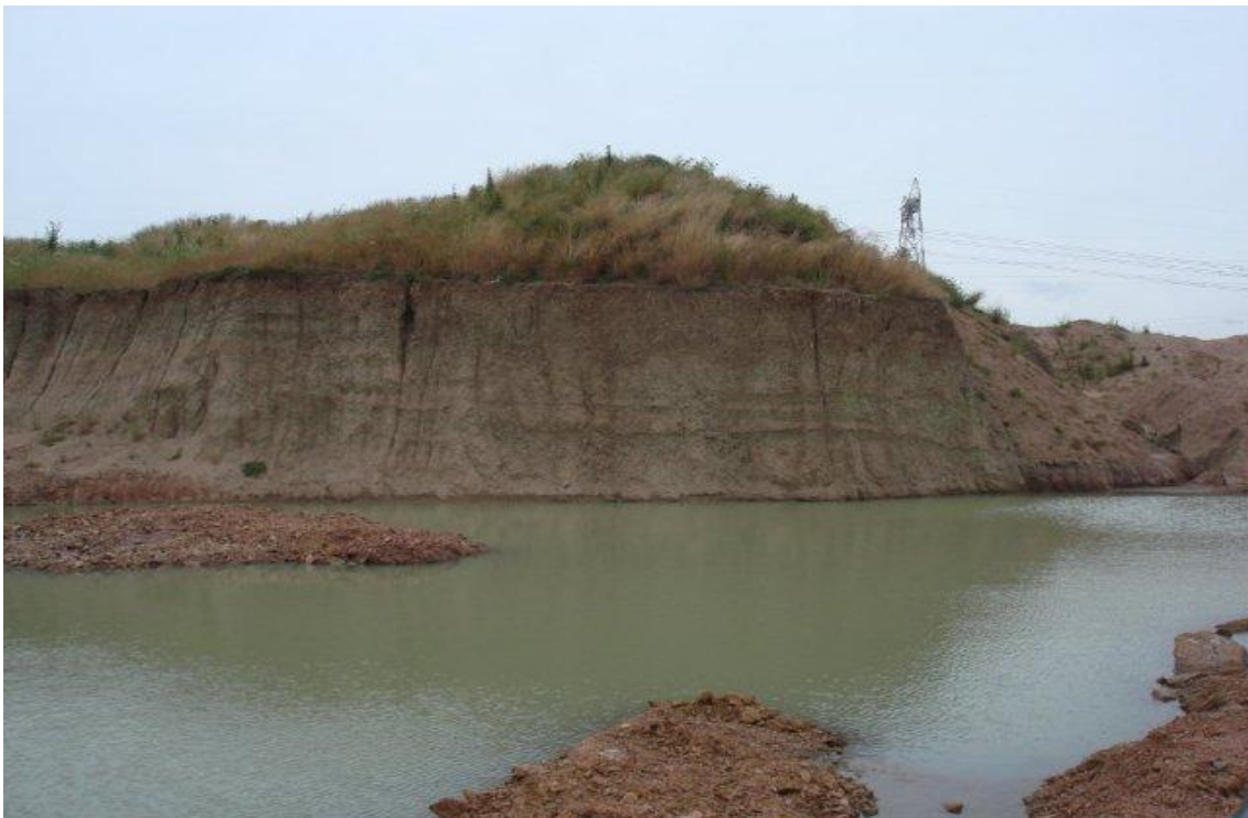
PRESTAMO #4. PISO INUNDADO DEBIDO A LLUVIAS RECIENTES. DESTAPE DE CANTERA COMERCIAL.
