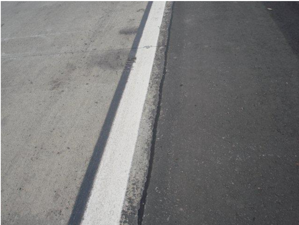
JUNTA SELLADA ENTRE BORDE DE CALZADA Y BANQUINA. SELLADOR CRAFCO POLIFLEX TIPO 1.
