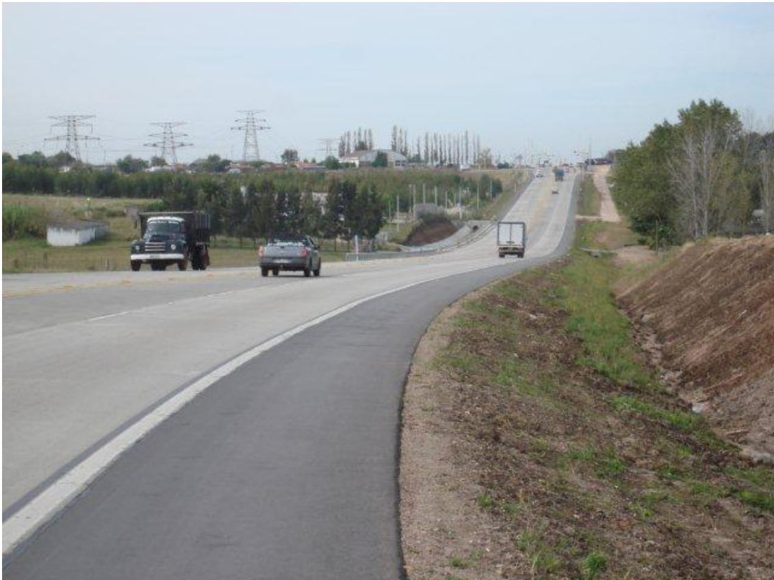
TRAMO 3+700 A CMG – TALUDES Y CONTRATALUDES REVESTIDOS.
