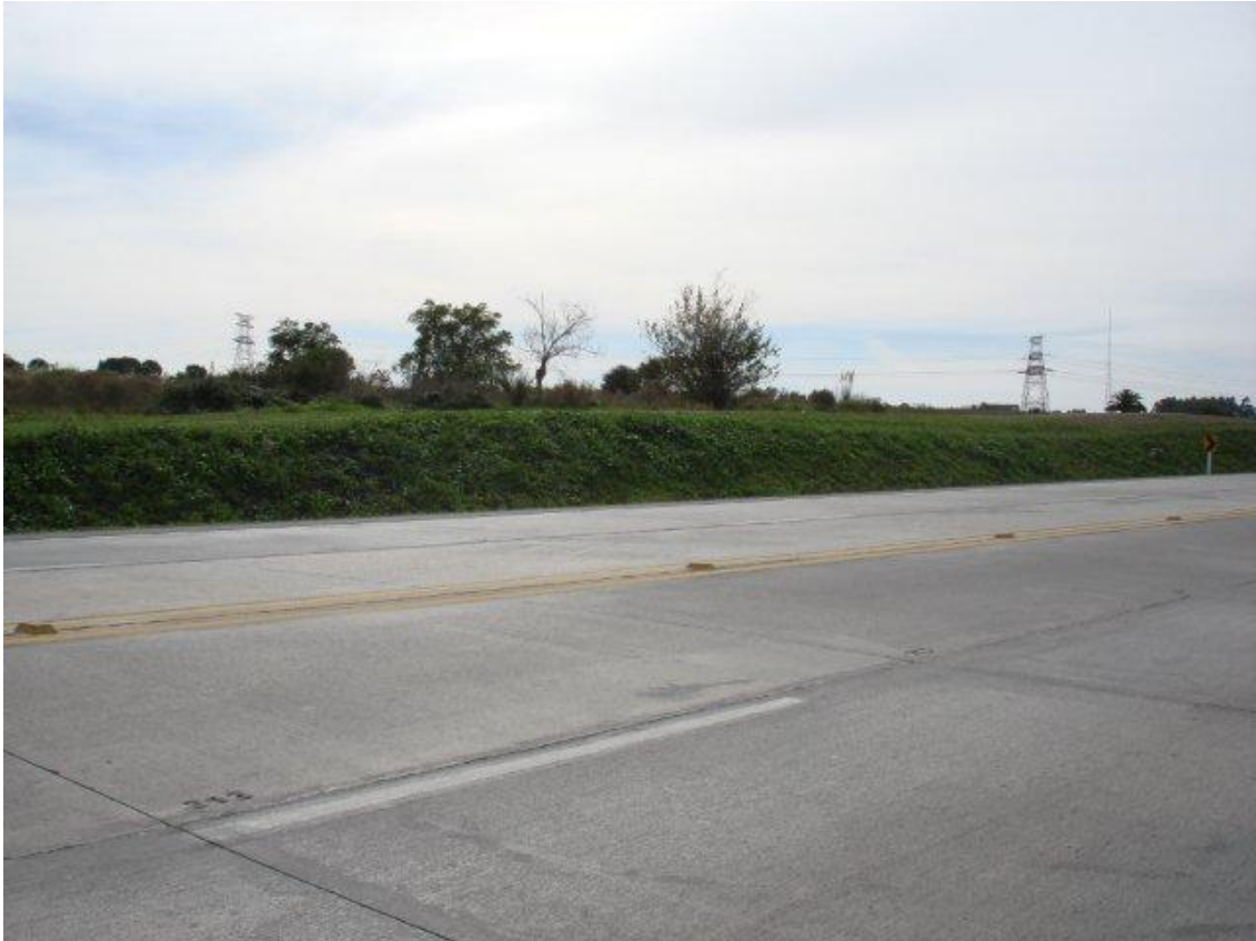
TRAMO FAUQUET A CMG LADO A (-) – CONTRA TALUD REVESTIDO.
