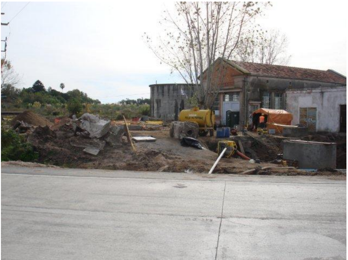
EMPALME MELILLA – AL FONDO OBRA EN PLANTA DE BOMBEO DE OSE A CARGO DE TEYMA Y ESPINA.
