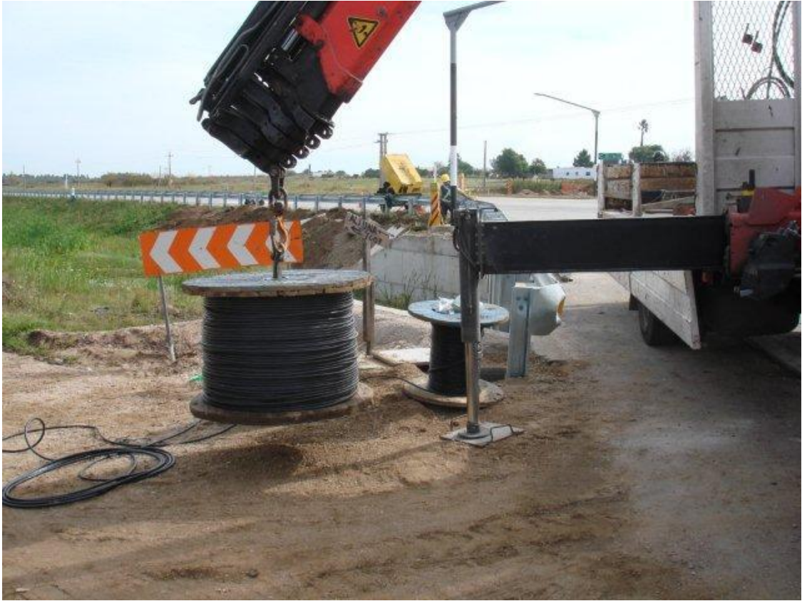
CAMION GRÚA DE CCH MOVILIZANDO BOBINA DE CABLE.
