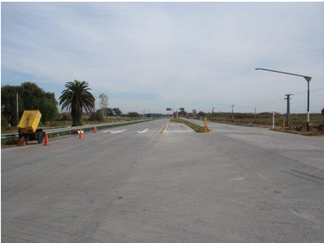
TRAMO MELILLA A RUTA 5 – CANTERO EMPASTADO
