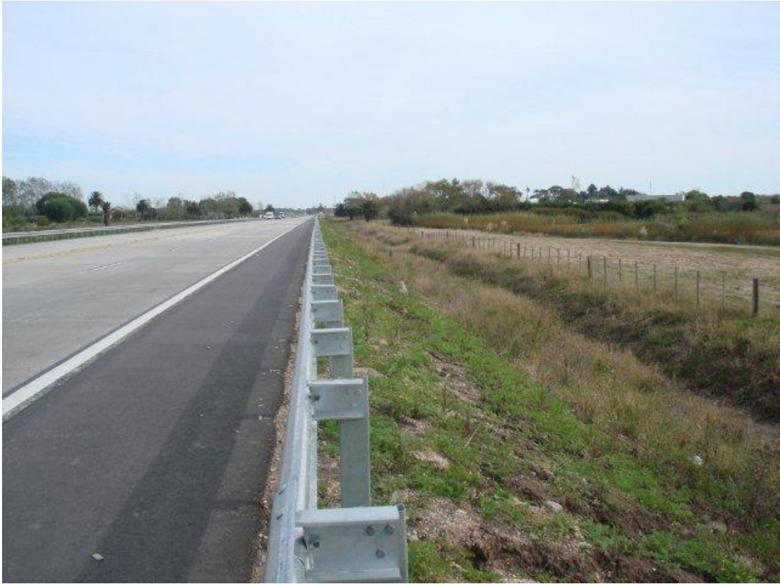
CANAL CAÑADA EL DRAGÓN LADO A (-): FAUQUET A MELILLA. TALUDES EMPASTADOS.
