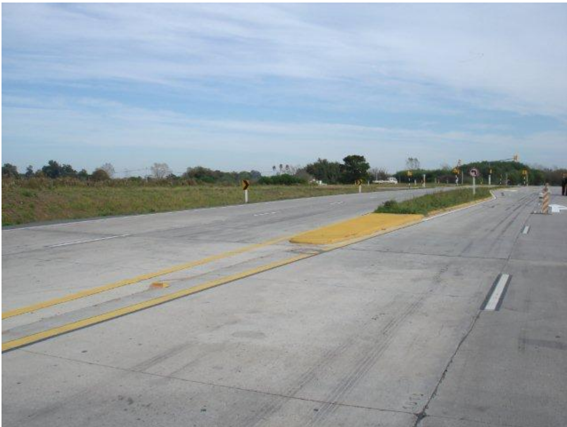
EMPALME FAUQUET PROGRESIVAS MAYORES. CANTEROS CENTRALES Y CONTRA TALUDES EMPASTADOS.
