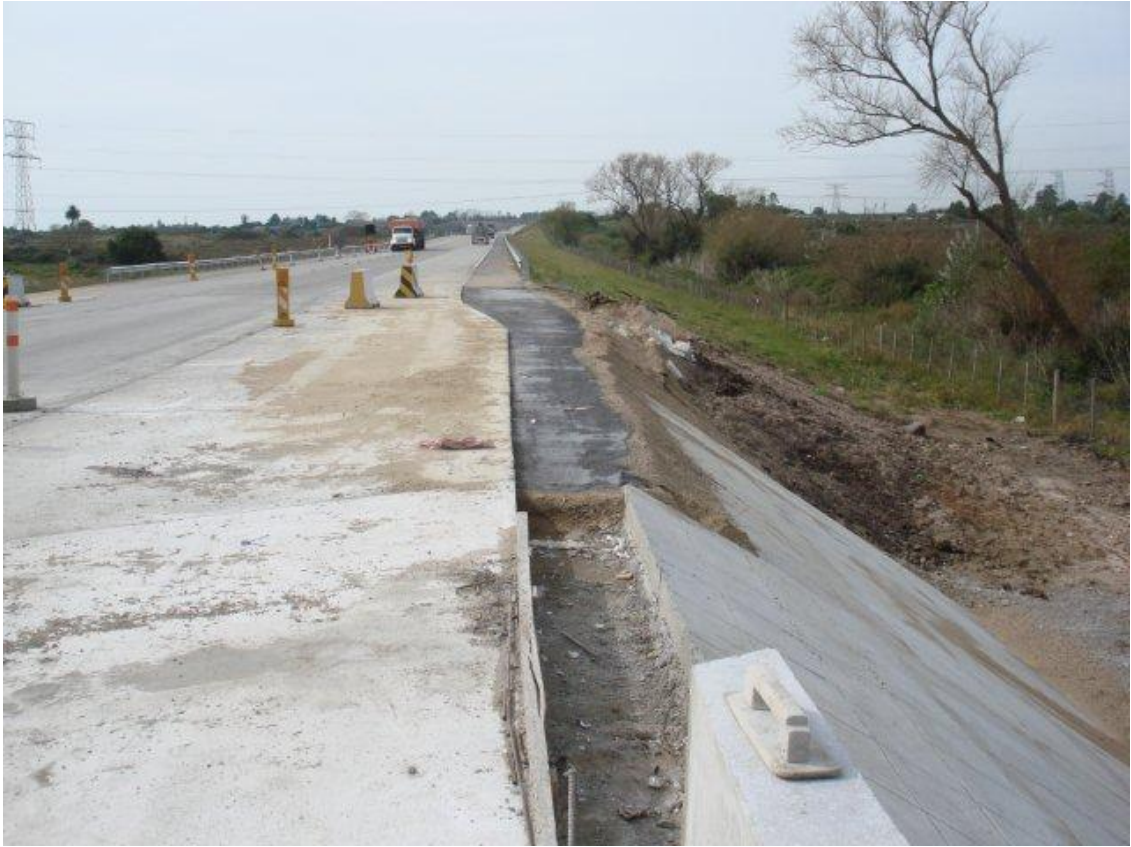
ENSANCHE Y REFUERZO DEL PUENTE MIGUELETE – VISTA DEL CUARTO DE CONO SE.
