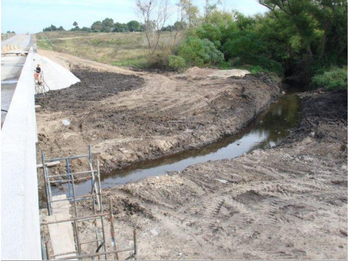
ENSANCHE Y REFUERZO DEL PUENTE MIGUELETE – VISTA DEL ENCAUZAMIENTO DEL CAUCE AGUAS ARRIBA.
