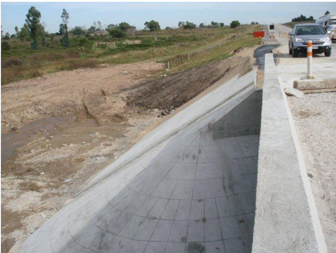
ENSANCHE Y REFUERZO DEL PUENTE MIGUELETE – VISTA DEL CUARTO DE CONO SW.
