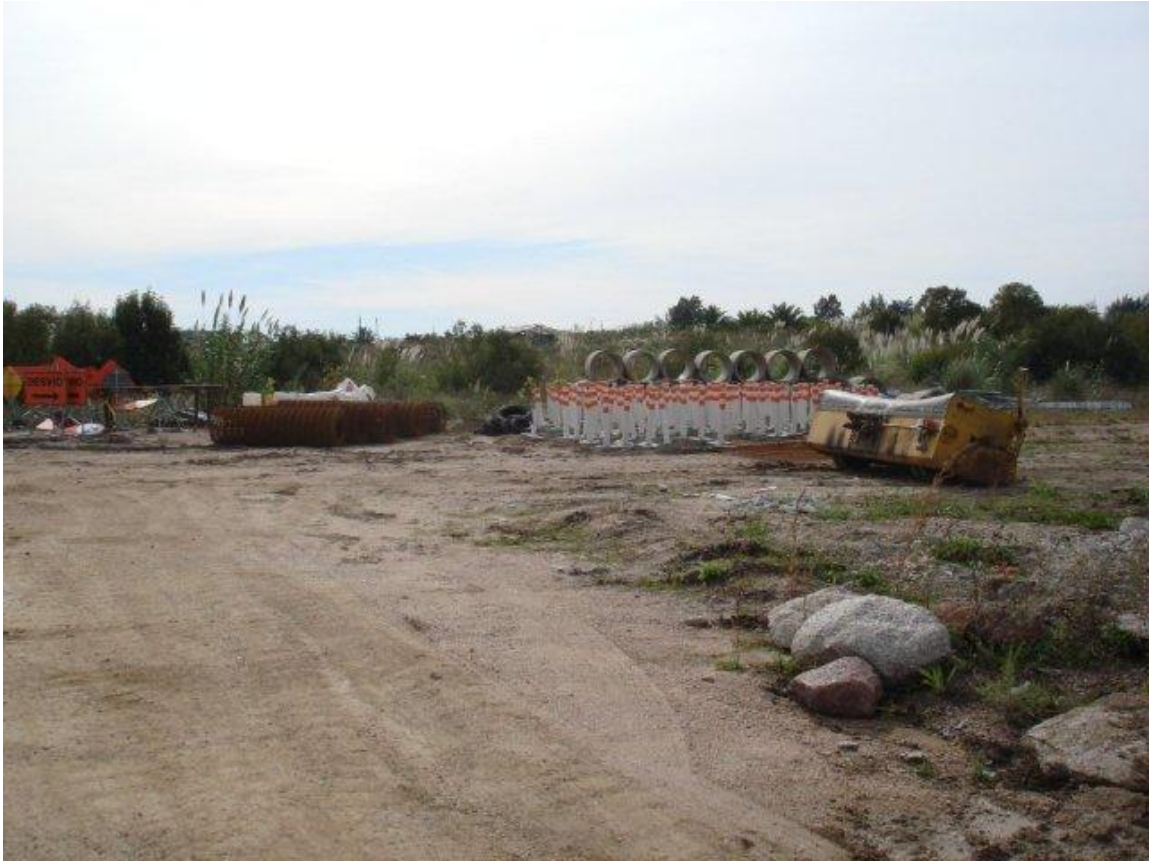
ZONA DE ACOPIO DE MATERIALES.
