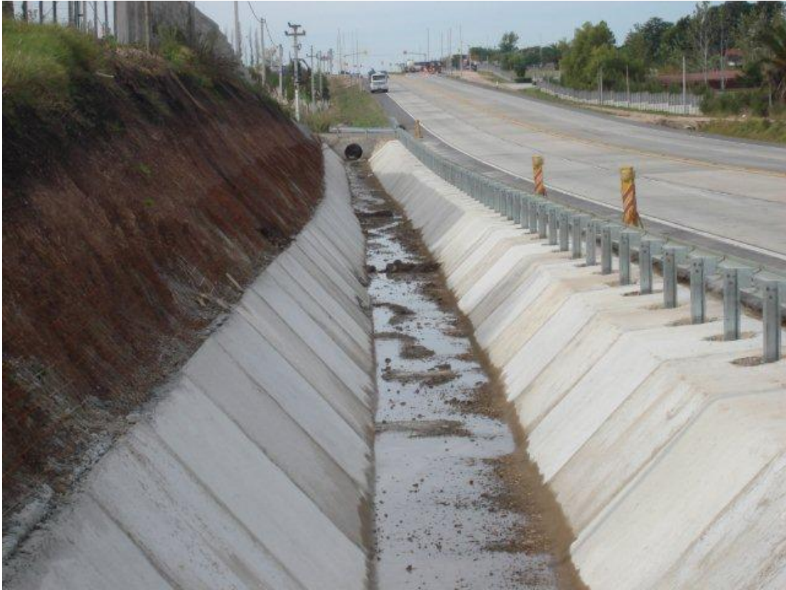
REVESTIMIENTO CUNETETA TIPO ACODIKE TERMINADO (4+370 A 4+500 A (-)). FALTA REVESTIR RESTO DE CONTRA TALUD. FINALIZACIÓN PREVISTA PARA EL 7 DE MAYO 2010.
