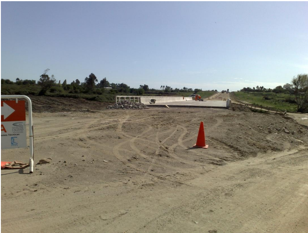
Nuevo Puente sobre el Aº Miguelete
