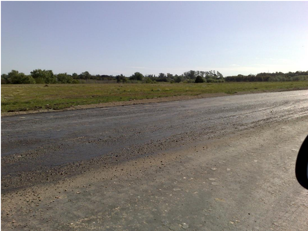
Acondicionamiento de faja
