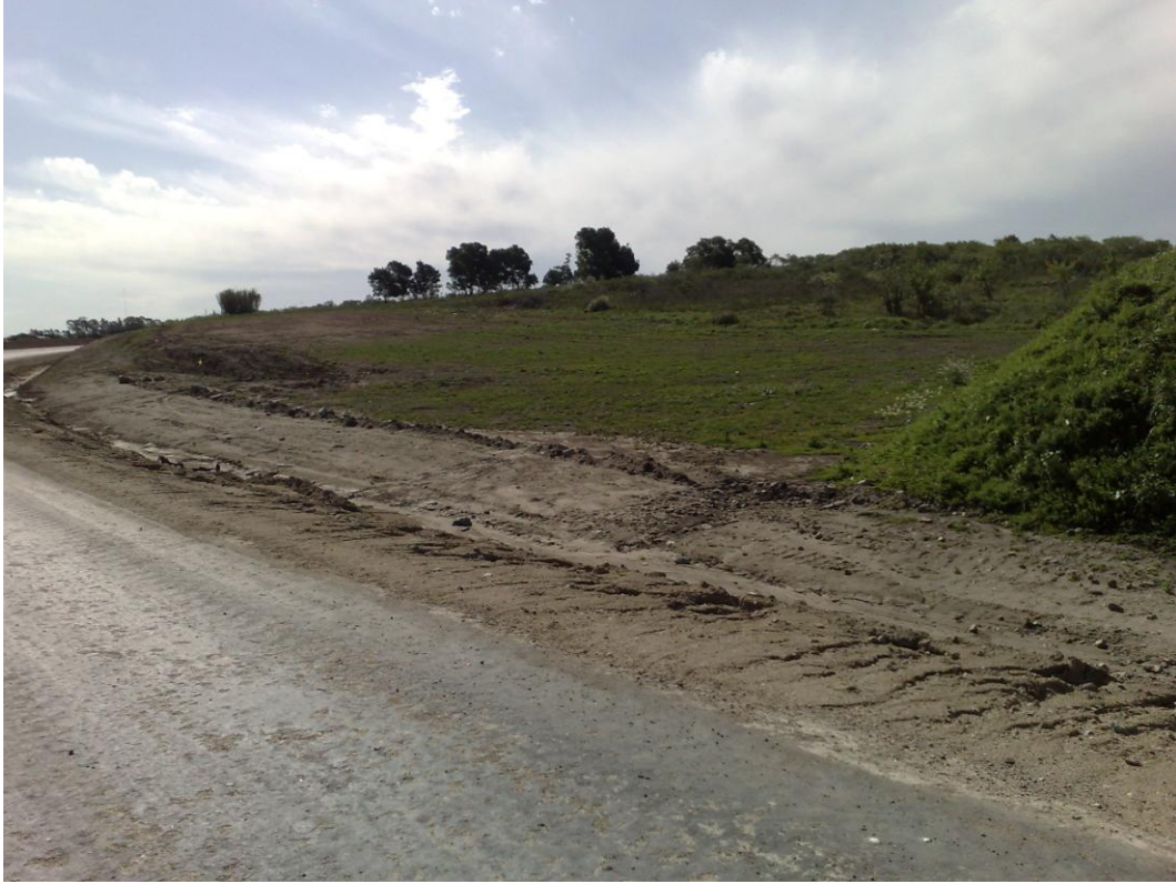
Acondicionamiento de faja
