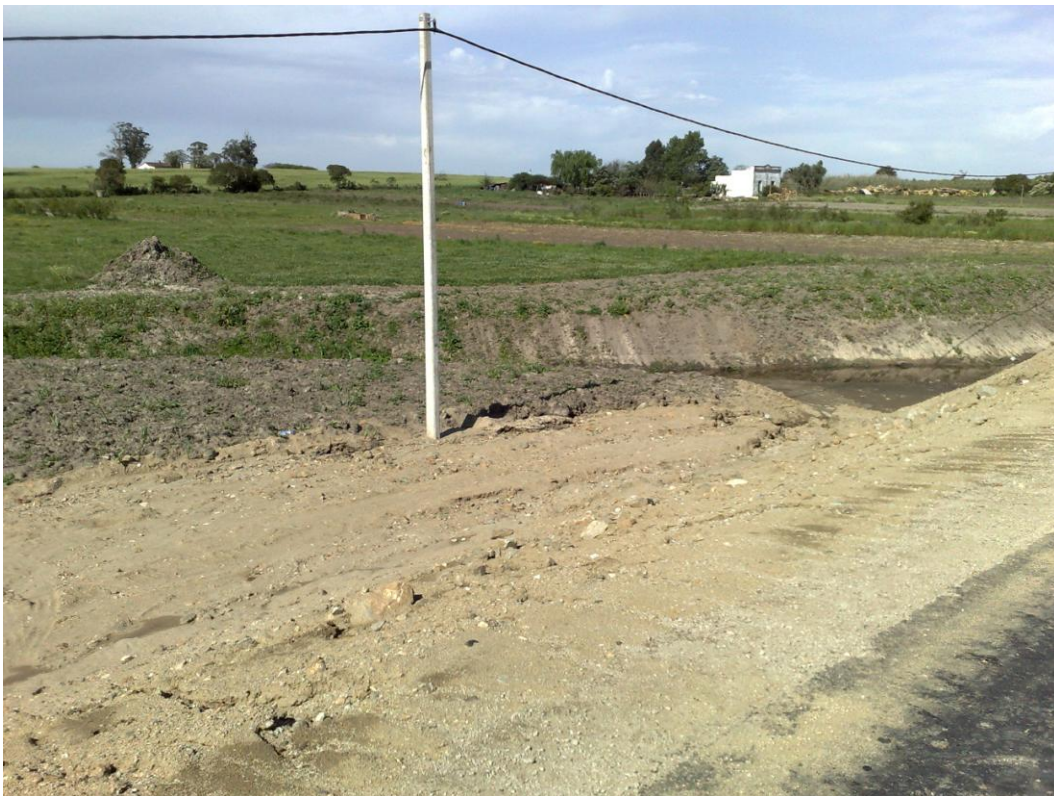
Acondicionamiento de cauces en alcantarillas
