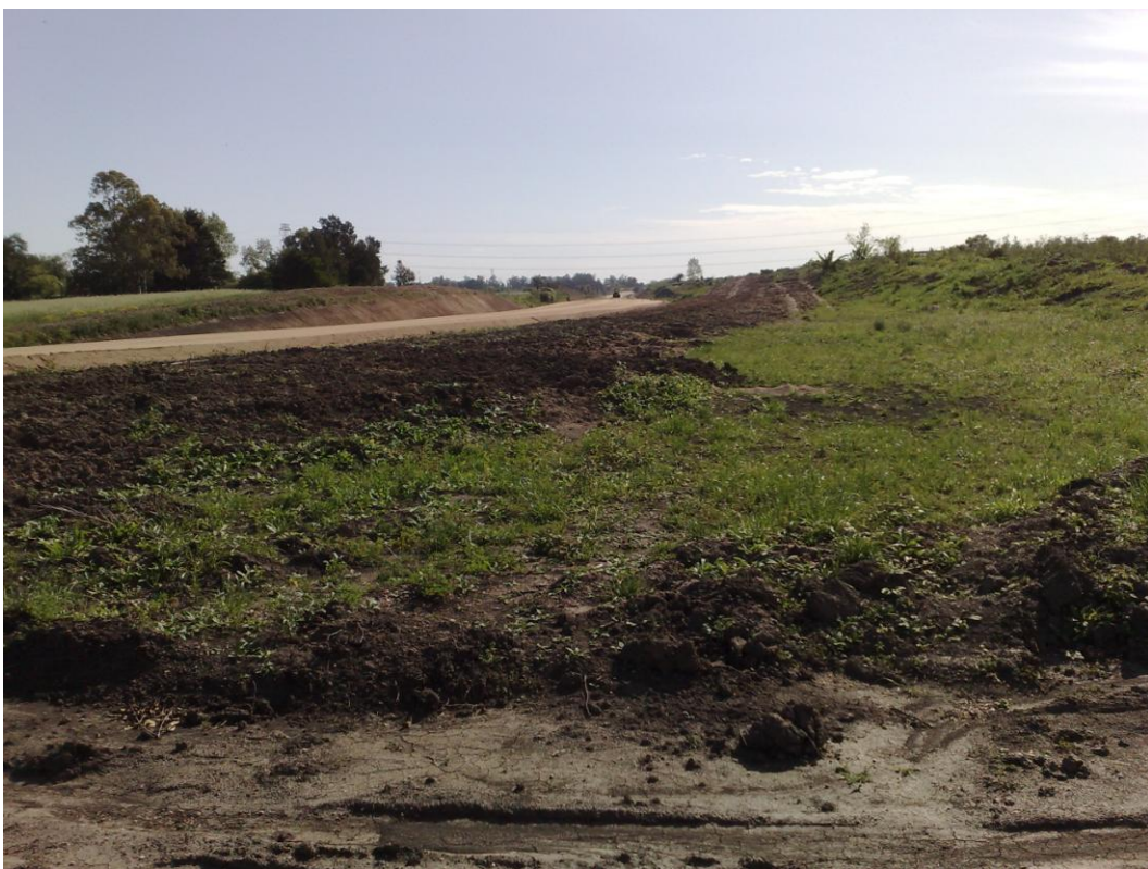
Acondicionamiento de faja
