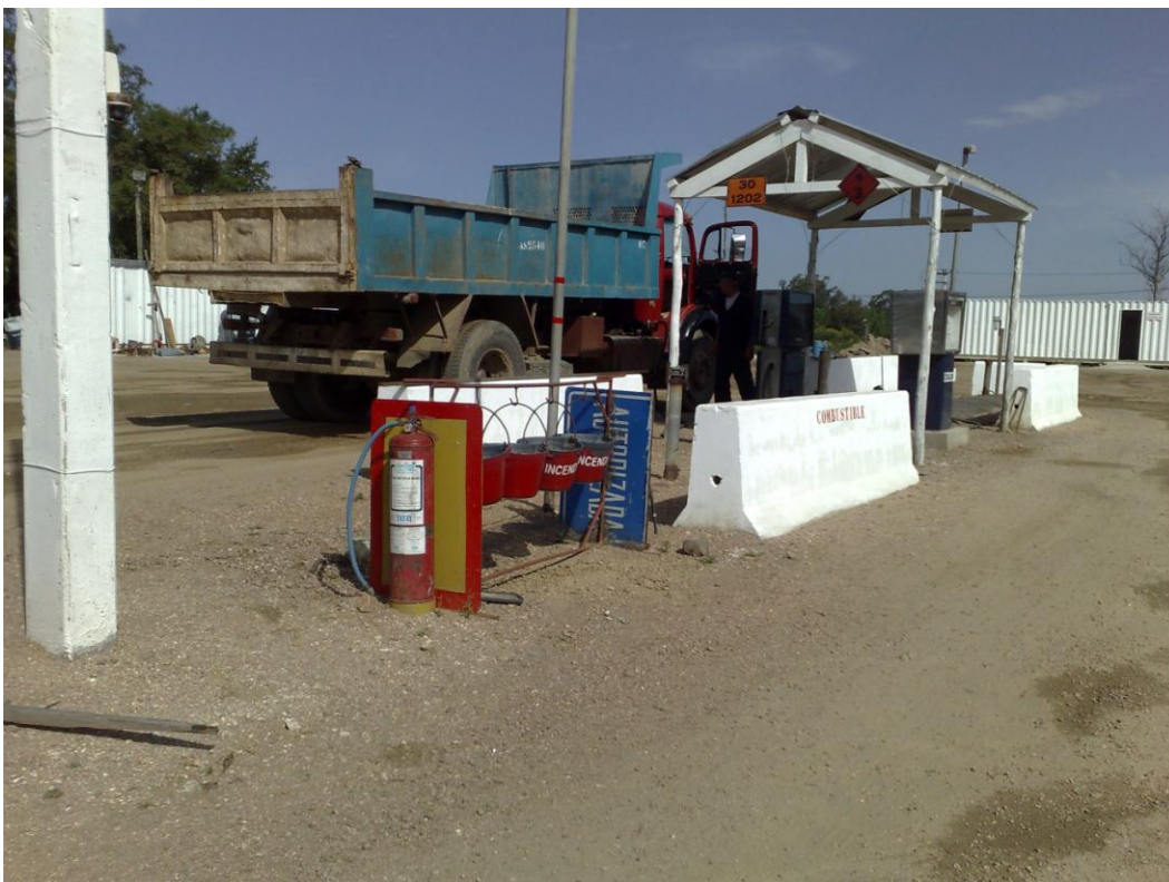
Surtidor de combustibles con dispositivos de seguridad
