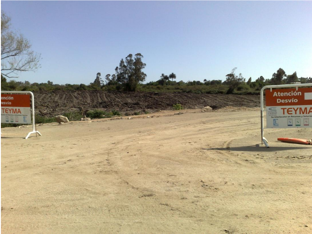
Acondicionamiento de Cauce en Puente Miguelete
