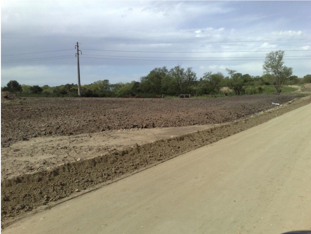
Acondicionamiento de faja
