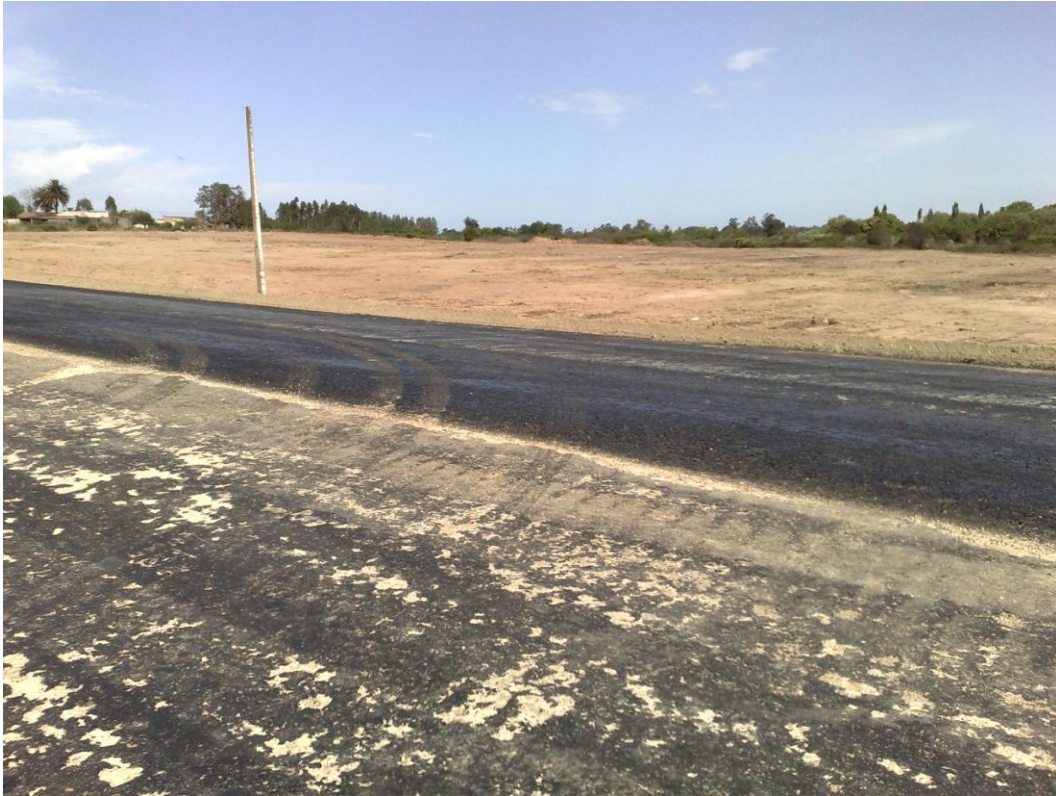
Acondicionamiento de faja.
