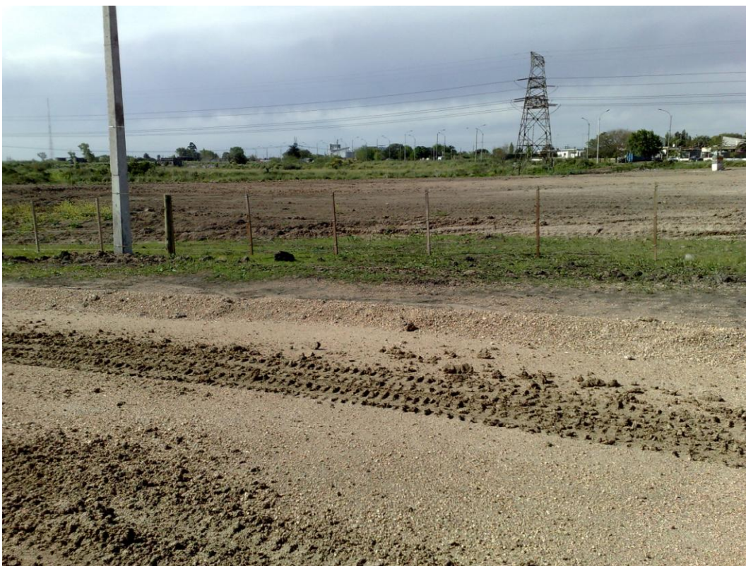
Relleno de terrenos expropiados por acuerdo con MTOP
