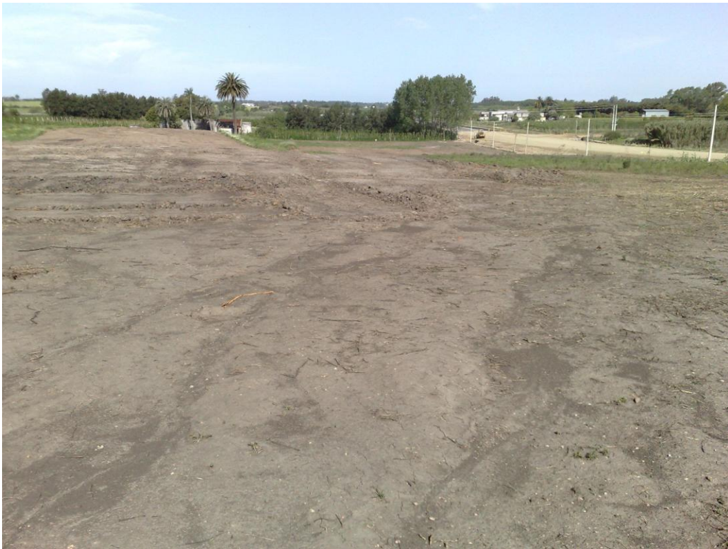
Acondicionamiento de faja
