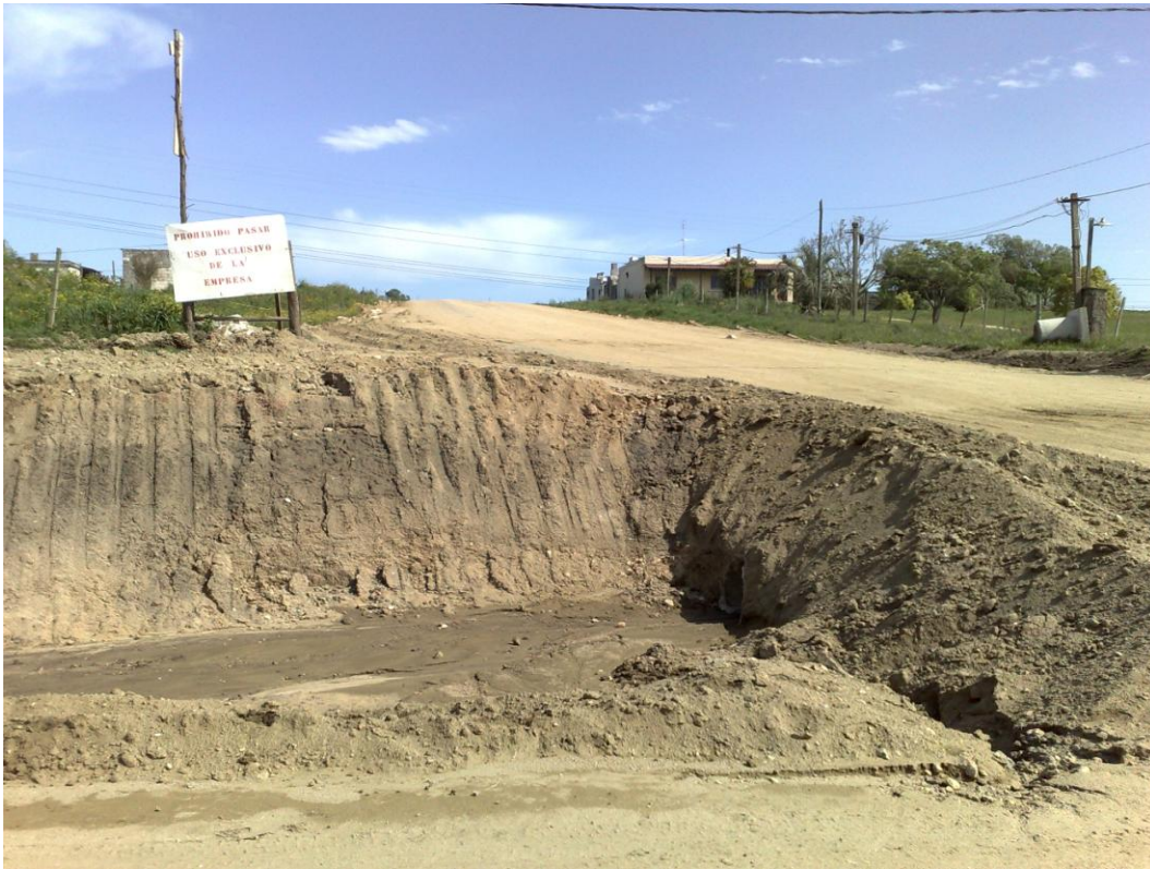
Camino prximo a obrador Colier SA.
