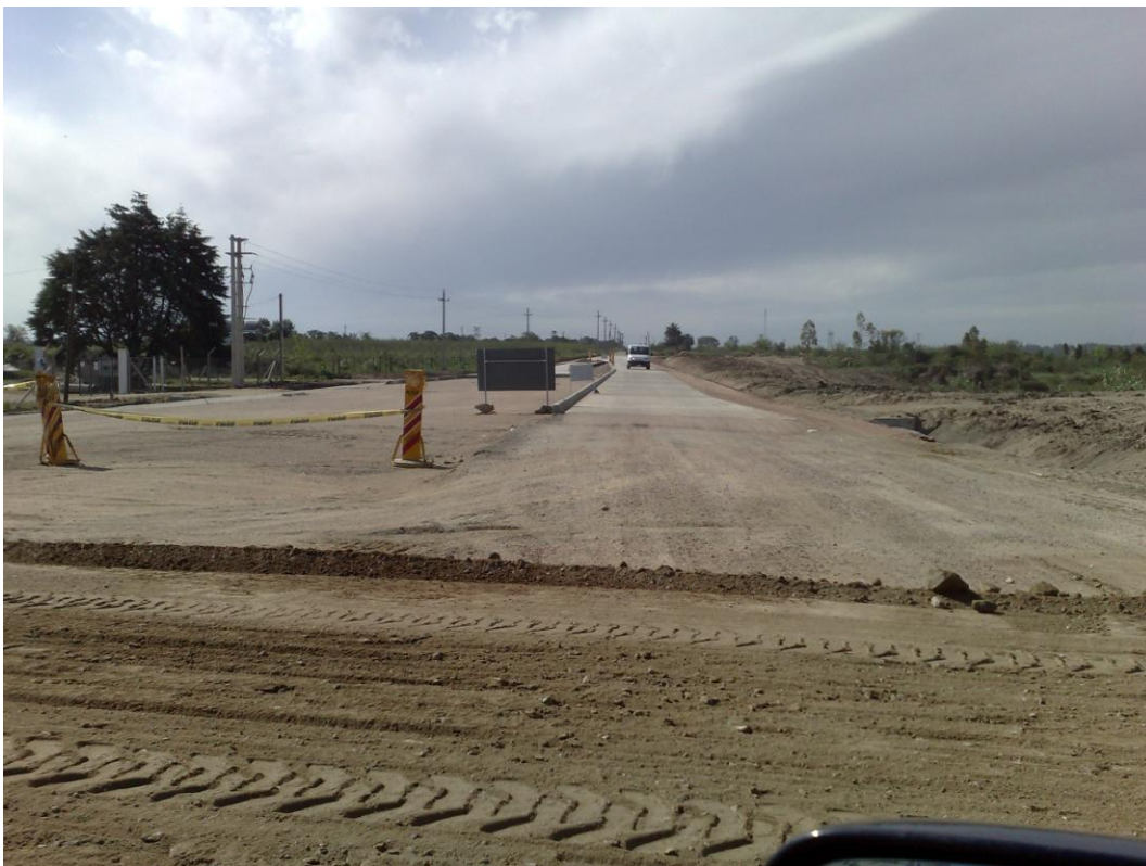
Empalme Cnel. Raíz habilitado en media calzada
