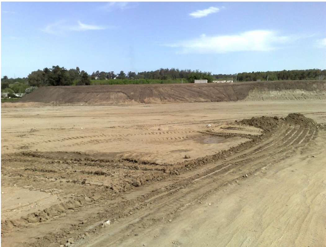
Acondicionamiento de material de destape formando taludes para favorecer el empastado.
