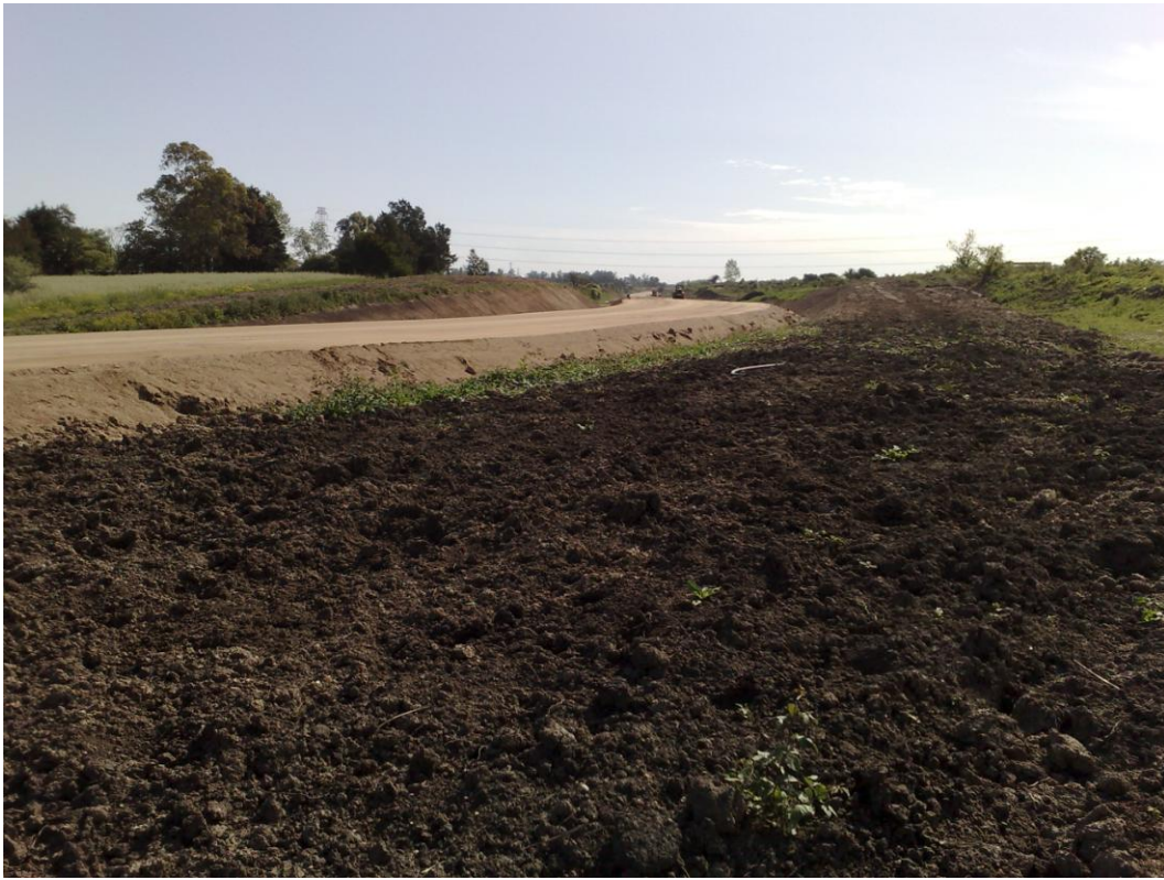
Acondicionamiento de faja
