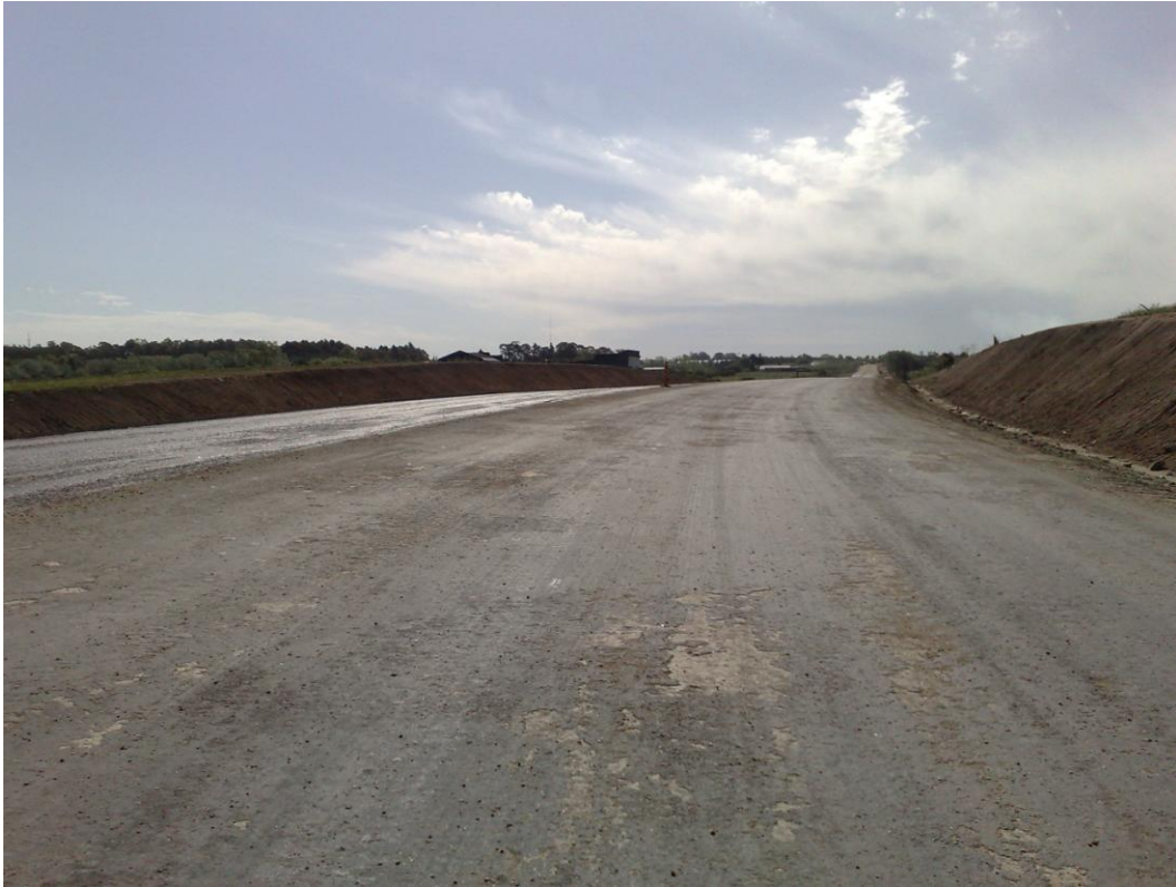
Conformación de taludes.
