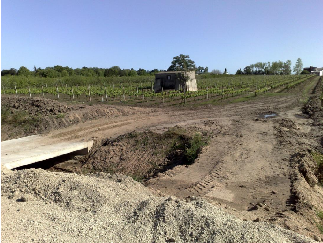
Alcantarilla y calzada Pasa Vacas en Cañada Dragón
