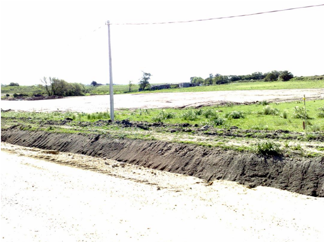
Conformación de Cunetas y acondicionamiento de faja
