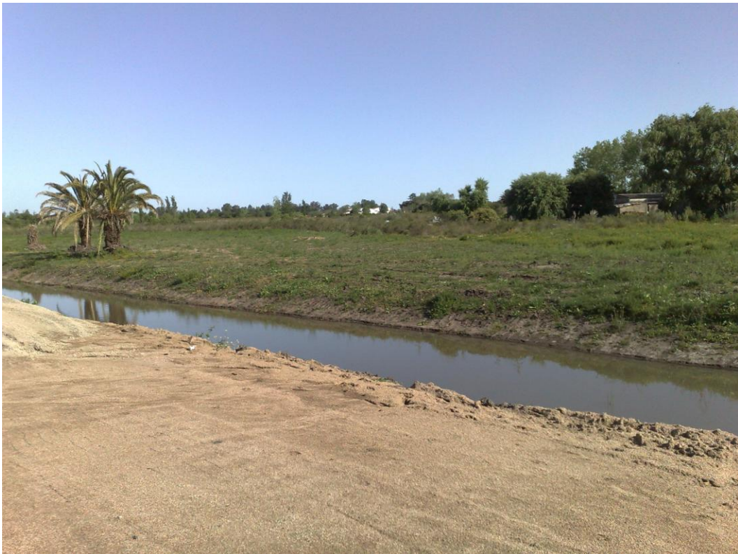
Canalización de Cañada Dragón
