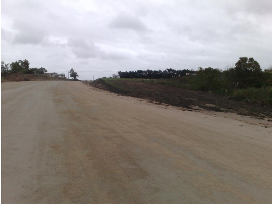
Taludes recortados y revestidos
