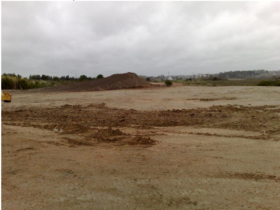
Acopio de tierra negra para futuros revestimientos
