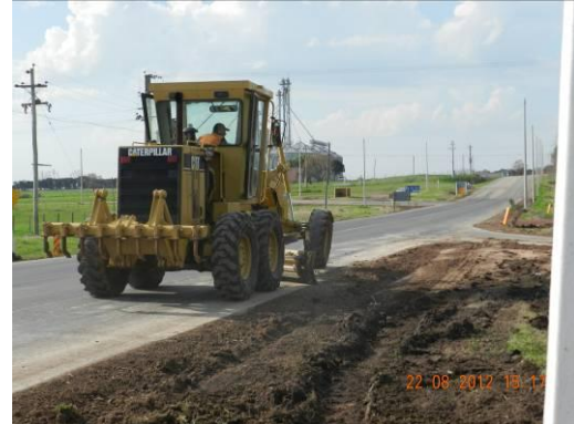
Ilustración 5: Motoniveladora calzando la carretera
