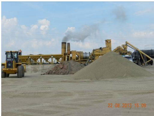
Ilustración 6: Planta de asfalto trabajando
