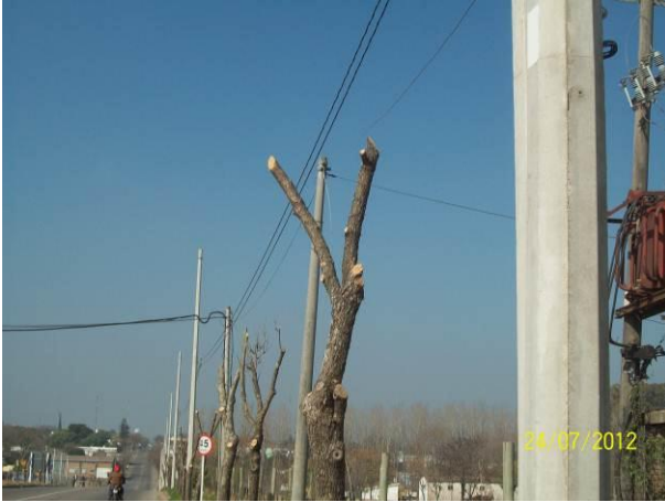
Ilustración 3 – tendido aéreo del cableado
