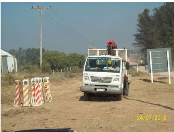
Ilustración 7 – maquinaria y materiales junto al frente de obra
