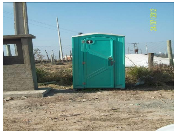
Ilustración 8 – baño químico junto al frente de obra
