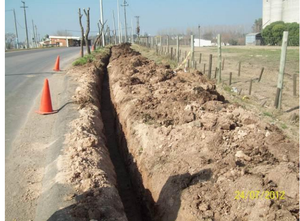
Ilustración 4 – frente de obra
