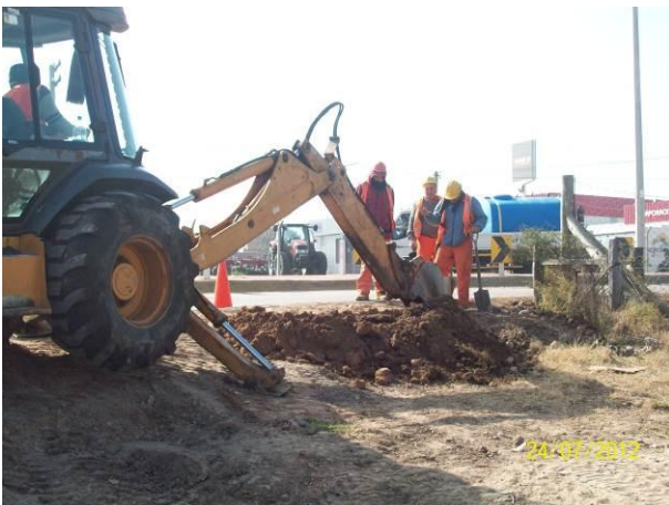
Ilustración 5 – frente de obra
