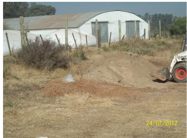
Ilustración 6 – acopio de materiales para la obra
