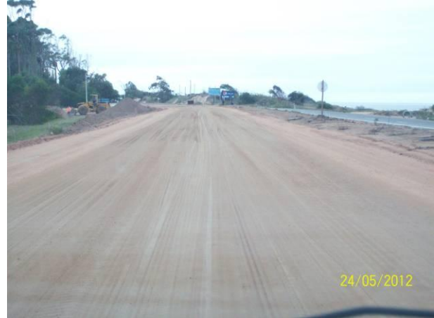
Ilustración 5 – obras en calzada norte
