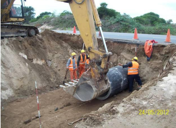
Ilustración 4 – frente de obra
