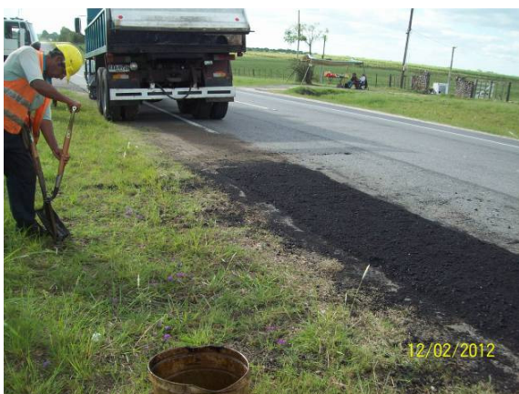
Ilustración 17: Frente de obra en progresiva 88K000 – sellado de fisuras en banquina
