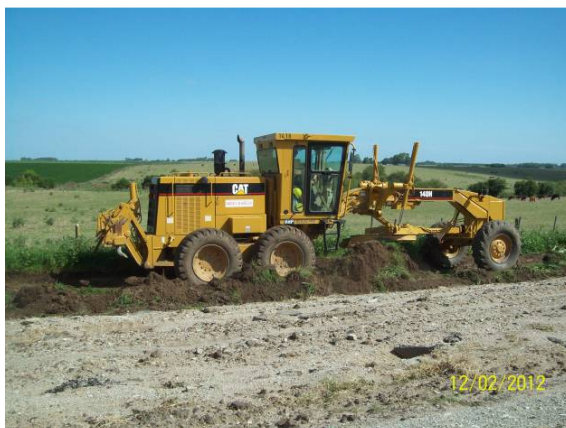
Ilustración 16: Frente de obra – colocación de la subbase
