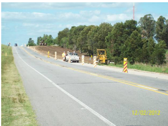
Ilustración 15: Frente de obra en progresiva 150K000.
