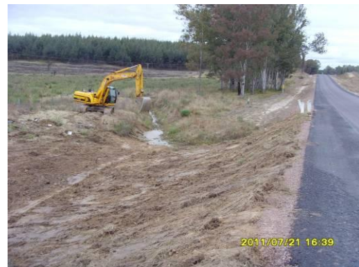
Ilustración 14: Corrigiendo el drenaje en un curso de agua
