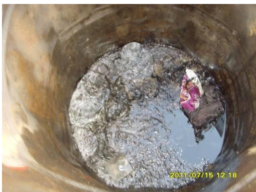
Ilustración 7: Generación de efluentes por la lluvia y por falta de tapas de los recipientes de residuos
