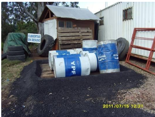
Ilustración 5: Sitio de aceites usados con dique y cubiertas en desuso sin protección de la lluvia
