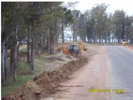
Ilustración 13: Corrigiendo drenajes en la faja
