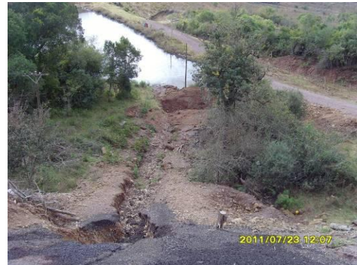
Ilustración 10 – Suelo con presencia de contaminantes y zanja donde escurre el efluente de lavado de equipos y cambio de aceites.
