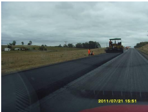
Ilustración 11: Colocando carpeta asfáltica
