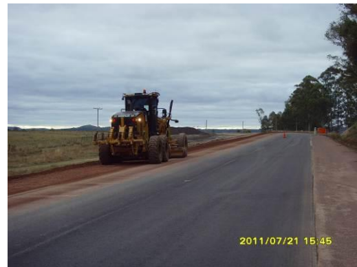
Ilustración 12: Nivelando banquetas
