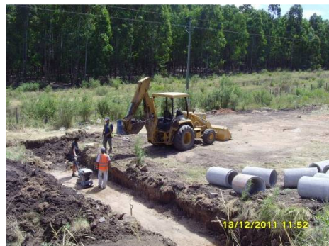
Ilustración 16: Construcción de alcantarilla
