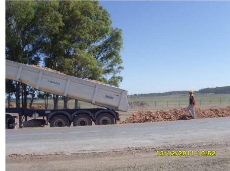
Ilustración 6: Carga de la sub-base granular
