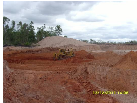
Ilustración 8: Extracción de limo en cantera
