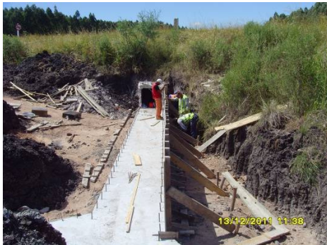
Ilustración 11: Construcción de alcantarilla
