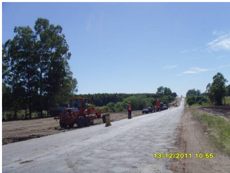
Ilustración 7: Obras de ensanche del terraplén
