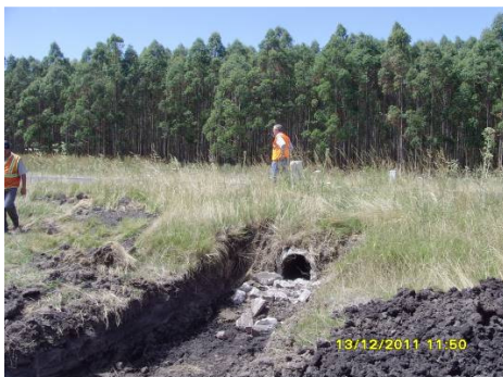
Ilustración 15: Construcción de alcantarilla
