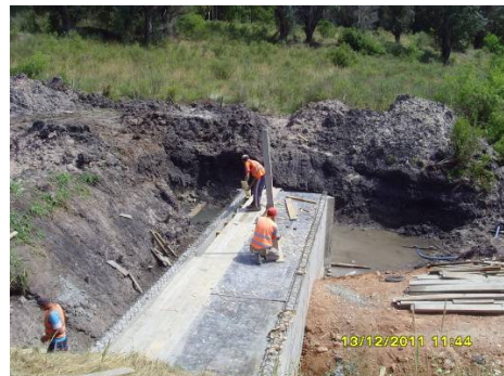
Ilustración 14: Construcción de alcantarilla
