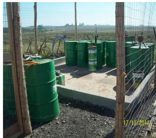
Ilustración 6- Acopio de aceite nuevo y usado
