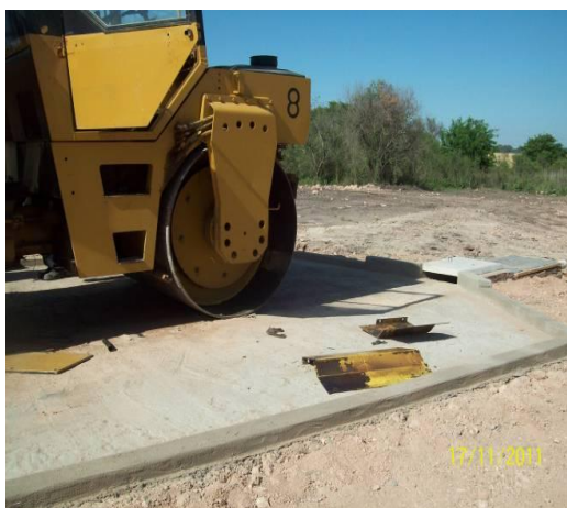
Ilustración 7: sitio para lavado de maquinaria
