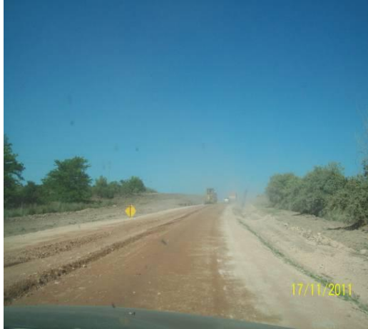
Ilustración 3 – Frente de obra
