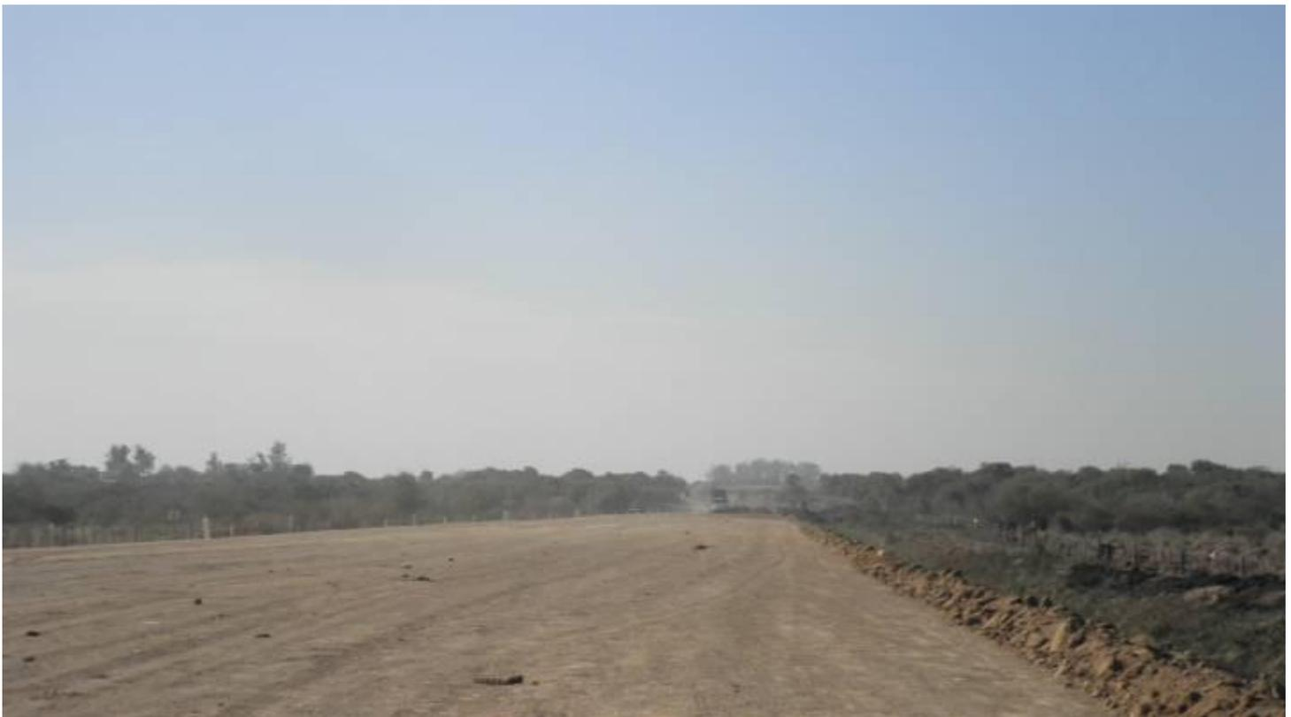
Vista del avance de los movimientos de suelos para conformar los terraplenes de acceso y unión de ambos puentes en construcción. Se observa el acopio del material orgánico y vegetal, para su posterior re utilización en los taludes de los terraplenes.
