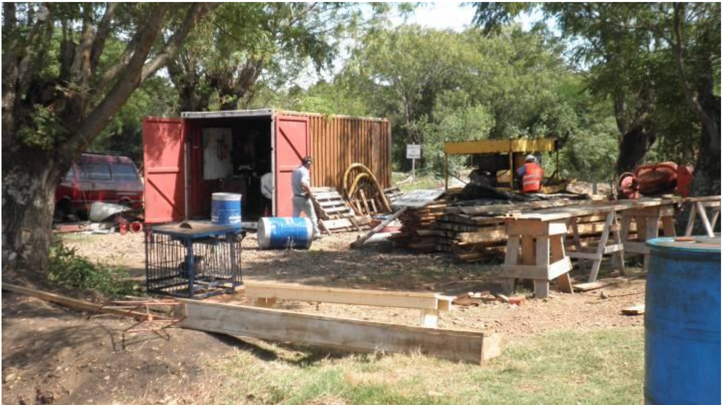
Taller de Mantenimiento
