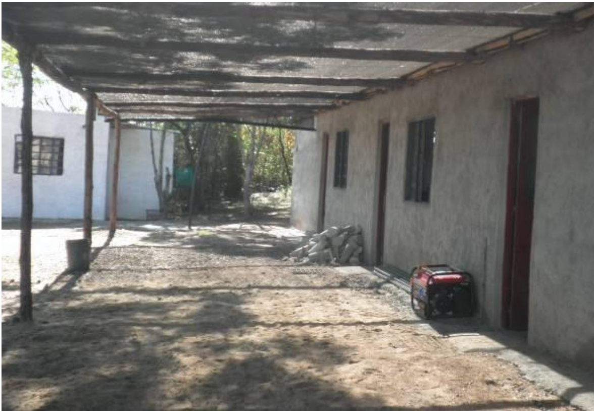
Instalaciones de Laboratorios, oficinas, SSHH, comedor, depósito herramientas, Viv. sereno
