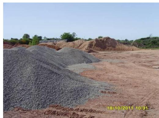
Ilustración 9: Acopios de piedra triturada y tosca en el obrador
