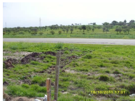
Ilustración 9: Desagüe del pozo negro en la faja pública de la ruta 21, frente al obrador
