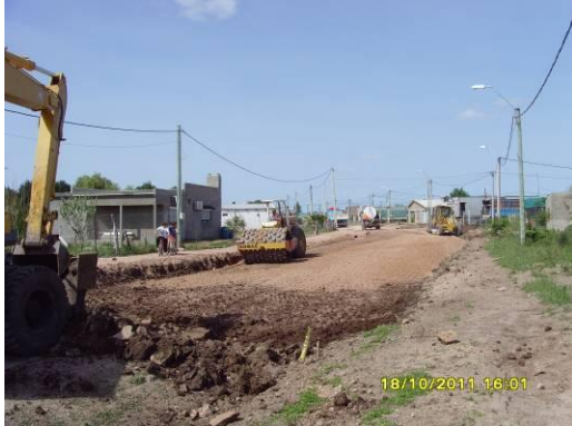
Ilustración 4 – Movimiento de suelos en zona urbanizada
