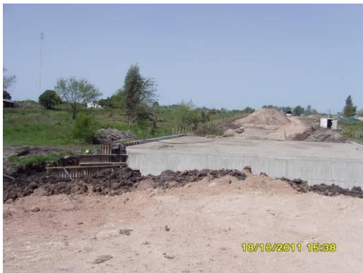
Ilustración 6: Obras en alcantarilla nueva de la Cda. Del Sauce
