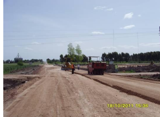
Ilustración 5 – Carga de capa granular y compactación
