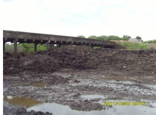
Ilustración 4 – Puente viejo sobre el A° Yucutujá y ataguías para el nuevo puente
