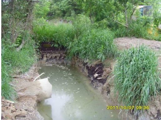
Ilustración 9 : Sedimentador asociado a la plataforma de lavado del “camión mixer”
