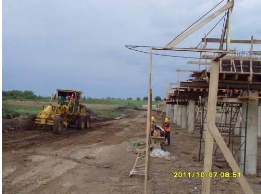
Ilustración 3 – Obra del puente sobre el sangrador del A° Yucutujá
