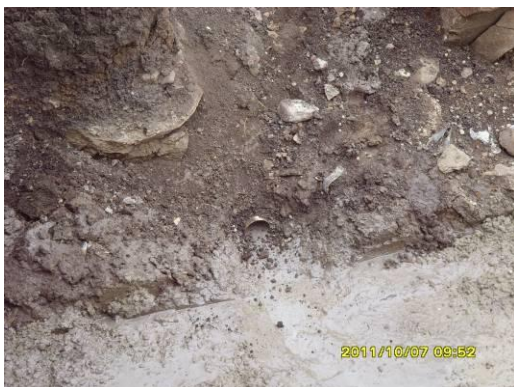
Ilustración 13: Tubo de drenaje del pozo donde se ubica el mixer para cargar, debajo de la planta de hormigón, y que descarga en una zanja próximo al curso
