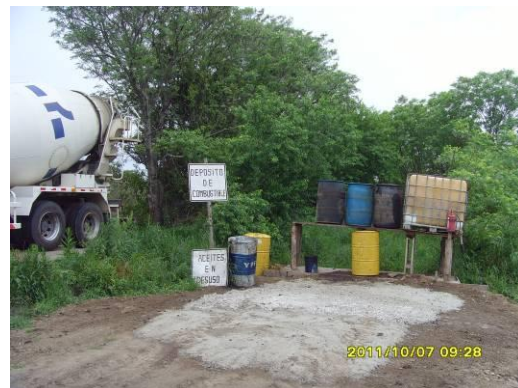
Ilustración 6: Lubricantes usados y combustibles sin contención de derrames ni impermeabilización del suelo
