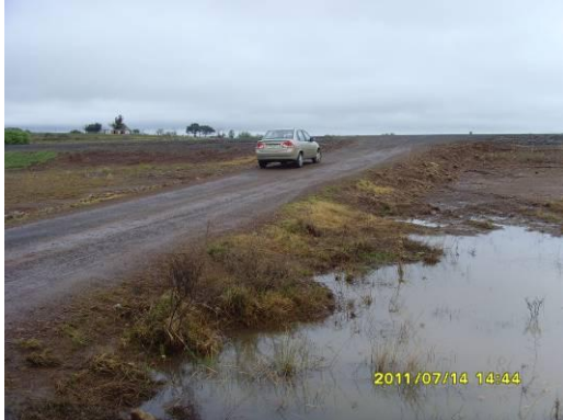
Ilustración 3 – Acceso al obrador sin alcantarilla, cortando el drenaje de la faja
