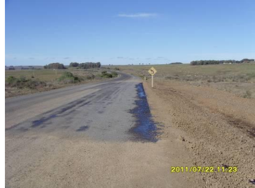
Ilustración 4 – Bache recién reparado con un tratamiento bituminoso
