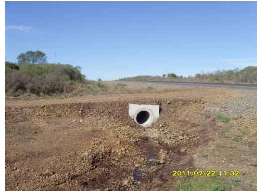
Ilustración 6: Alcantarilla recién terminada
