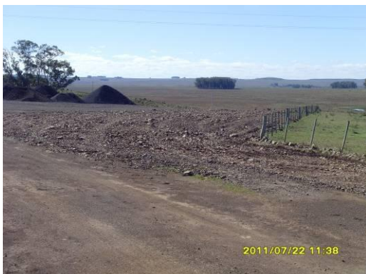
Ilustración 7: Cobertura con materiales del emplazamiento del antiguo obrador
