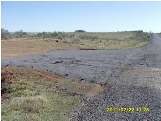
Ilustración 5: Tratamiento bituminoso en acceso a camino
